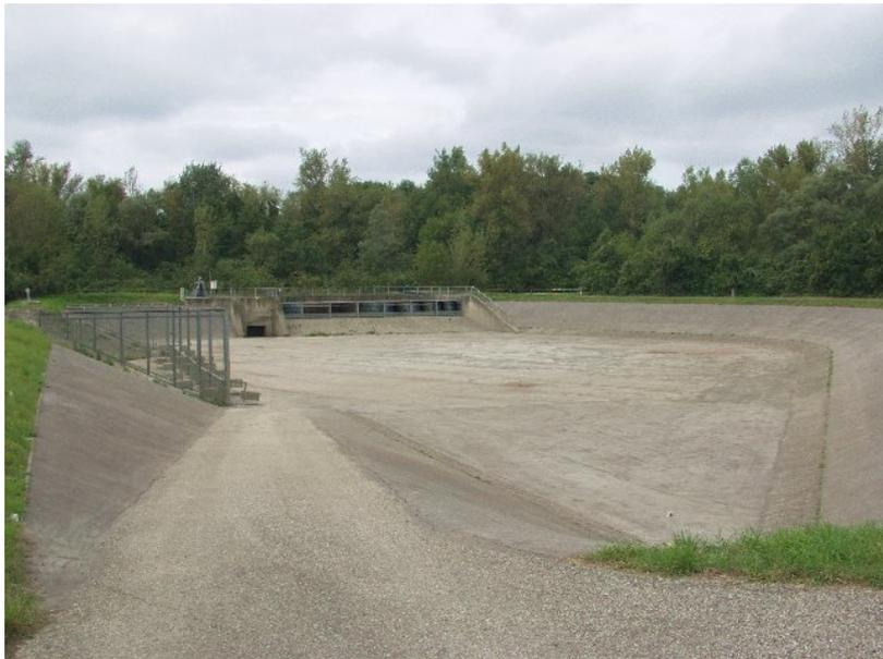
Abbildung 28 - Regenrückhaltebecken in Linz mit 18.000 m<sup>3</sup> Fassungsvermögen (Dergreg, 2005, Wikipedia)
