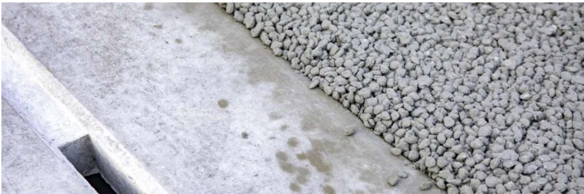
Abbildung 47 - Drainagebeton eingebracht (Fa. Heidelberg materials, 2025, Titelbild)
