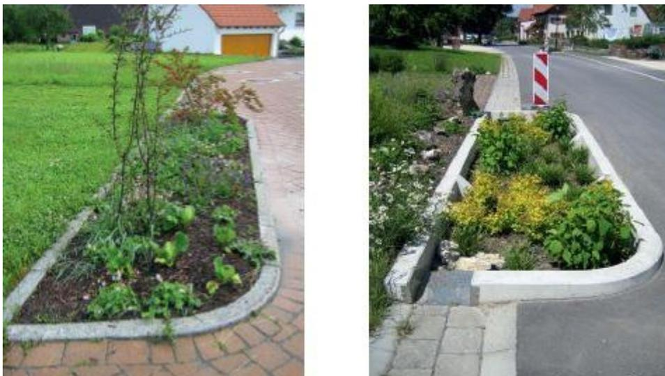
Abbildung 29 - Tiefbeete mit belebter Bodenzone (Mall Umweltsysteme, 2024, S.38, Eigene Adaptierung)
