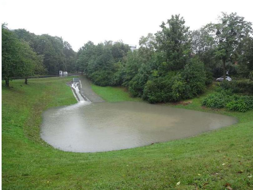
Abbildung 27 - Regenrückhaltebecken in Deutschland mit ca. 3.000 m<sup>3</sup> Fassungsvermögen (Engelhardt, 2015, Wikimedia)
