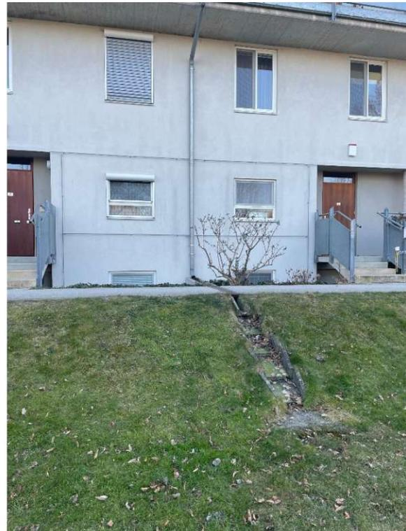
Abbildung 31 - Detail für die Ableitung des Wassers auf die Freifläche (Eigene Aufnahme)
