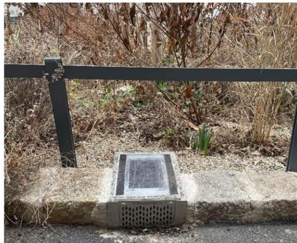
Abbildung 55 - Detail des Schwammsteins
