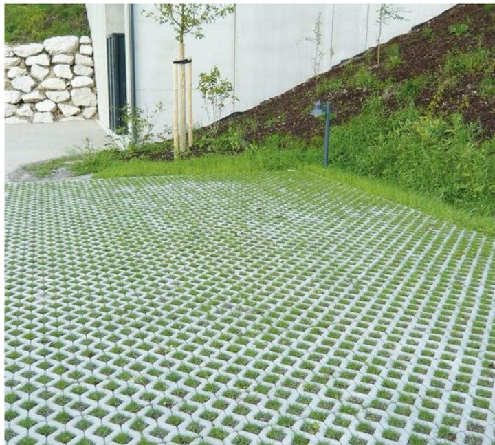
Abbildung 44 - Rasengittersteine als Parkfläche (Fa. Ramböck Betonwerk GmbH, 2025, Abb.1)
