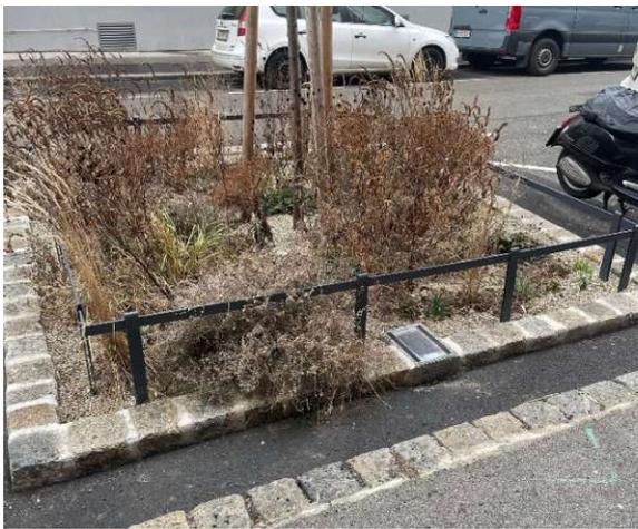
Abbildung 54 - Schwammstein bei einer Baumscheibe in der Flachgasse (1150 Wien)
