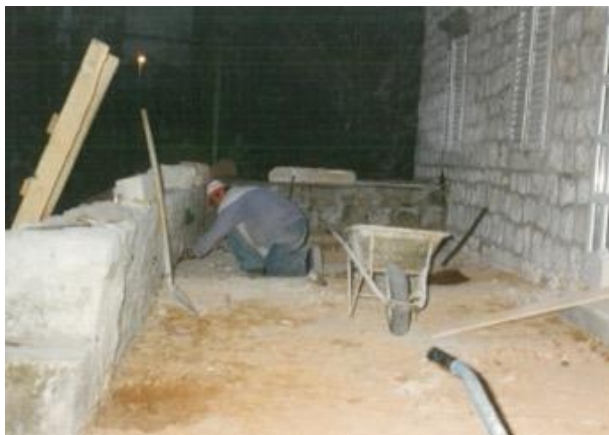
Abbildung 97: Entfernung der Betonunterlage der Terrasse
