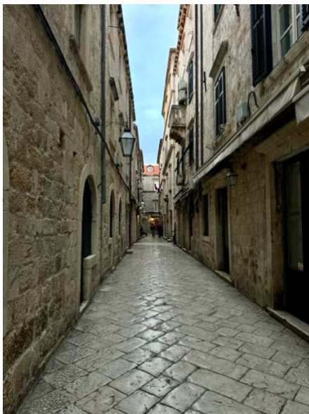
Abbildung 19: Pflasterung der Straße
