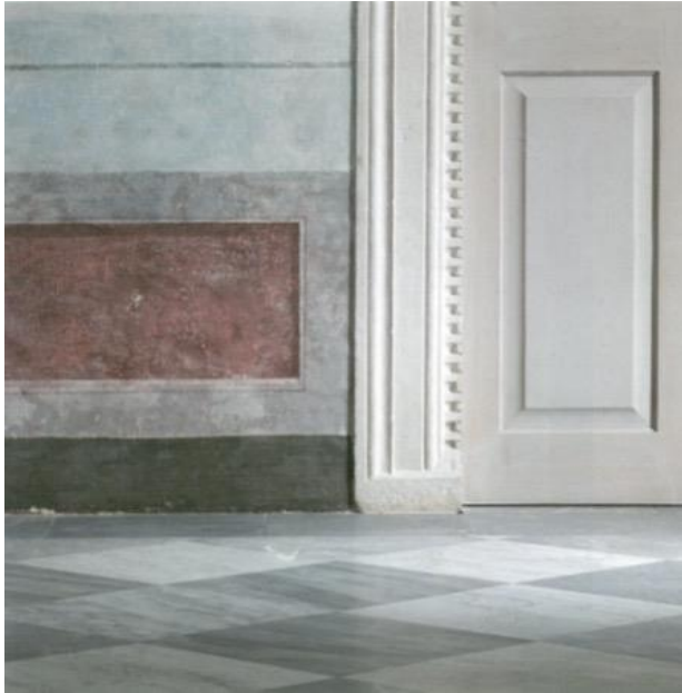
Abbildung 73: Bemalung des Parapetes der Halle nach der Restaurierung
