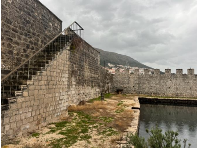
Abbildung 37: Treppe von der Terrasse des Sorkočević Landhauses
