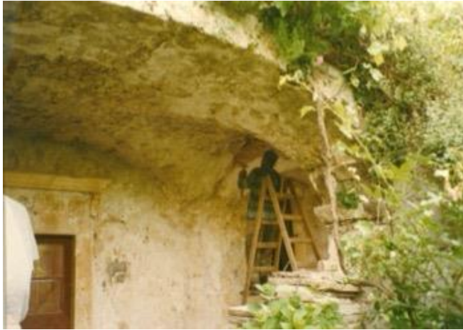
Abbildung 91: Abschalgen des Putzes von den Gewölbe
