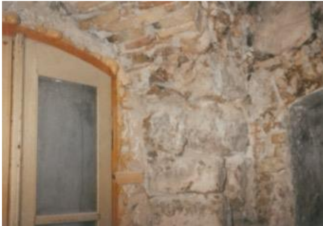
Abbildung 89: Zustand der Wände vor der Restaurierung
