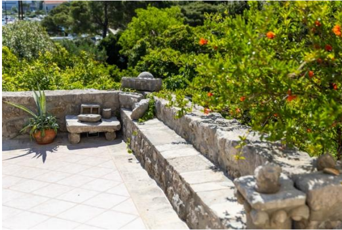
Abbildung 100: Mauerkrone und Sitzbank nach der Sanierung
