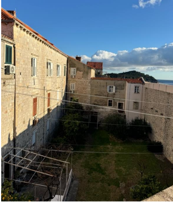
Abbildung 25: Stadthäuser innerhalb der Stadtmauern
