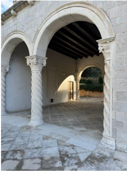
Abbildung 76: Loggia am westlichen Ende der Frontfassade im Jahr 2025.
