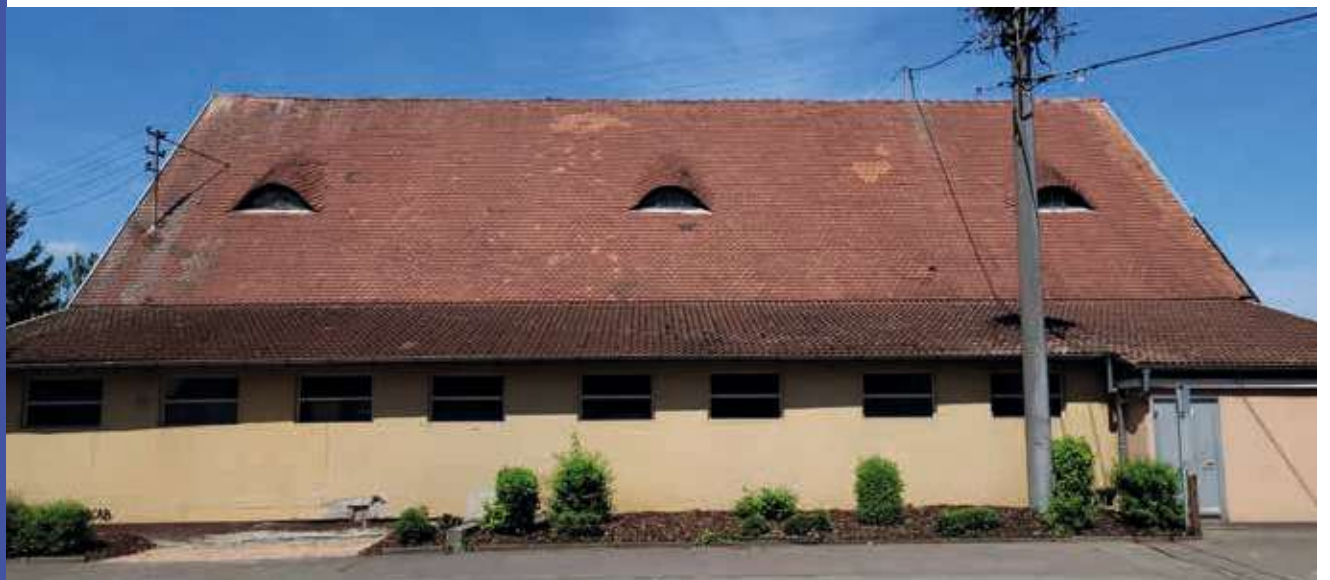
Abb. 128 - Ansicht Bauhof vom Dorfplatz
