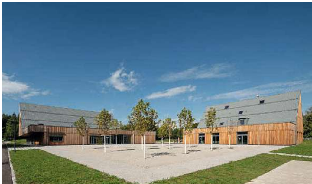
Abb. 73 - beccult - Außen - Vorplatz
