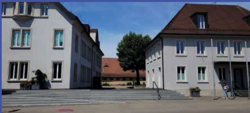
Abb. 138 - Zugangssituation Süd-Ost Zugang
