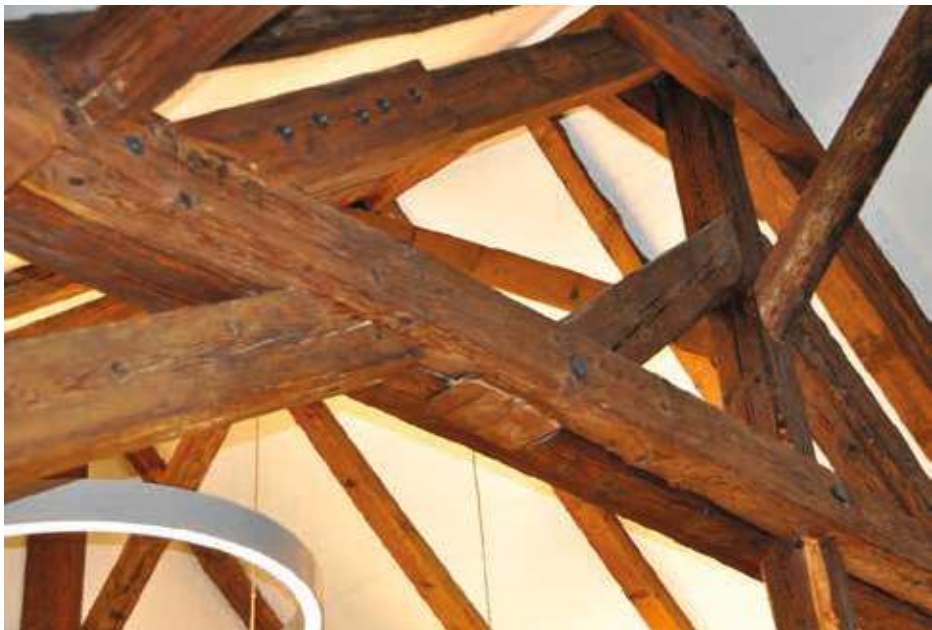
Abb. 93 - Haus der Vereine Thalheim - Versammlungsraum - Tragwerk
