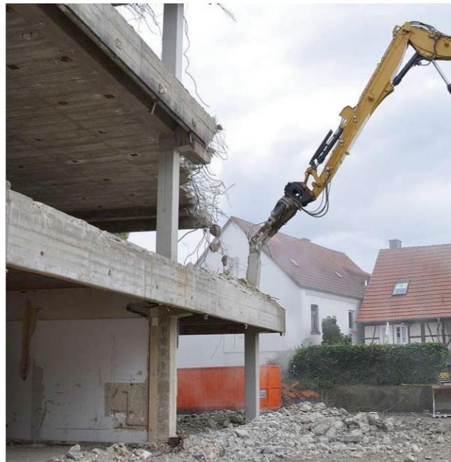
Abb.32 Abbriss des Anbaus aus 1970, das 95% aus mineralischen Baustoffen bestand
