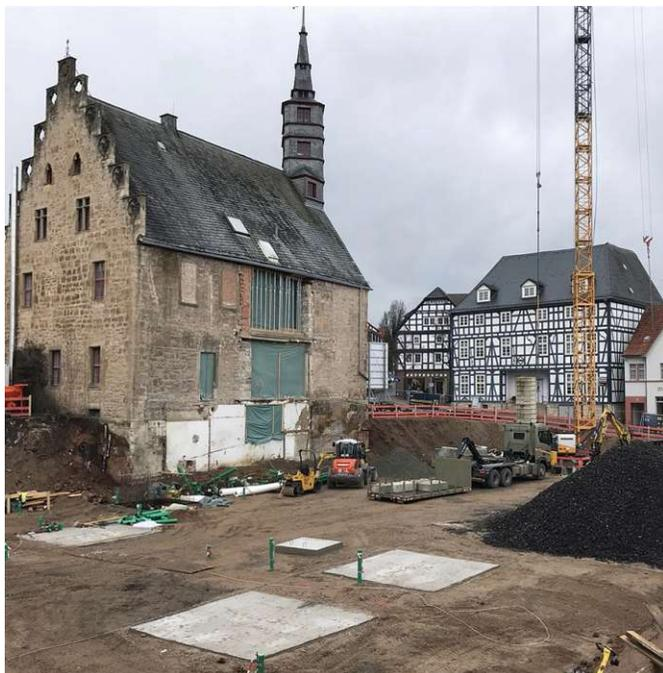
Abb.34 Baustellenbild - Vorbereitung der Baugrube für die Verlegung von Schaumglasschotter
