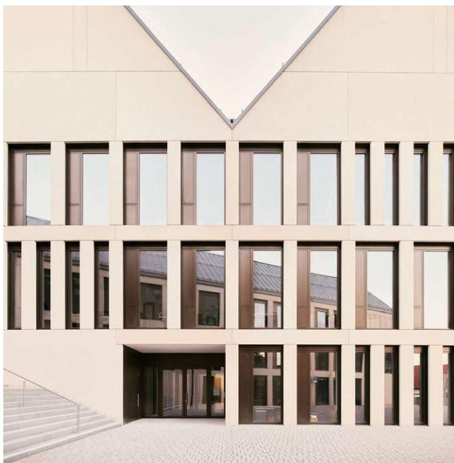
Abb.35 Fensterelemente mit breiteren Fensterfalzen um einen einfachen Abbau zu ermöglichen
