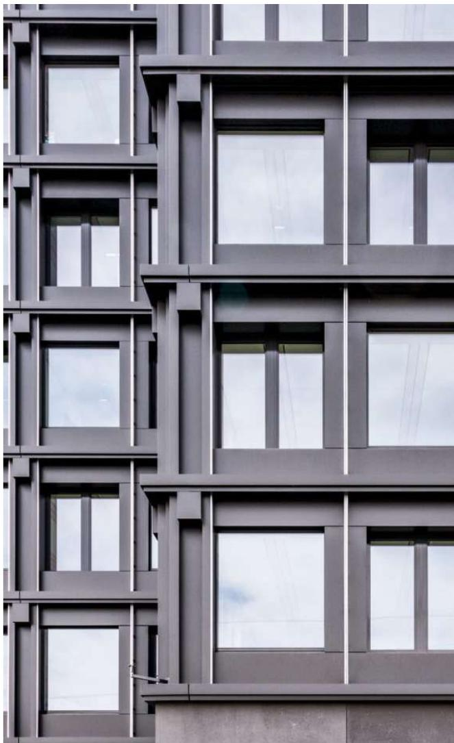
Abb.27 Fassadengestaltung mit Alucobond-Verbundplatten zur sicheren Erfüllung der Brandschutzvorgaben für Hochhäuser
