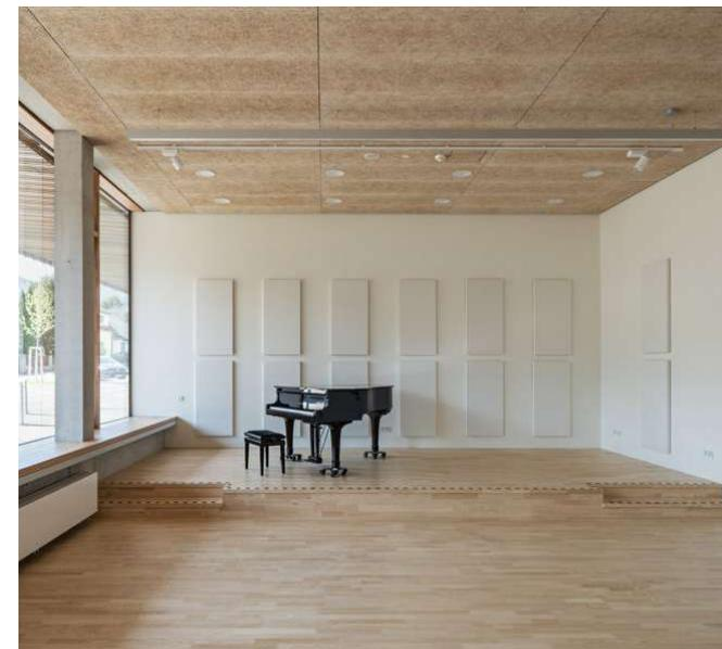
Abb. 10 Musikraum, Einsatz von Akustikpaneelen an der Rückwand und seitlich zum Gangbereich, sowie abgehängte Decke aus Holzwole-Akustikplatten
