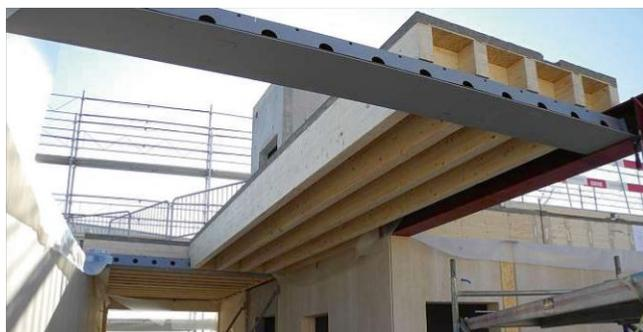
Abb.18 Baustellenbild, Aufstellung der Fertigteile der HBV-Decke
