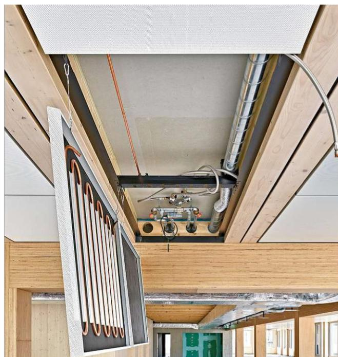
Abb.25 Vormontierte HKLS-Installationen und Sprinkleranlagen, System Erne - Suprafloor Ecoboost
