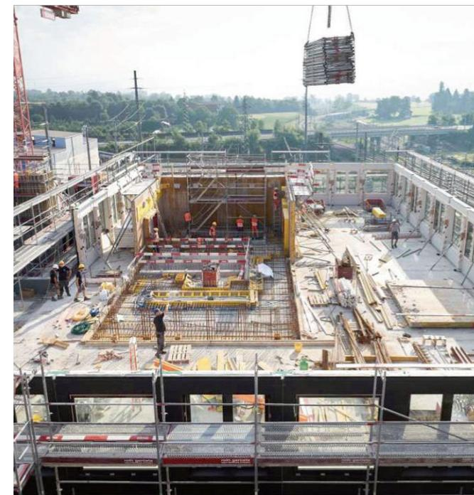
Abb.19 Baustellenbild, Montage der Aussenwände und Bewehrung des STB-Kerns
