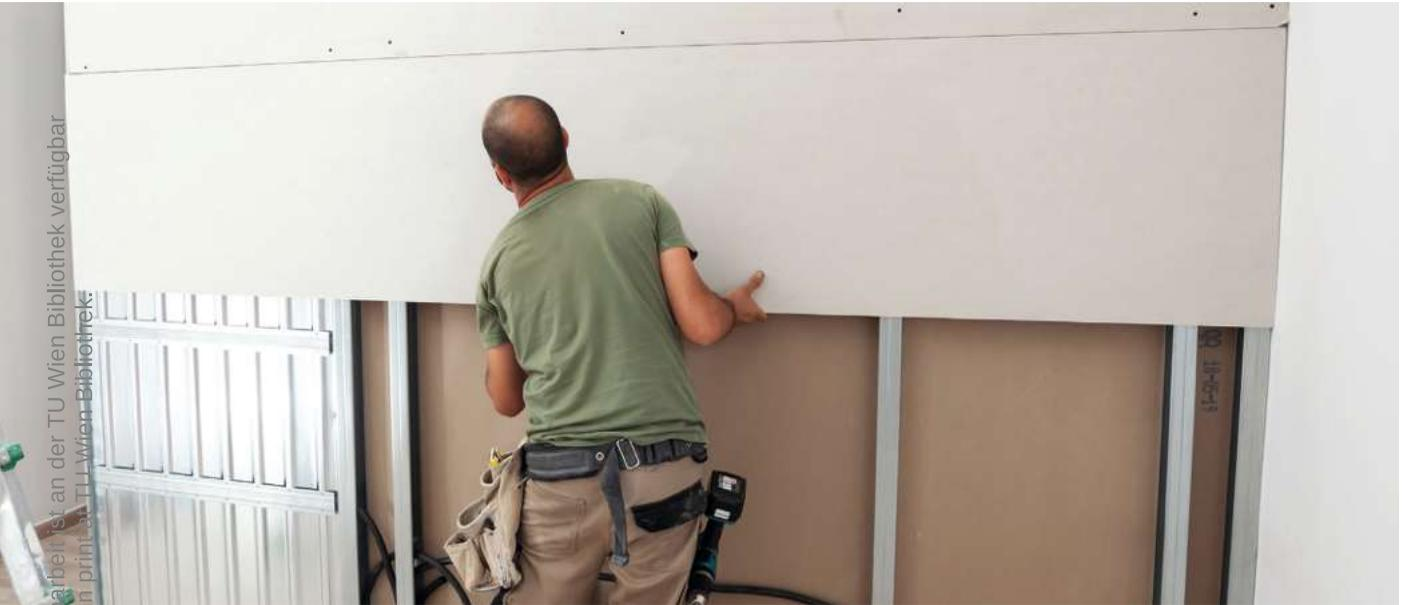
Abb.107: Gipskarton Trennwand
