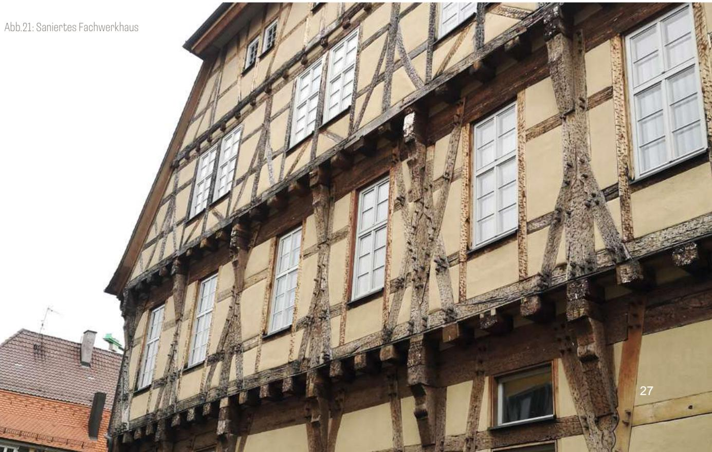
Abb.21: Saniertes Fachwerkhaus
