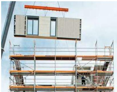
Abb.97: H8 Massivholzkonstruktion
