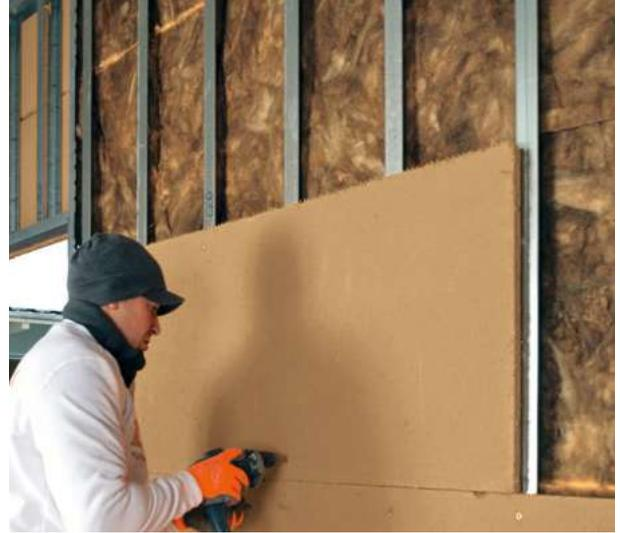
Abb.27: Lehmbauplatten auf Unterkonstruktion aus Metallständern
