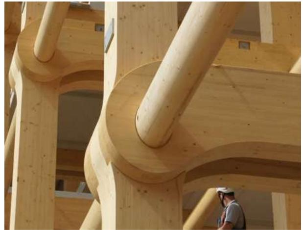
Abb.88: Tamedia-Gebäude, Bausystem von Architekt Shigeru Ban entwickelt
