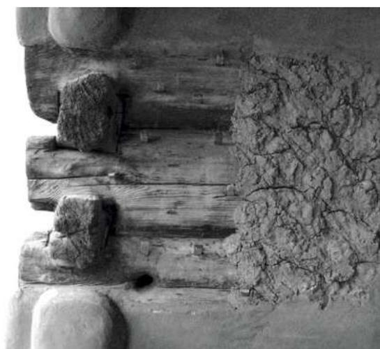
Abb.02: Holzblockwand eines „Kitting“ Speicherbaus mit Holzkeilen als Putzgrund
