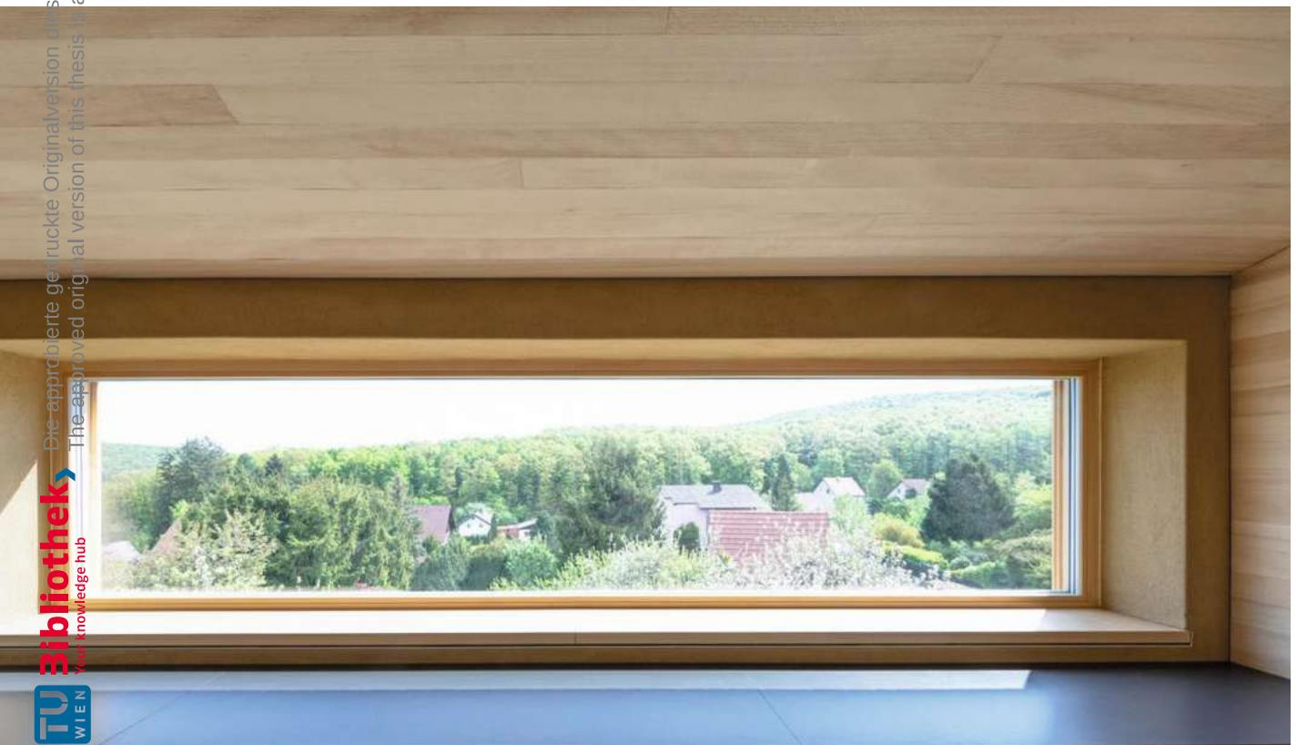
Abb.61: Brettstapelholz Decke, Innenputz aus Lehm
