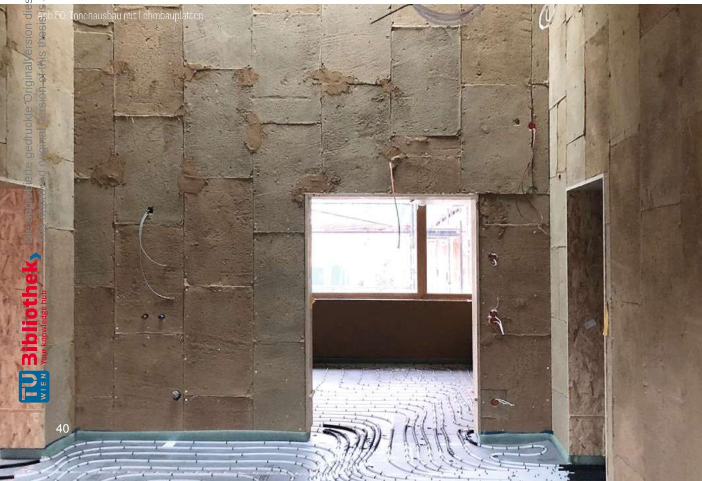
Abb. 50: Innenausbau mit Lehmbauplatten
