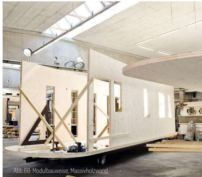
Abb.68: Modulbauweise, Massivholzwand
