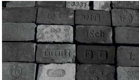
Abb.19: Gestempelte Ziegel aus verschiedenen Fabriken
