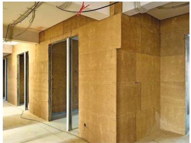
Abb.29: Trockenbau mit Lehmbauplatten
