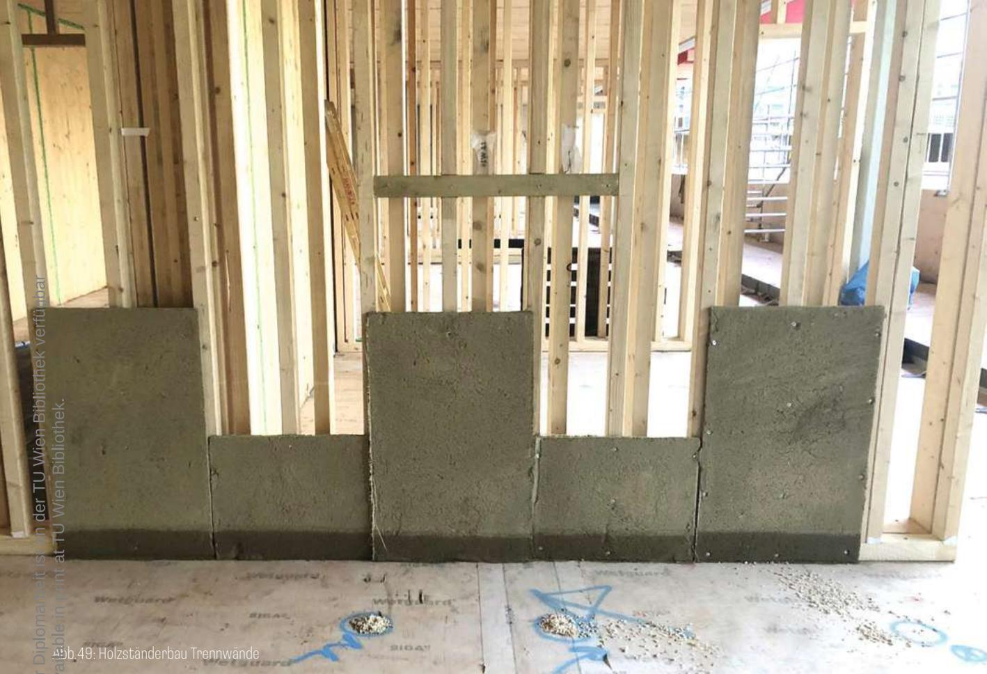
Abb. 49: Holzständerbau Trennwände
