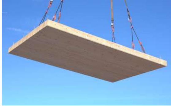
Abb.80: Brettstapel Massivholzelement
