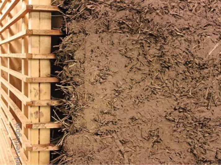
Abb.26: Leichtlehm Holzständerkonstruktion
