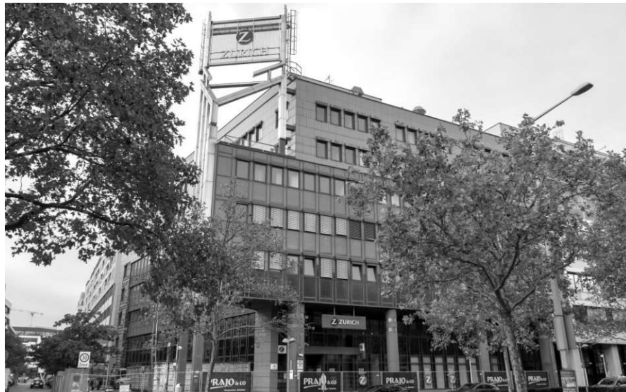
38. Zurich Bürogebäude abgerissen
