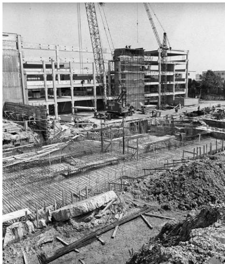
Abb. 34 Baustelle Konstruktion ORF Zentrum
