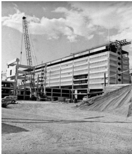
Abb. 33 Baustelle Konstruktion ORF Zentrum
