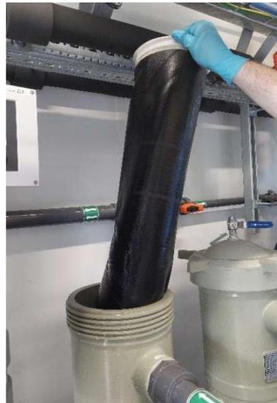
Abbildung 18: verschmutzter Beutelfilter
