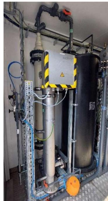
Abbildung 12: Vorlagebehälter (schwarz) mit Rohwasser-Vorwärmer und Oxidator
