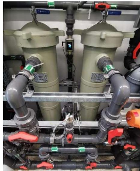
Abbildung 16: Beutelfilter der Anlage
