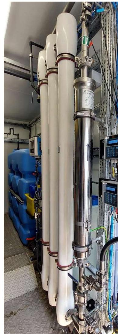
Abbildung 23: Umkehrosmose-Modul in der Pilotanlage
