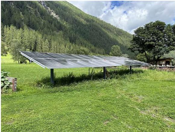
a) Fertige PV - Anlage bei 25 - 30°ostwärts
