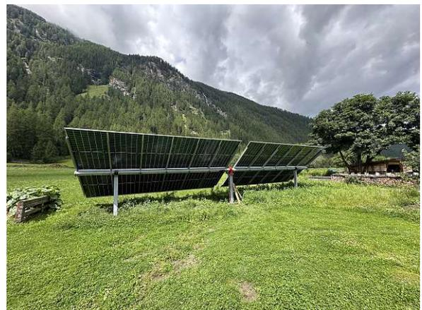
d) Fertige PV - Anlage bei 45°westwärts
