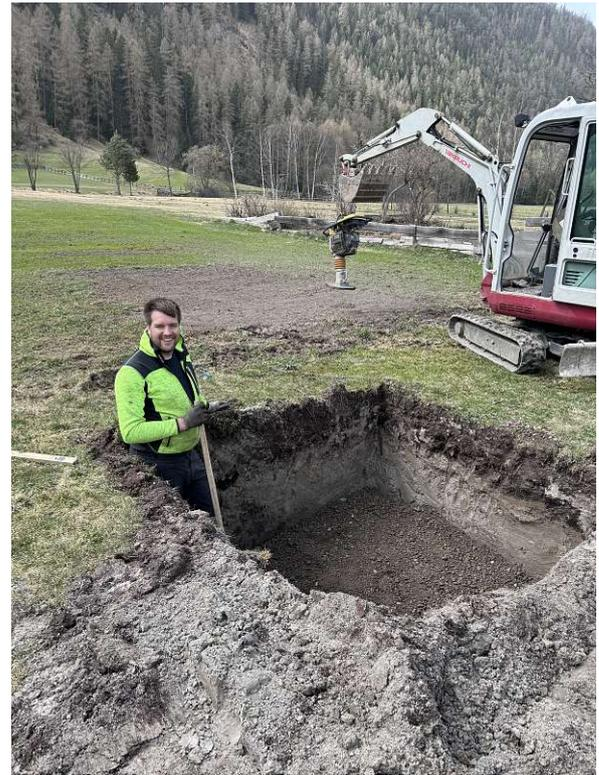
b) Frostkoffer einbringen und Fundamenthöhe einstellen
