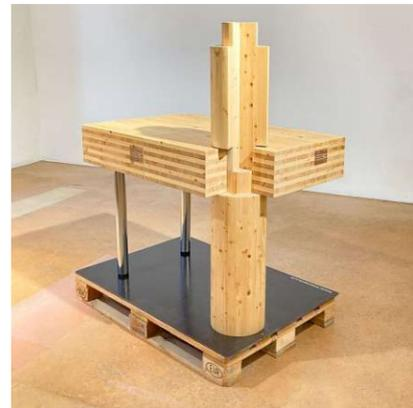
Abb. 121: Stützenanbindung an Holzdecke durch die TS3-Technologie
