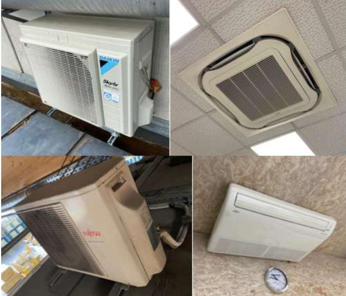
Abbildung 9: KA-22 und KA-64 - Beispiele für eingesetzte Büro- und Aufenthaltsklimageräte
