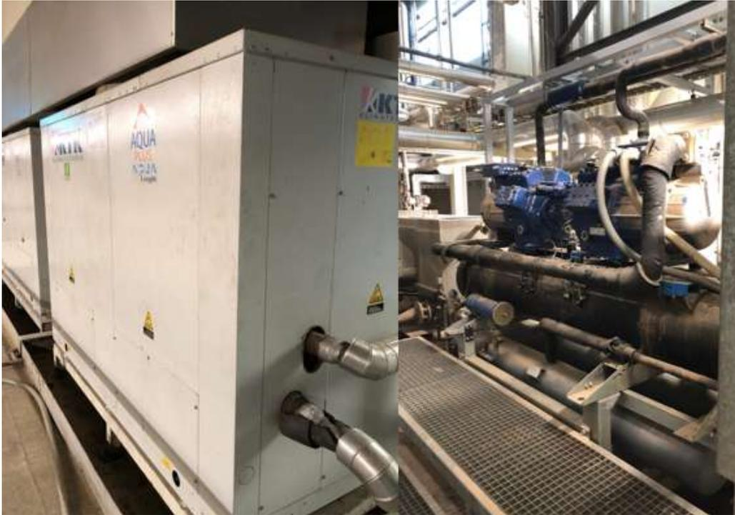
Abbildung 10: KA-05 und KA-10 - zwei Beispiele für Klimageräte, die im Produktionsprozess benötigt werden
