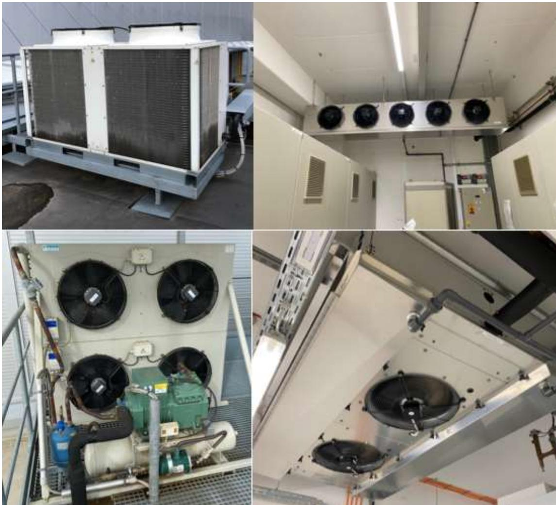
Abbildung 8: KA-07 und KA-66 - Beispiele für typische Schaltraumkühlungen im untersuchten Industriebetrieb
