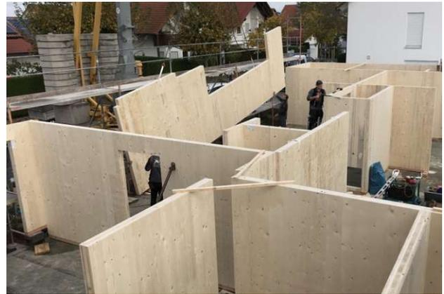
Abbildung 15 Brettsperrholz Montage; Quelle: <https://www.holz-hauff.de/aktuelles/holzhausbau-mit-brettsperrholz/> abgerufen: 30.08.2024
