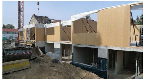
Abbildung 17 Mischbauweise; Quelle: <https://www.proholz.at/zuschnitt/45/wir-benutzen-einfach-gerne-beide-materialien-beton-und-holz> abgerufen: 17.10.2024
