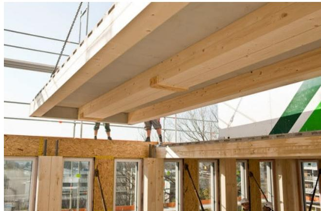
Abbildung 26 HBV Decke LifeCycle Tower; Quelle: <https://www.baunetzwissen.de/imgs/1/5/0/5/2/9/3/f20b-aa467325dae2.jpg> abgerufen: 2.11.2024
