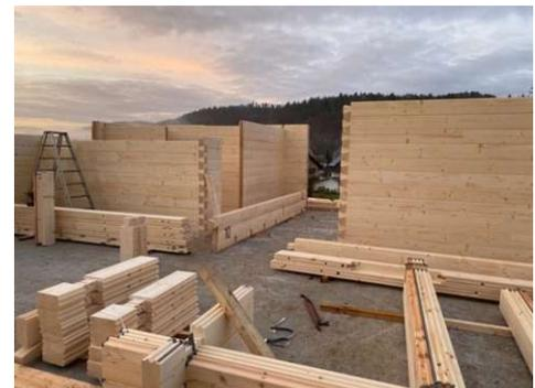
Abbildung 14 Holzblockbau; Quelle: <https://www.remsmurr-holzhaus.de/bauen-mit-holz/blockhausbau/> abgerufen: 30.08.2024
