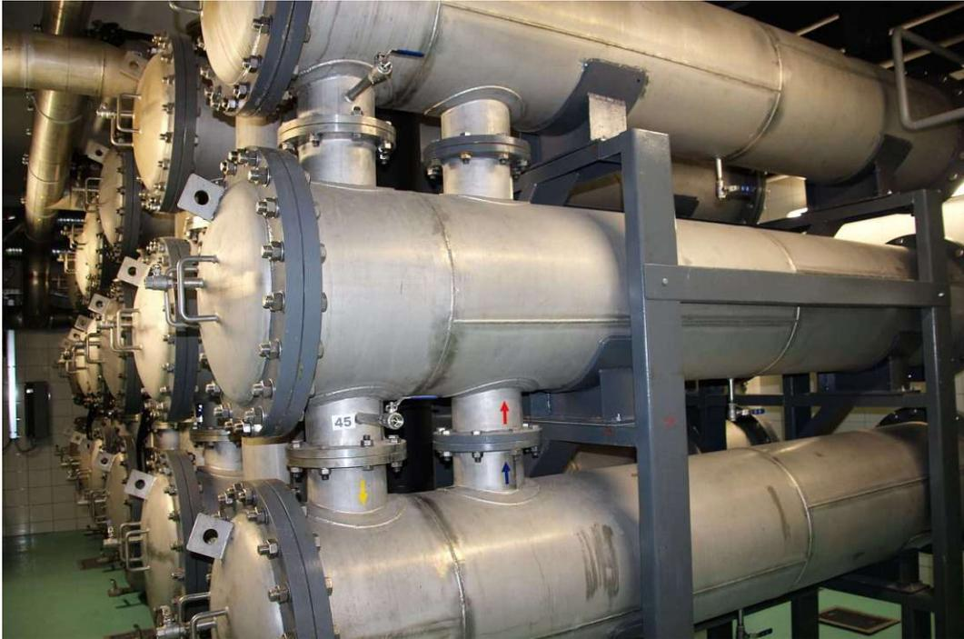
Abbildung 3: Externer Wärmetauscher (Rabmer Management & Beteiligungs GmbH, 2024)
