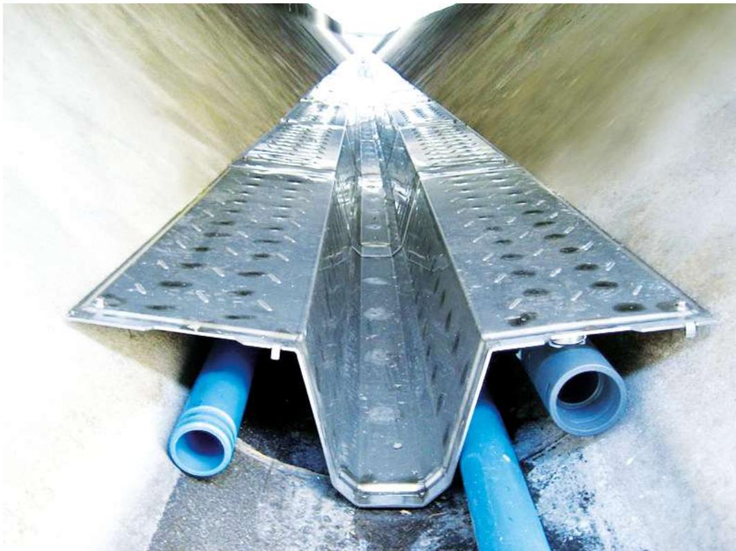
**Abbildung 1: Nachträglich in den Kanalquerschnitt eingebauter Wärmetauscher (Rabmer Management & Beteiligungs GmbH, 2024)**
