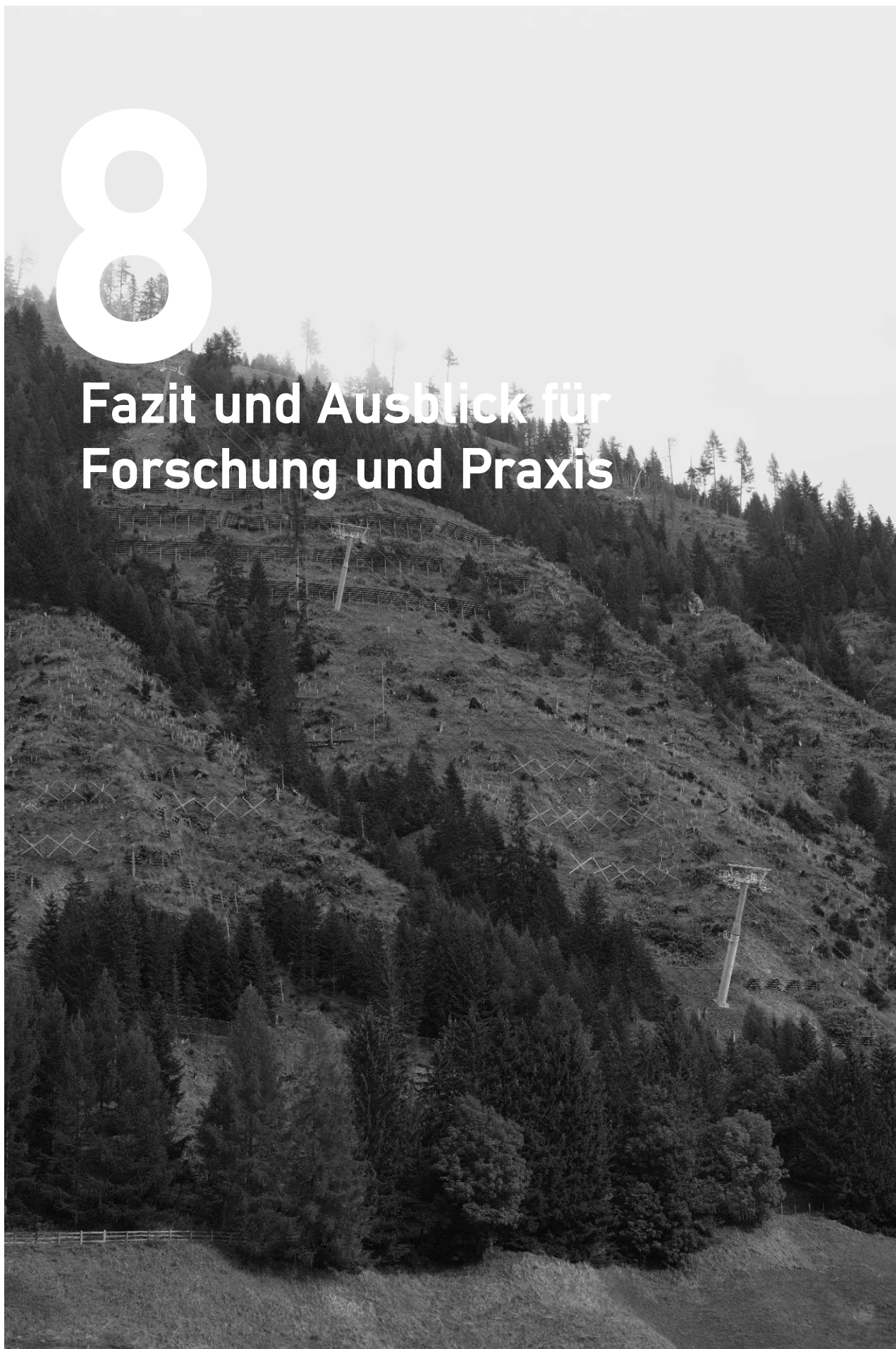
Abb. 57: Lawinverbauung in Kals am Großglockner. Eigene Aufnahme.
