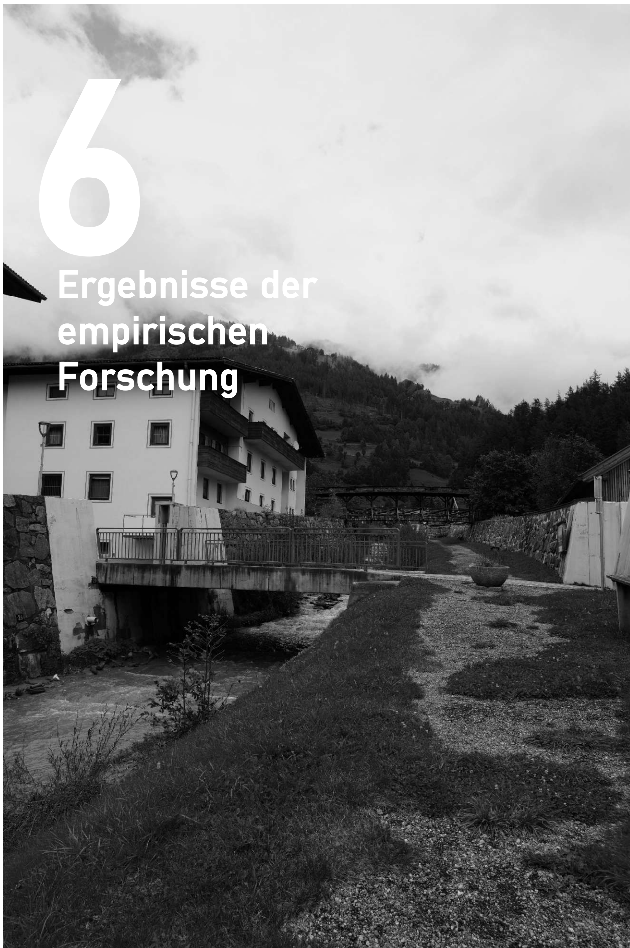
Abb. 8: Wildbachverbauung entlang des Bretterwandbachs in Mauterhorn in Osttirol. Eigene Aufnahme.
