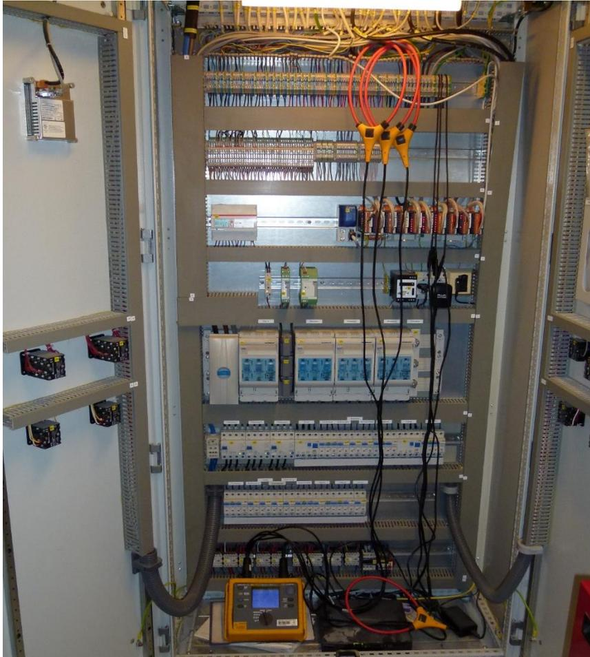
*Abbildung 12 elektrische Leistungsmessung*
