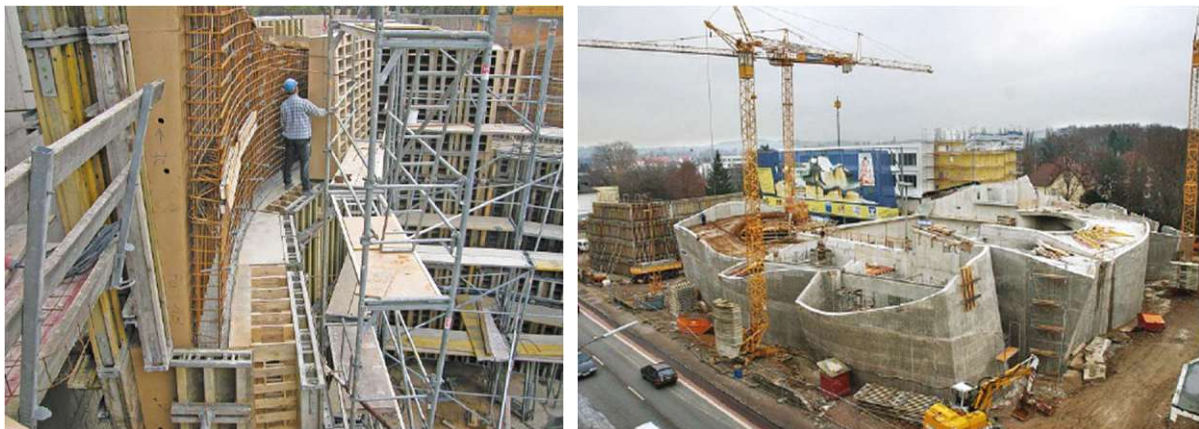
Abb. 42: Rechts: Schalung, Links: Stahlbetonrohbau [38]
