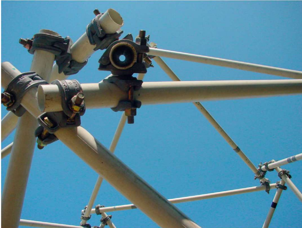
Abb. 31: Anschluss in einer Nexorade-Struktur [34]
