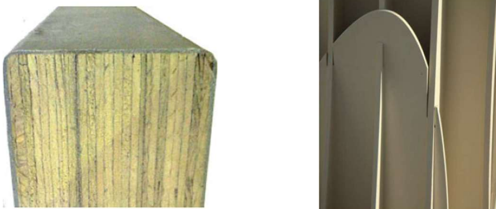
Abb. 53: 2 bis 3 mm dicke PUR-Beschichtung links und beschichteter Stammteil rechts [40]
