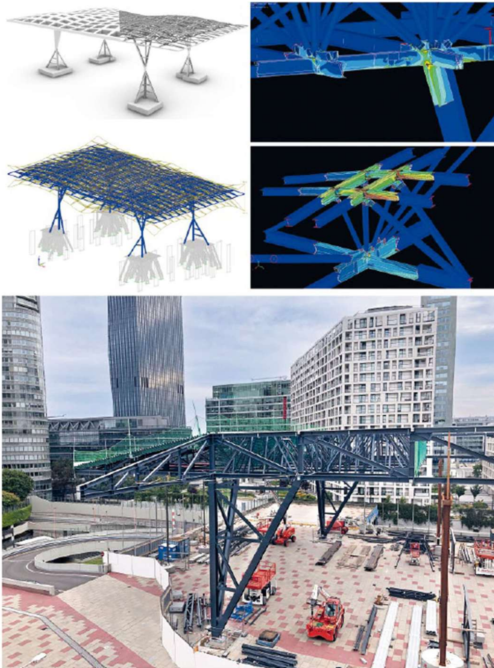
Abb. 11: Erweiterung des Austria Center Wien: Rhino3D und RFEM Modelle (oben) und Tragwerksausführung (unten) [15]
