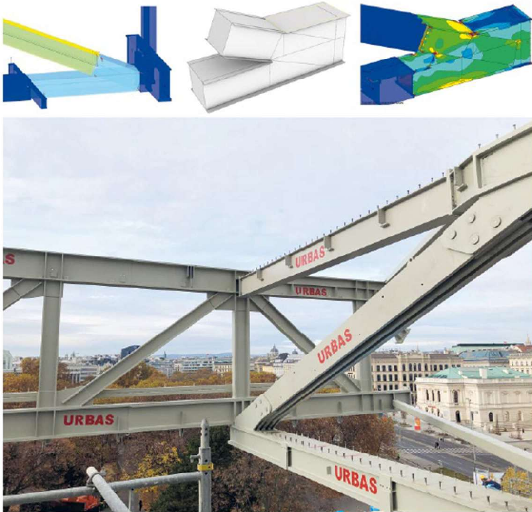
Abb. 10: Wien Museum – Anschlussdetail in Rhino 3D und RFEM (oben), und Ausführung (unten) [15]
