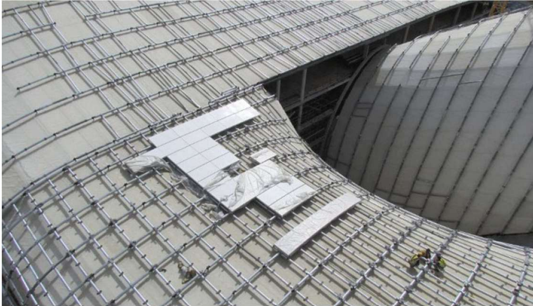
Abb. 70: Montage von Primär- und Sekundärpfetten mit Befestigungspunkten [44]
