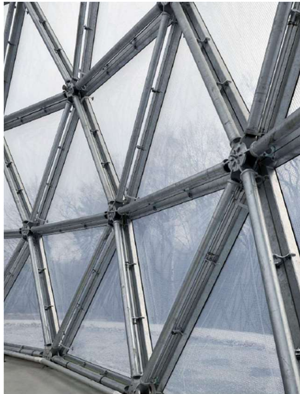
Abb. 38: Gitterschale Mitoseum Bautzen [36]
