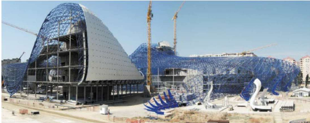
Abb. 69: Montage der äußeren Gebäudehülle [44]
