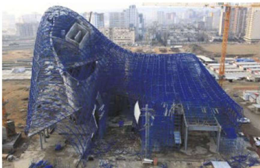
Abb. 68: Montage der Gebäudehülle [44]
