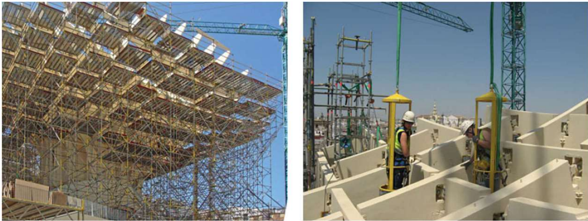
Abb. 55: Abgetrepptes Gerüst links und Montage der Stämme rechts [40]
