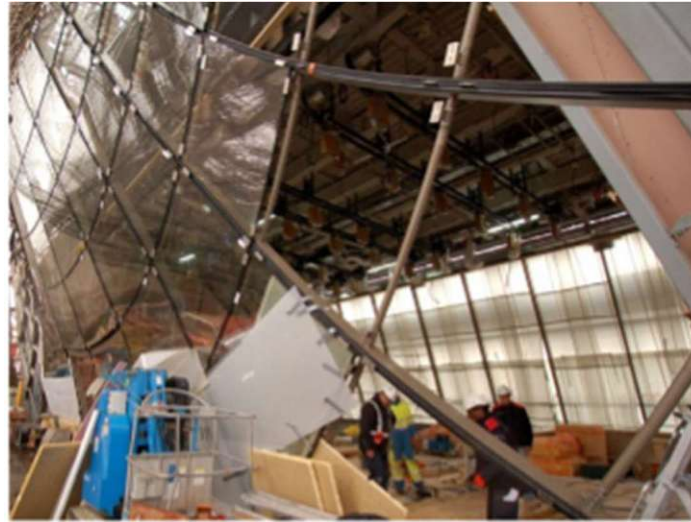
Abb. 33: Montage von Eiffelturmpavillons [35]
