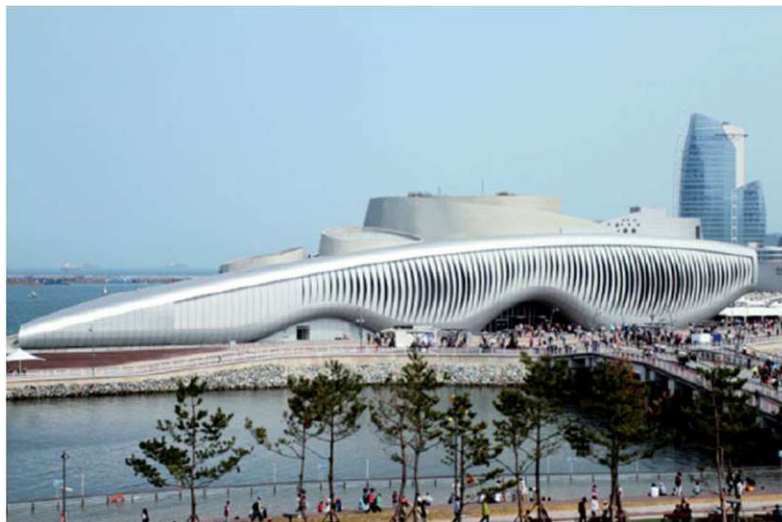
Abb. 59: Fassade Themenpavillon „One Ocean“ [42]
