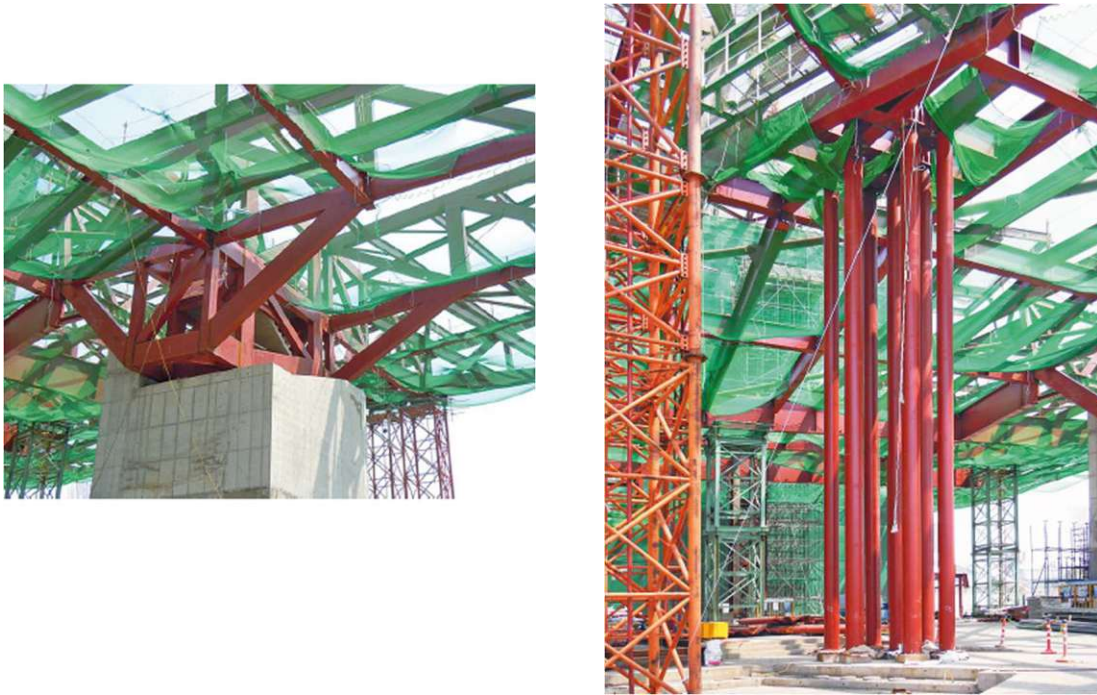
Abb. 37: Auflagerrahmen rechts, Stützencluster links [37]
