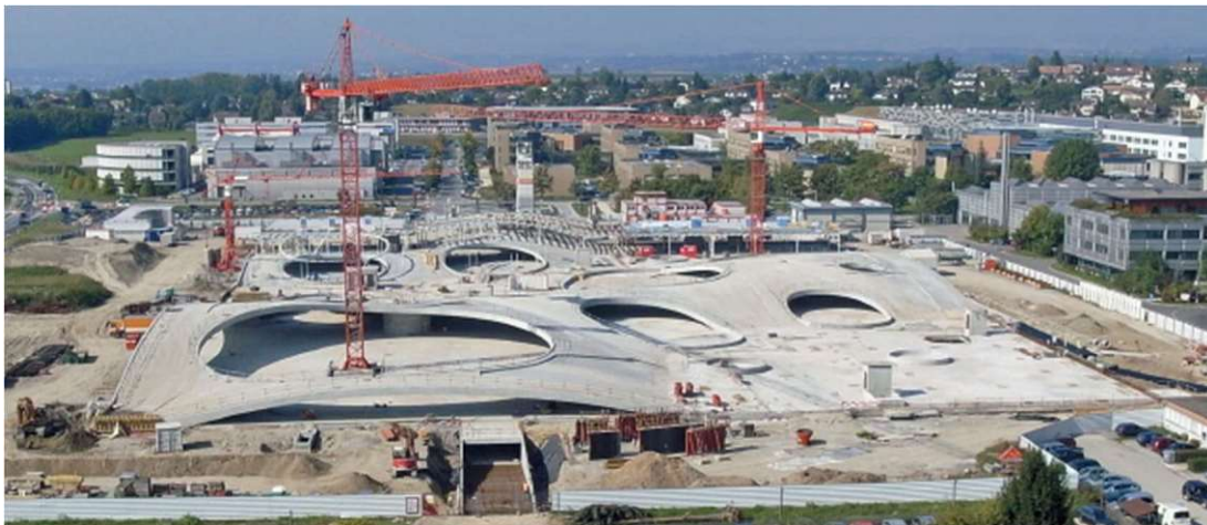
Abb. 45: Betonschalen [38]
