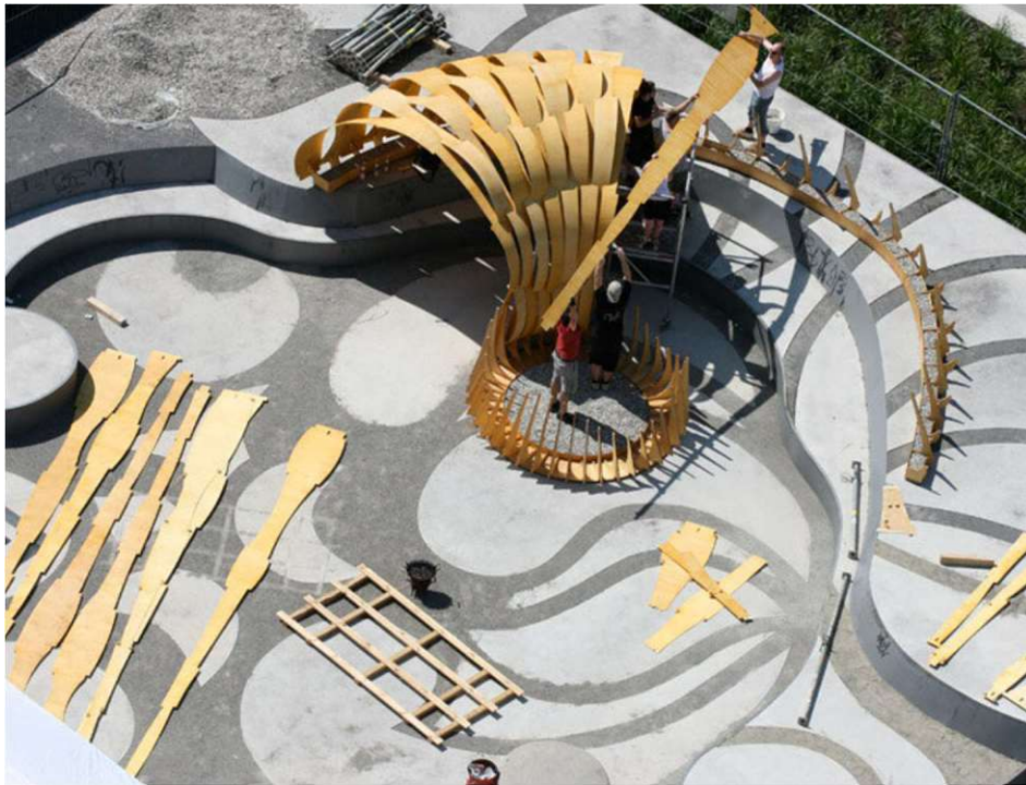
Abb. 29: Montage der Einzelementen des Forschungspavillons [33]
