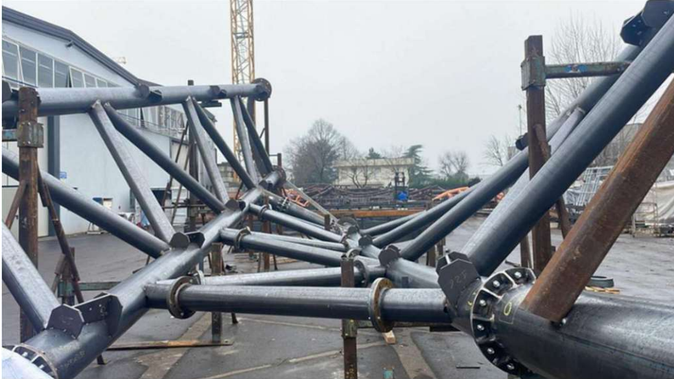
Abb. 24: Montage der tragenden Struktur der DNA-Helix-inspirierten Treppe [24]
