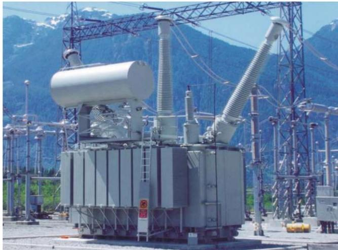
Abbildung 2.4: Blindleistungskompensations-Drosselspule, 150 Mvar, Siemens ([4])
