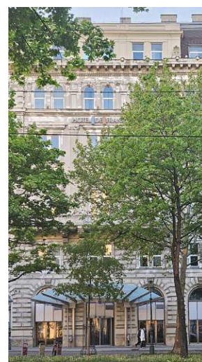
Abb. 105: Wien, Hotel de France. Eingangsbereich Schottenring, Zustand 2025.
