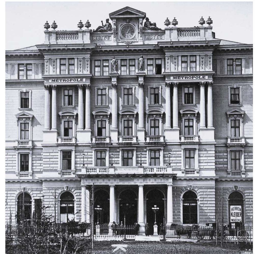
Abb. 98: Wien, Hotel Métropole, Fassadenansicht. Carl Schumann (Aufnahme), Ludwig Tischler (Architekt), 1873.
