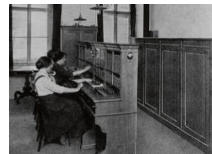
Abb. 116: Wien, Grand Hotel, Telefonzentrale, um 1900.
