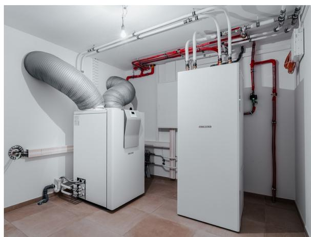
Abbildung Nr.21: Luftwärmepumpe
