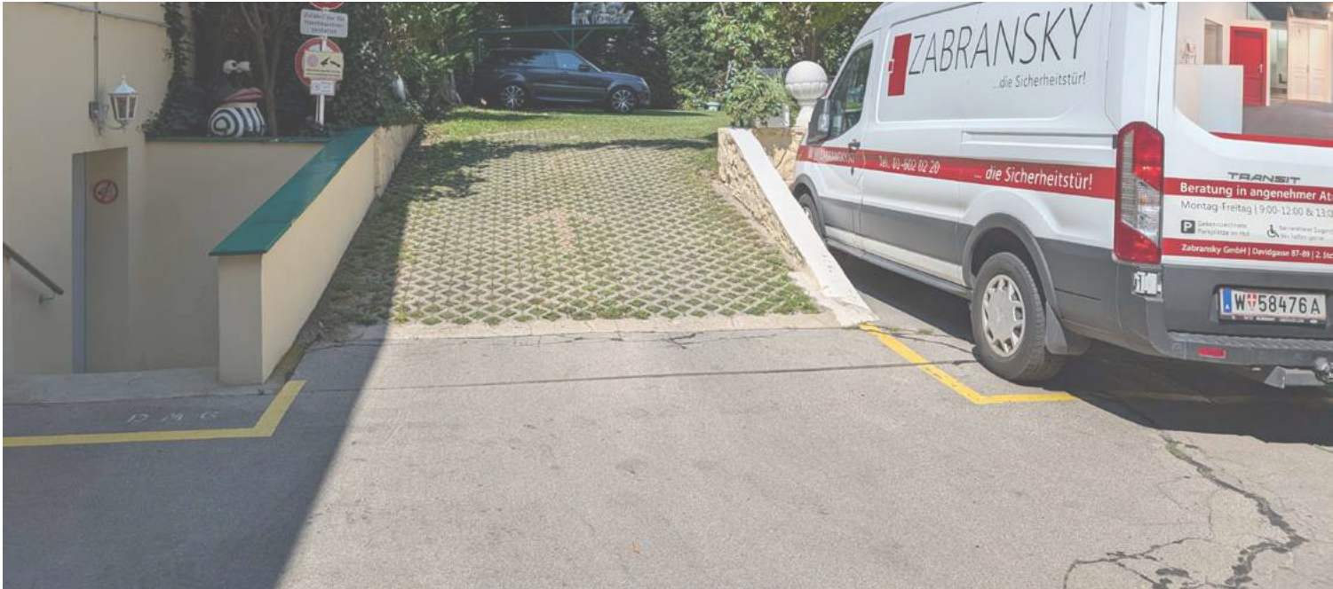
Abb. 56: Teilweise Entsiegelung der Parkplätze
