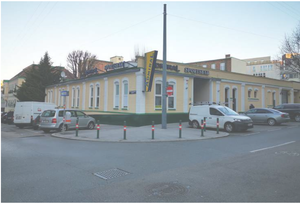
Abb. 61: Wettlokal an Straßenkreuzung
