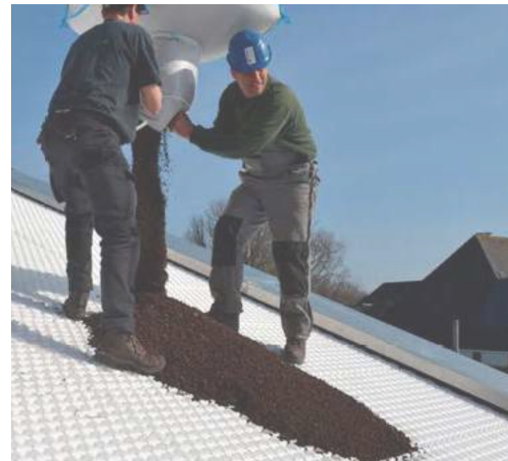
Abb. 225: Schubgesichertes Gründachsystem (Optigrün)
