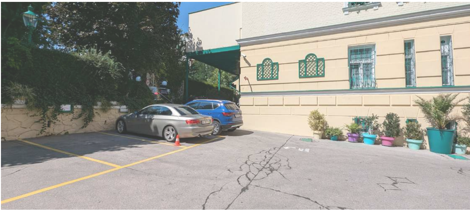
Abb. 55: Versiegelte Parkplatzflächen im Innenhof
