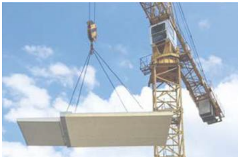
Abb. 208: XC® Living Balcony Fertigteil an Kran (MMK, 2022)
