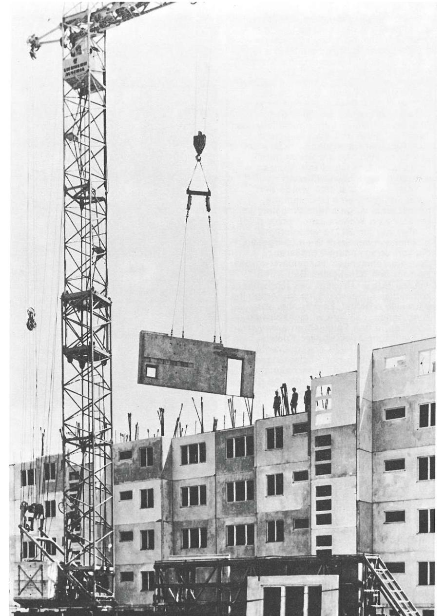
Abb. 23 Transport und Montage der Betonfertigteile
