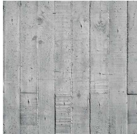
Abb.105: Innenwand Beton, Holzschalung
