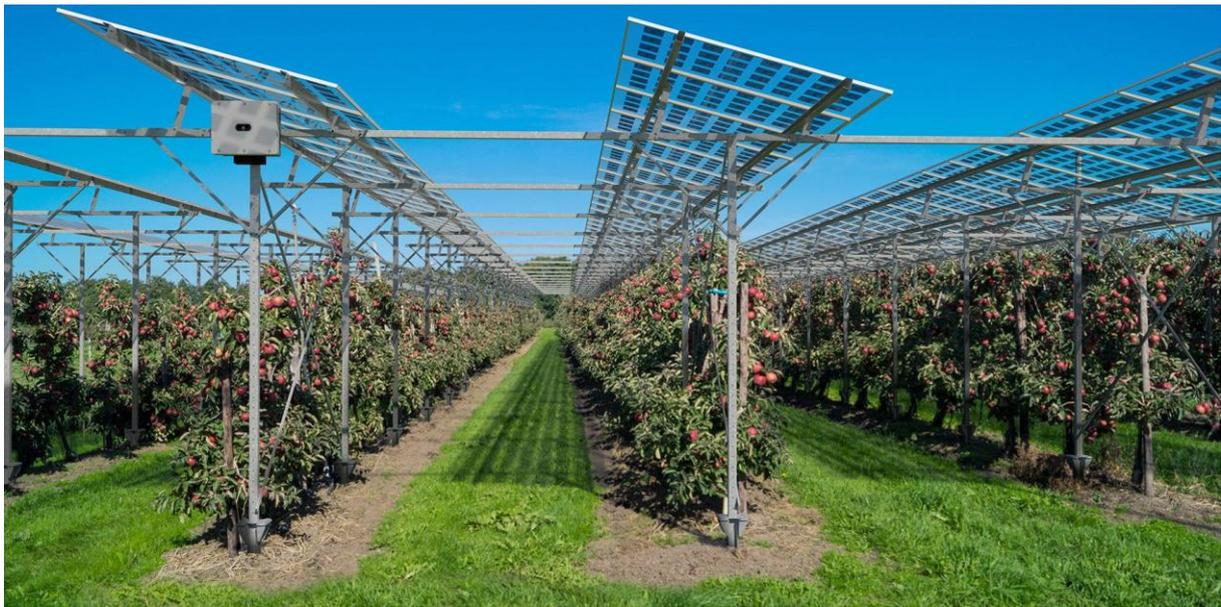
**Abbildung 10: Agri-PV im Obstbau im steirischen Haidegg** (ECOWIND Handels- & Wartungs-GmbH, 2022)
