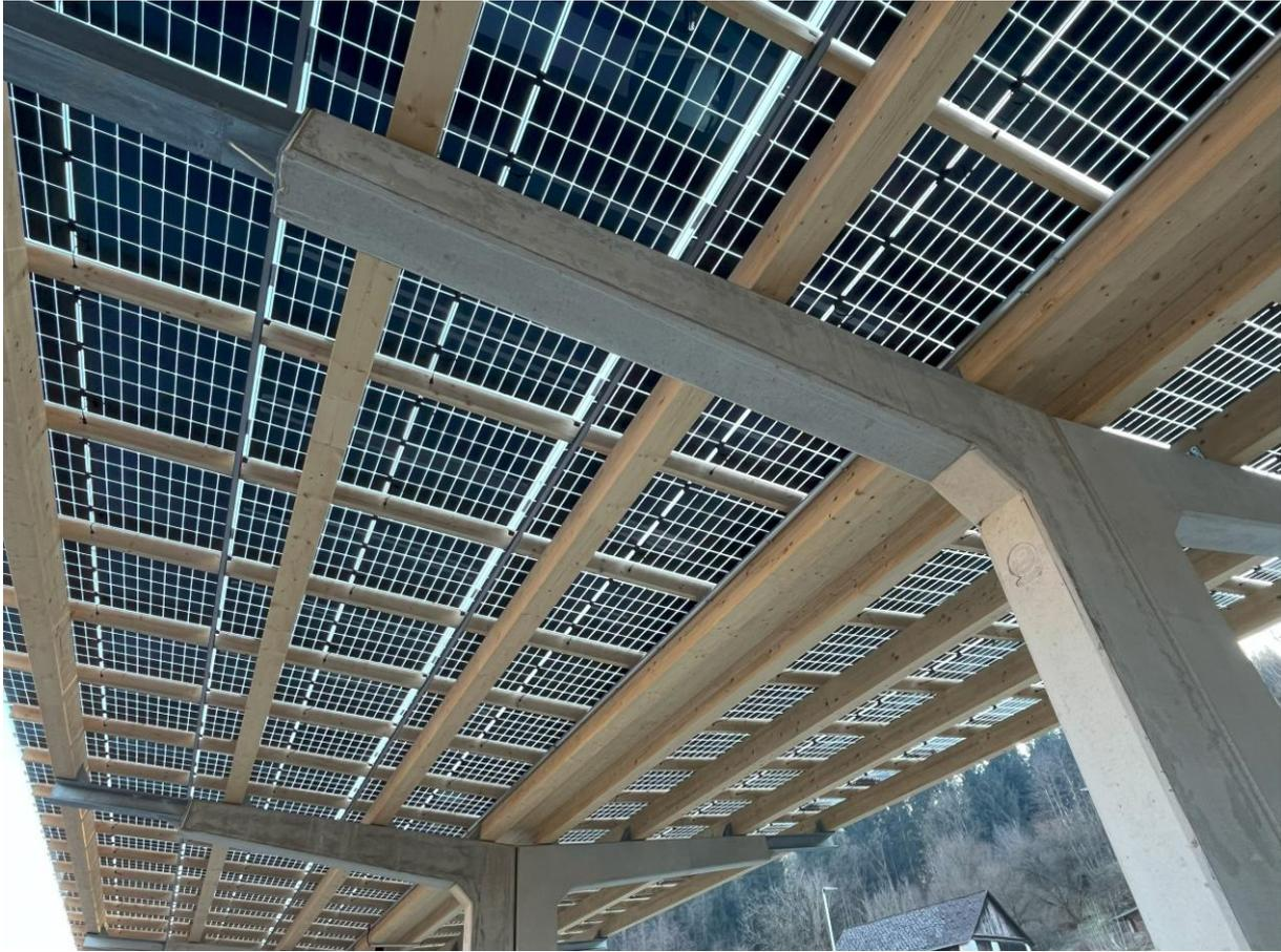
**Abbildung 6: Holzunterkonstruktion bei einer Parkplatz-PV-Anlage in Waidhofen an der Ybbs (NÖ)** (eigene Aufnahme, 2025)
