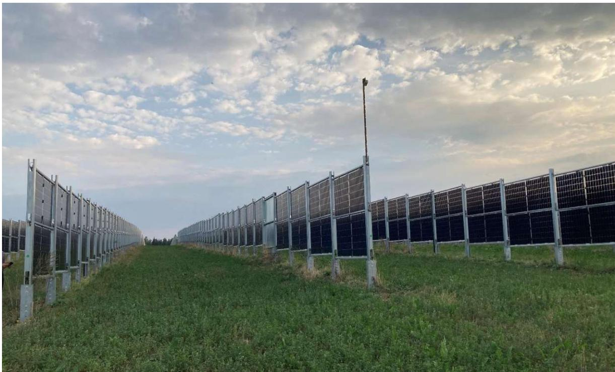
**Abbildung 8: Senkrecht-bifaziale Agri-PV-Anlage im Ackerbau in Dallein (NÖ)** (eigene Aufnahme, 2024)
