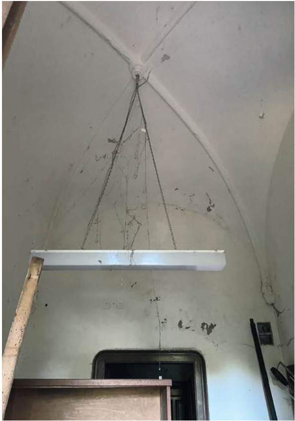
Abb. 279 Kreuzgewölbe mit Schlussstein
