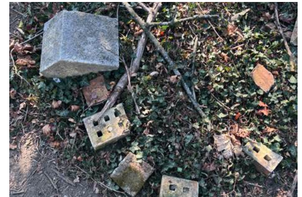
Abb. 182 Bestandteile eines Zinnen, Rothschild-Coudé
