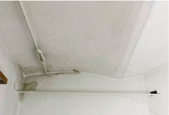
Abb. 355 Eisenstangen unterhalb der Platzldecke
