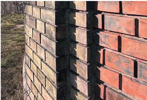
Abb. 159 Versatz Pilaster zur Wandfläche
