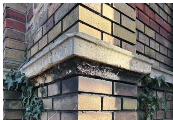
Abb. 190 Gipskruste am Gesims, Rothschild-Coudé
