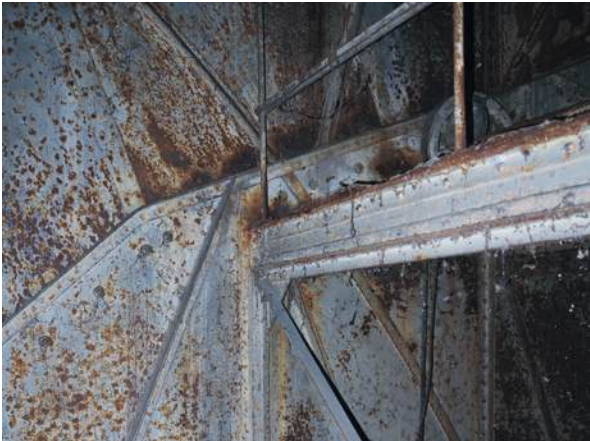
Abb. 314 Anbindung Galerie 2 an Schutzhülle
