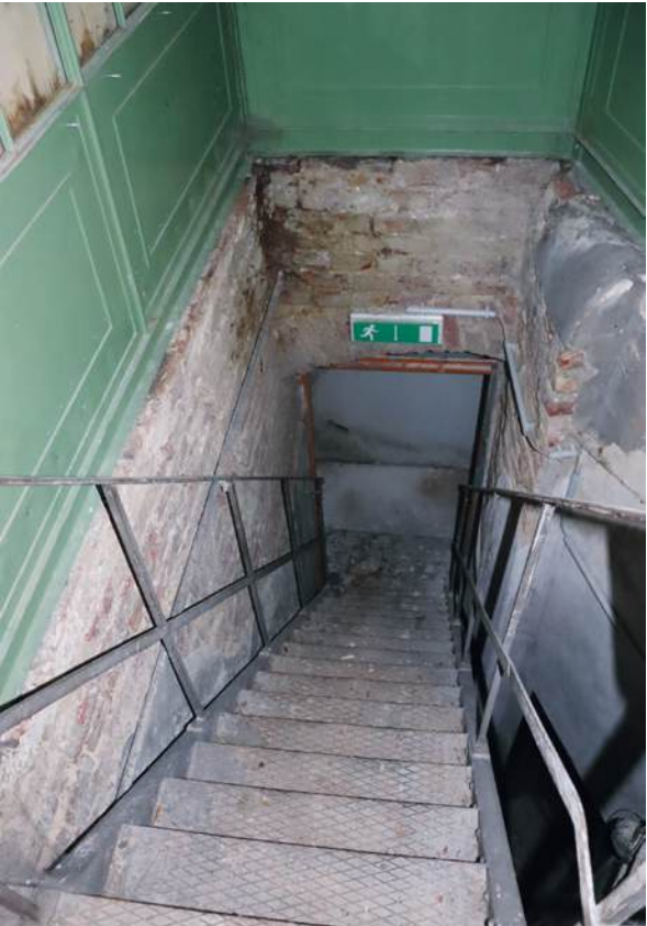
Abb. 405 Stiegenaufgang zu Raum OG1_01
