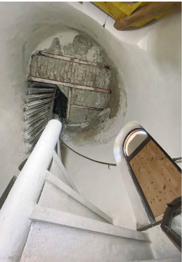
Abb. 335 Untersicht Dachausstieg, Erschließungstrakt
