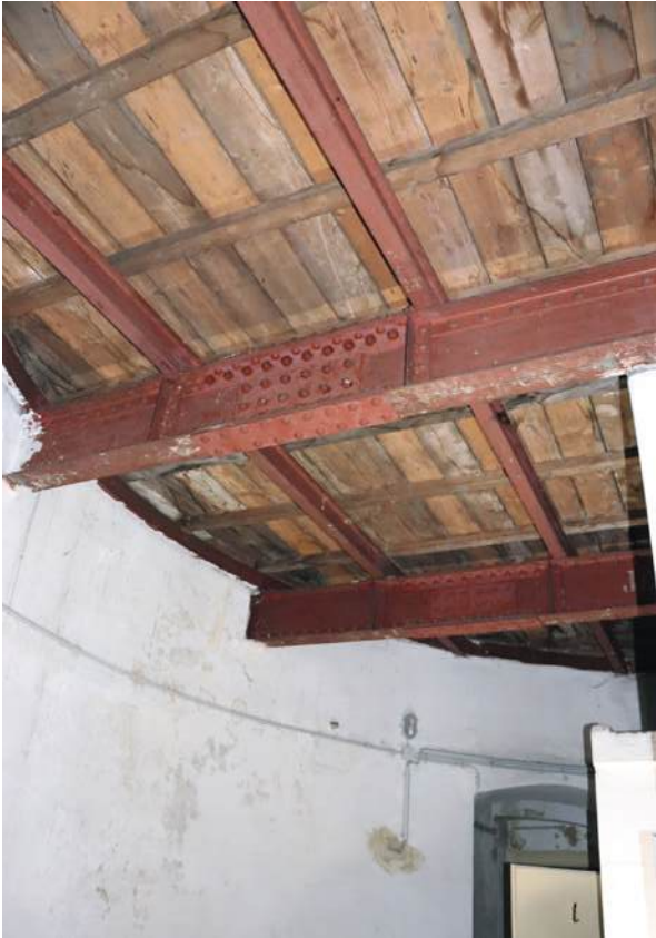
Abb. 380 Untersicht Schweboboden
