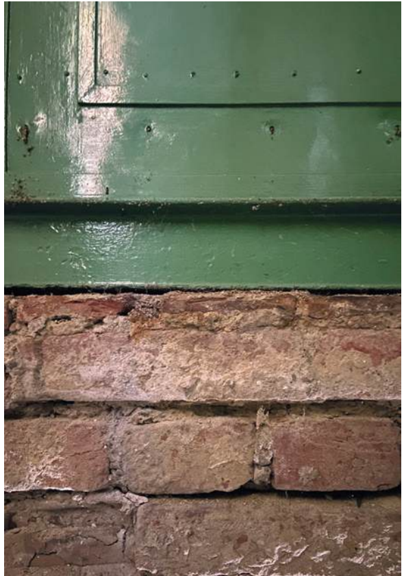
Abb. 403 Anschluss Festverglasung an Mauerwerk
