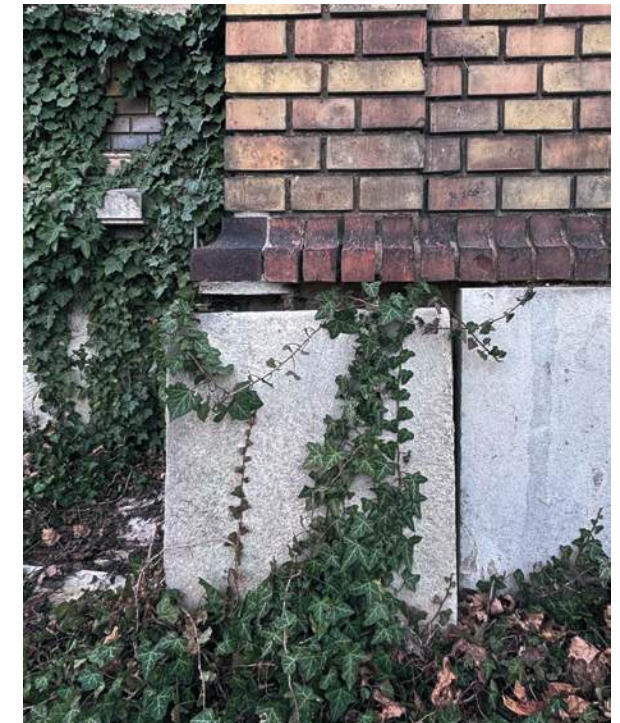
Abb. 197 gelöste Verankerung der Natursteinplatte, Eingangstrakt, Rothschild-Coudé
