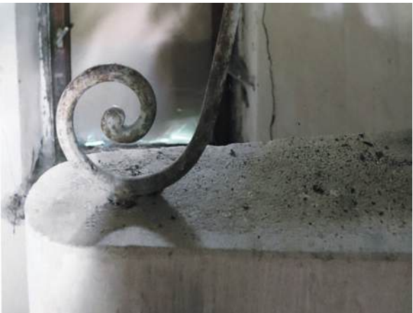
Abb. 336 Detail Handlauf, Wangentreppe
