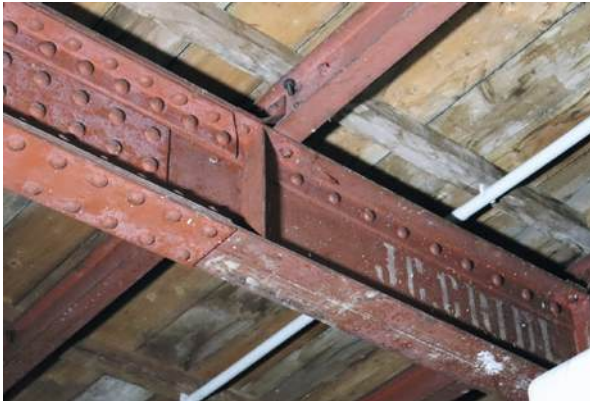
Abb. 378 Hauptträger mit Inschrift J. G. Gridl
