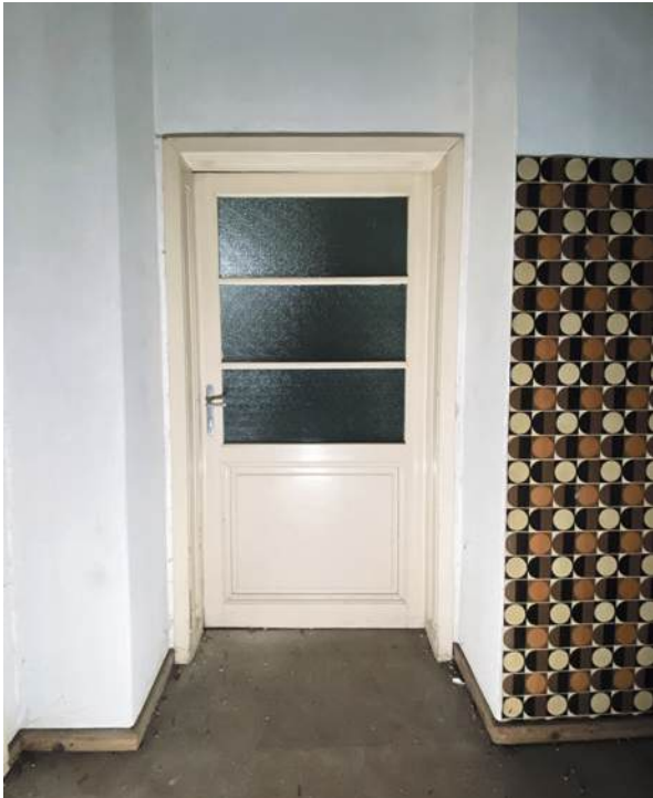
Abb. 167 gestemmte Innentüre mit dreiteiliger Glasfüllung
