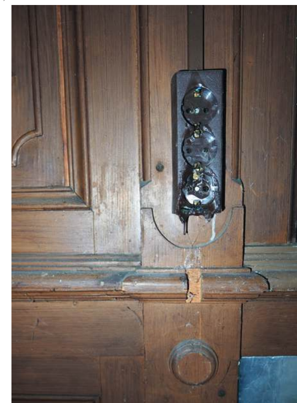
Abb. 200 Einkerbung an der Wandverkleidung, Beobachtungsraum, Rothschild-Coudé
