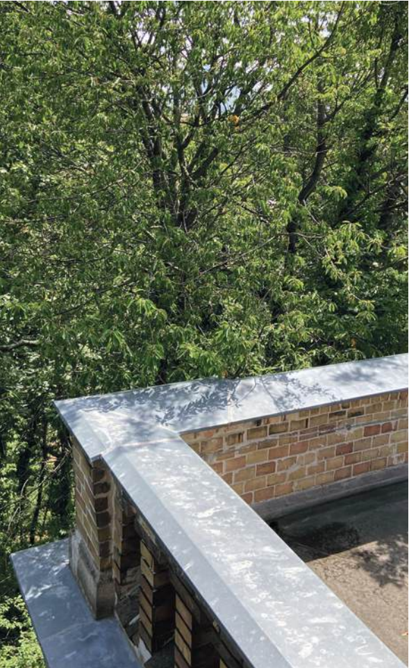
Abb. 338 Blick vom Stiegenhaus auf die Terrasse
