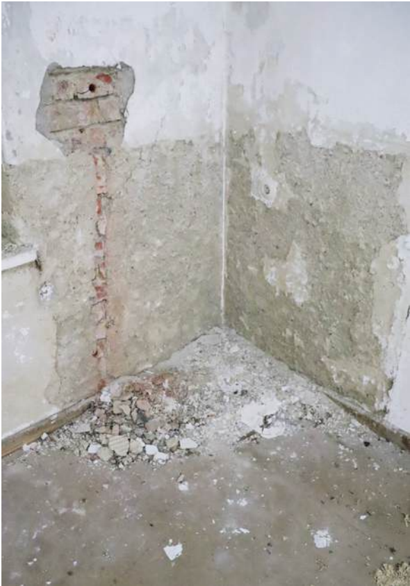
Abb. 359 Freilegung Mauerwerk, westseitige Außenwand
