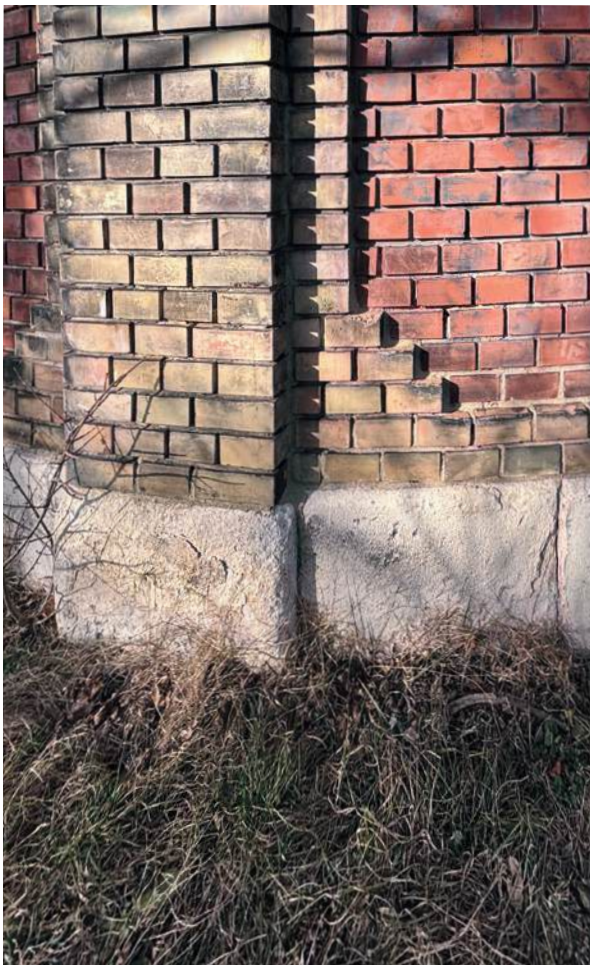
Abb. 160 Abtreppung der Klinkersteine
