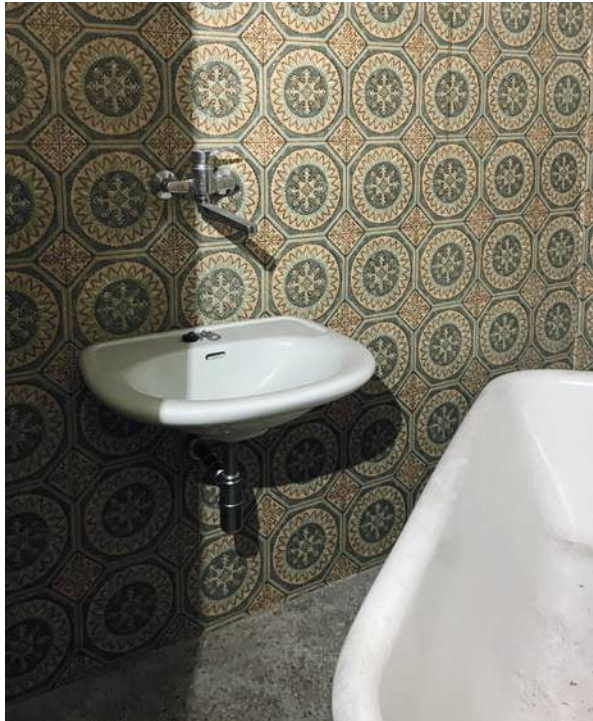
Abb. 168 Wandbelag in Fliesenoptik, Badezimmer
