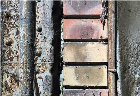
Abb. 300 Übergang Schutzhülle zur Außenwand
