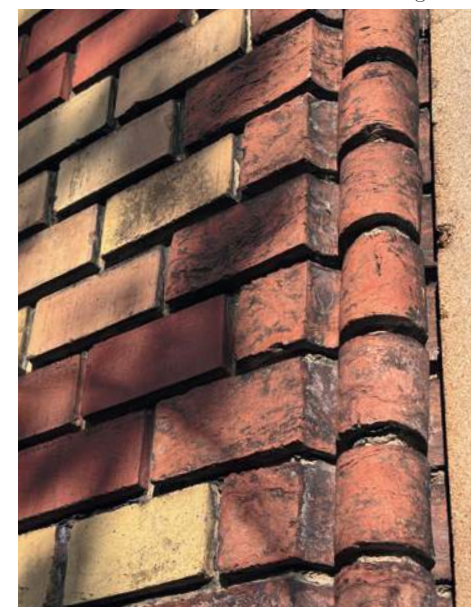
Abb. 125 Formsteine der Fensterumrahmung
