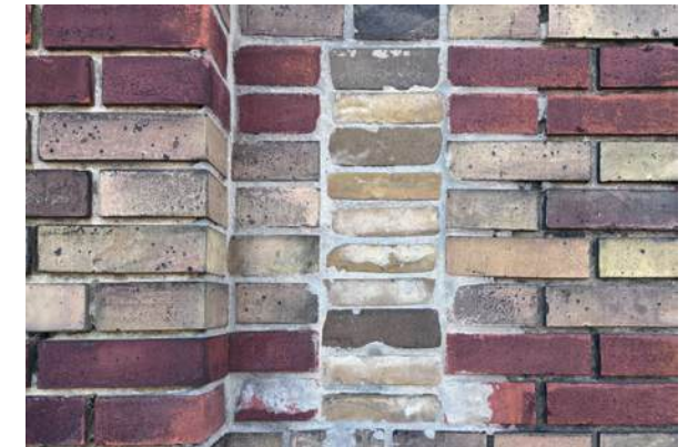
Abb. 185 nachträgliche Vermauerung, Rothschild-Coudé
