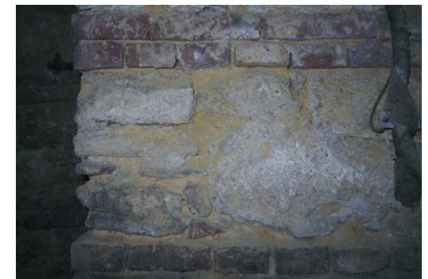
Abb. 265 unverputztes Ziegel- und Bruchsteinmauerwerk
