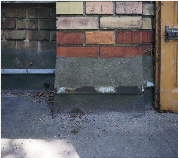
Abb. 332 Hochzug an Mauerwerksbrüstung
