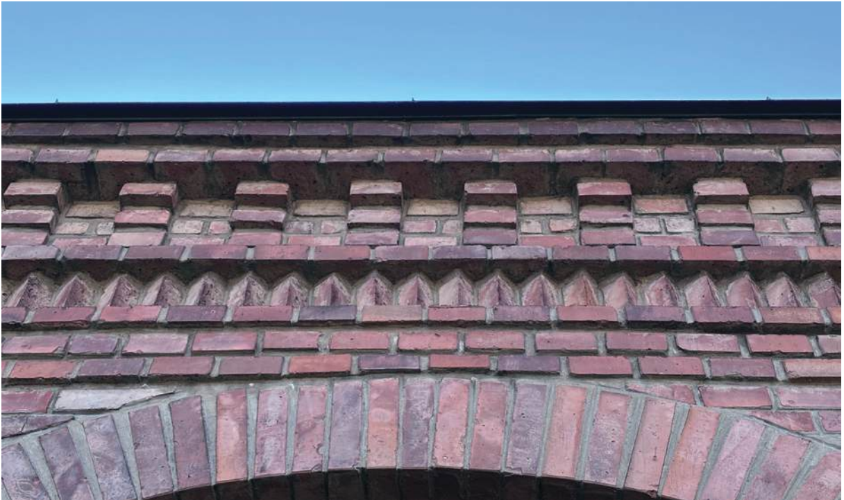
Abb. 161 Hauptgesims, Wohntrakt, nachträgliche Adaptierung, Photographischer Pavillon
