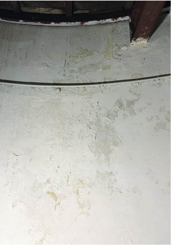
Abb. 384 Putzschäden, Außenwand
