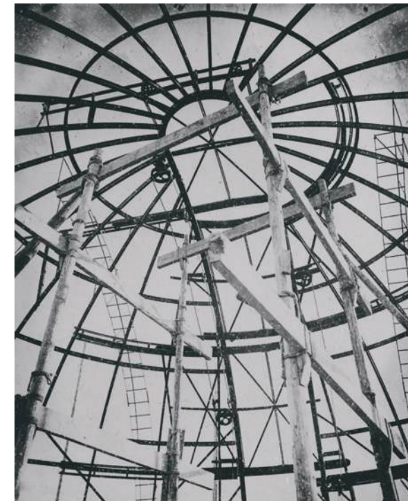
Abb. 47 Konstruktion der kleinen Kuppel von der Universitätssternwarte von Nizza, 1882-1885
