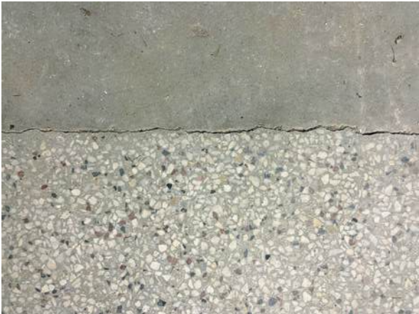
Abb. 397 Übergang Terrazzobelag zu Estrichboden
