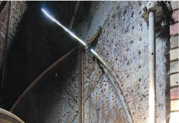
Abb. 310 Spalt der Öffnungsvorrichtung
