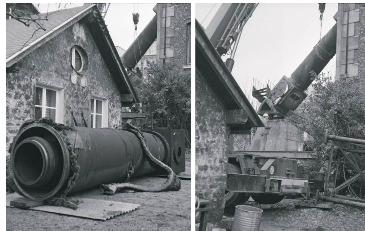
Abb. 207, 208 Abbruch Äquatorial Coudé am Pariser Observatorium, 1981
