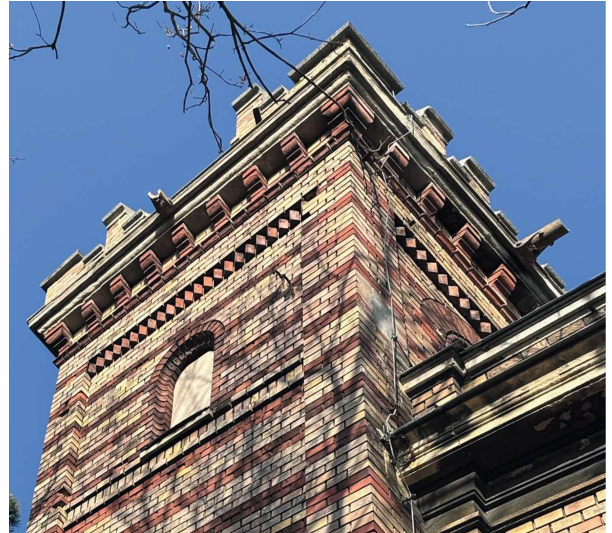
Abb. 124 Fassadendekor am Erschließungsturm und anschließenden Haupttrakt
