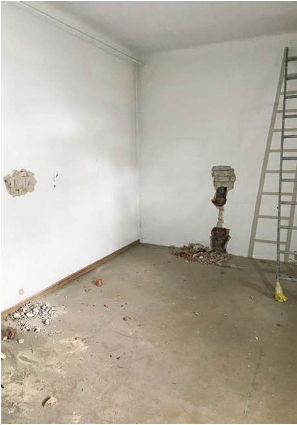
Abb. 367 Freilegung Mauerwerk
