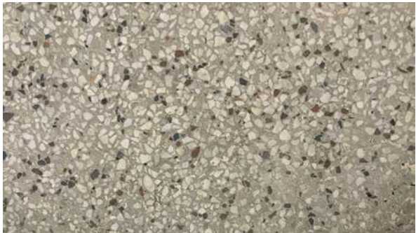
Abb. 170 Terrazzobodenbelag, Vorraum
