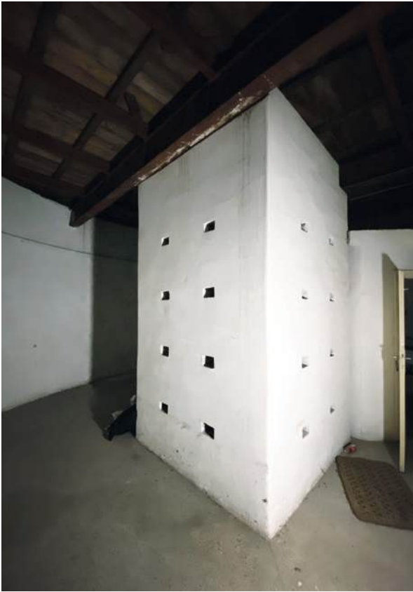
Abb. 377 Mauerwerkspfeiler
