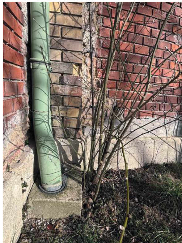
Abb. 192-193 Setzling entlang der Rundmauer, Observatoriumstrakt, Photographischer Pavillon
