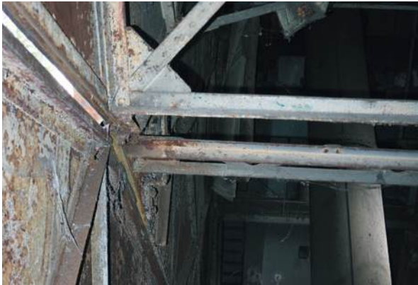
Abb. 307 Anbindung Aussteifung Schutzhülle
