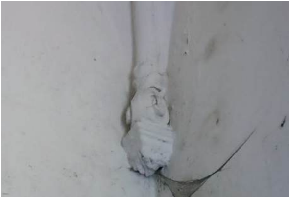
Abb. 276 Auflager einer Diagonalrippe
