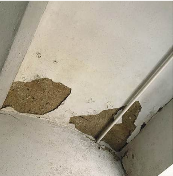
Abb. 371 Feuchtigkeitsschäden, Platzdecke
