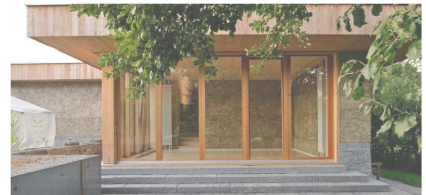
Abb.35: Außenansicht eines Wellerlehmbaus, Deitingen, 2010
