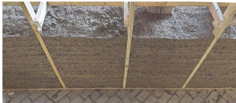
Abb.47: Holzkonstruktion mit feuchter Leichtlehmausfachung
