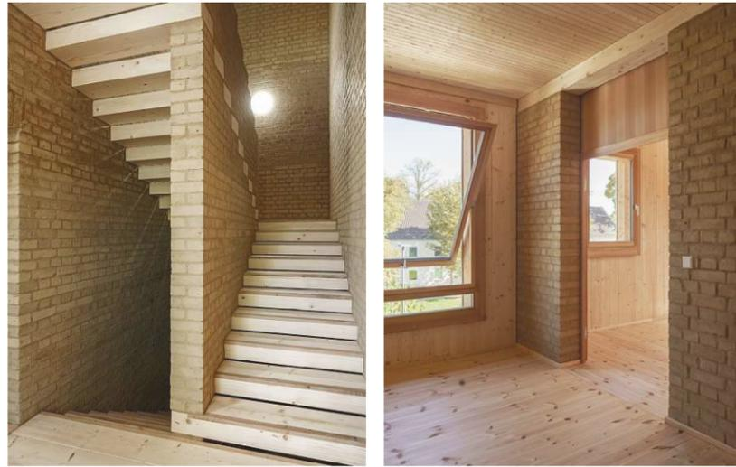
Abb.44: Tragende Innenwand mit Holzbalken zur optimalen Lastenverteilung, Versuchshaus 4, Bad Aibling (rechts)
