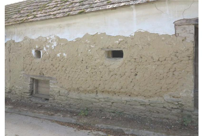
Abb.20: Foto eines Stadls, Lehm-Pfostenkonstruktion in Roggendorf, NÖ
