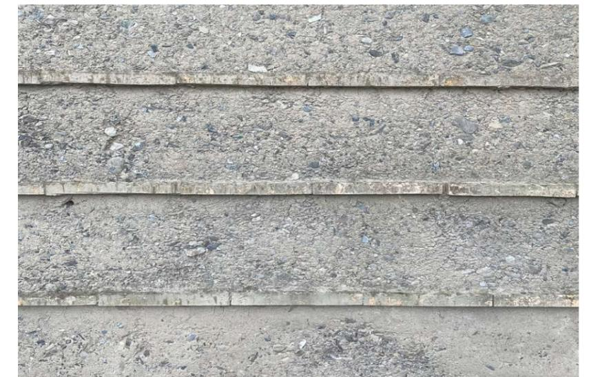
Abb. 01: Stampflehm, Ansicht einer Stampflehmwand mit eingearbeiteten Erosionsbremsen
