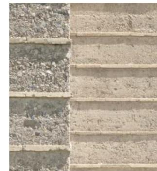
Abb.88: Ansicht einer erodierten Stampflehmwand
