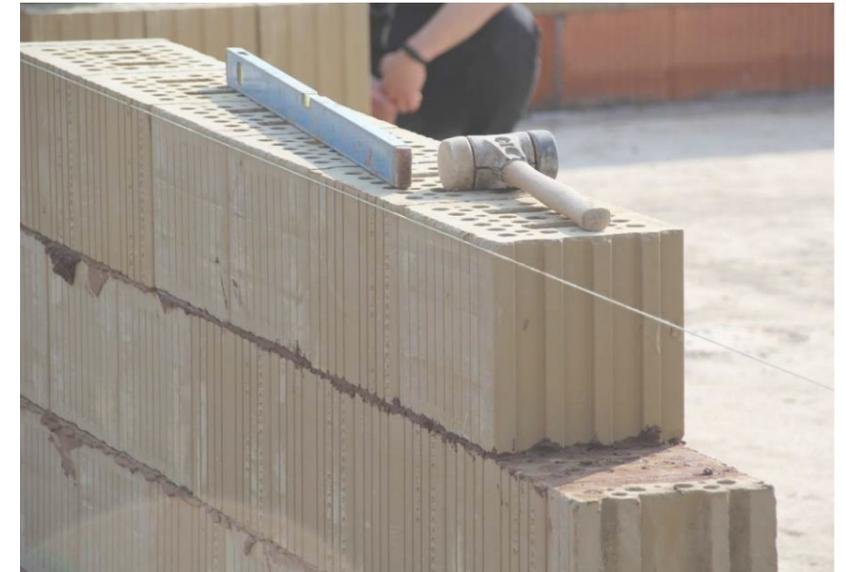
Abb.40: Herstellung eines Lehmmauerwerks, Projekt Lehmhaus, Meißen, 2022
