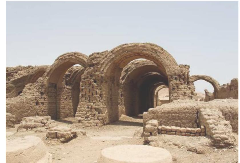
Abb.10: „Lager der Götter“, aus Lehmsteinen gebaute Lagerhalle zur Aufbewahrung von Speisen, zugehörig zu den Bauten für Ramses II, Ägypten, ca. 1300 v. Chr.
