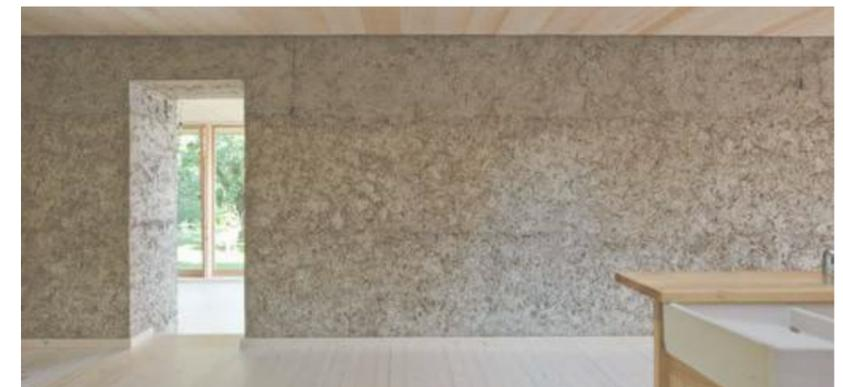
Abb.34: Innenansicht eines Wellerlehmbaus, Deitingen, 2010
