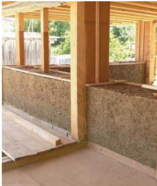
Abb.32: Abgestochene Mauer aus Wellerlehm
