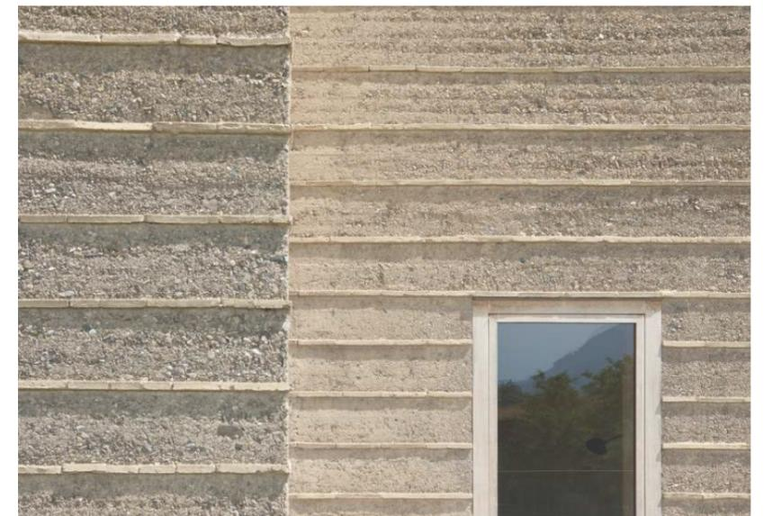
Abb.30: Stampflehmfassade, eingearbeitete Ziegel als Erosionsbremse, Haus Rauch, Vorarlberg
