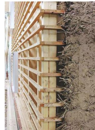
Abb.46: Außenwand, Freier Auftrag von Leichtlehm auf eine Lattung (ca.1000 kg/m<sup>3</sup>), Wohnhaus J, Volhard, 2012
