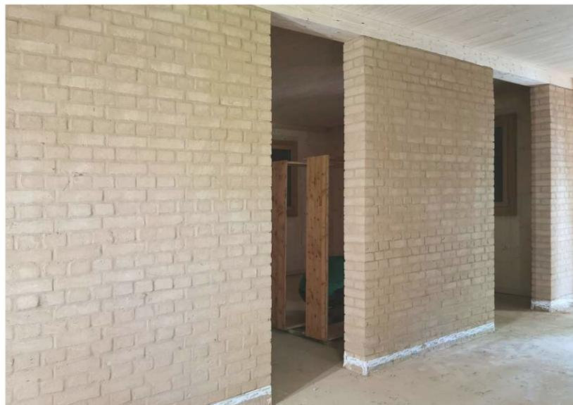
Abb.45: Tragende Innenwand aus schweren Lehmsteinen, Versuchshaus 4, Bad Aibling
