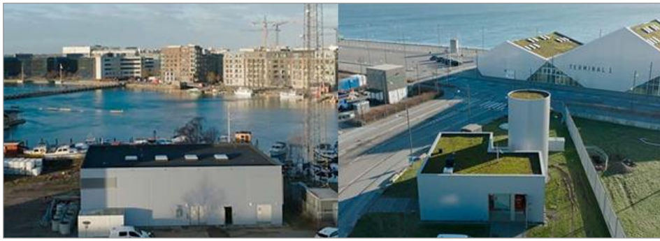
Abbildung 105-106: Klimafreundliche Wärmepumpen - von links nach rechts: Meer- und Abwasserwärmepumpe in Sydhavnen und Grundwasserwärmepumpe in Nordhavn (Quelle: HOFOR, 2024a: online)
