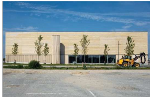
Abbildung 107: Energiezentrum Nordhavn (Quelle: Gottlieb Paludan Architects, 2023: online)
