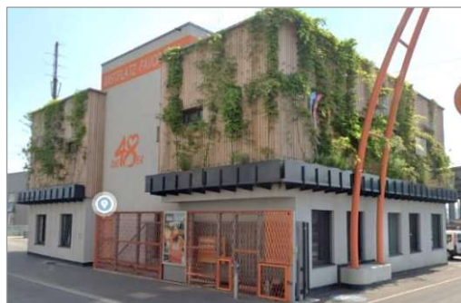
Abbildung 89: Grünfassade Betriebsgebäude der MA48 (Quelle: Google Maps, 2022: online)
