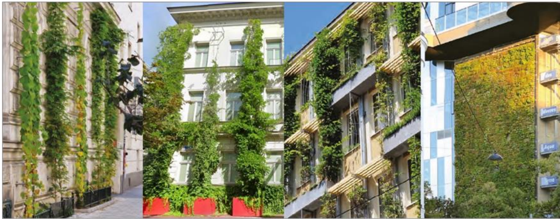
Abbildung 63-66: Beispiele von Fassadenbegrünungen in Wien - von links nach rechts: Bodengebunden: Amtshaus 6. Bezirk - Damböckgasse, Troggebunden: Amtshaus 5. Bezirk Schönbrunner Straße, Fassadengebunden mit Trögen: Zentrale Wiener Wasser (MA31) Grabnergasse & Fassadengebunden mit Rankkonstruktion Haus des Meeres (Quelle: Google Maps, 2023: online; MA42, 2023: 27ff)
