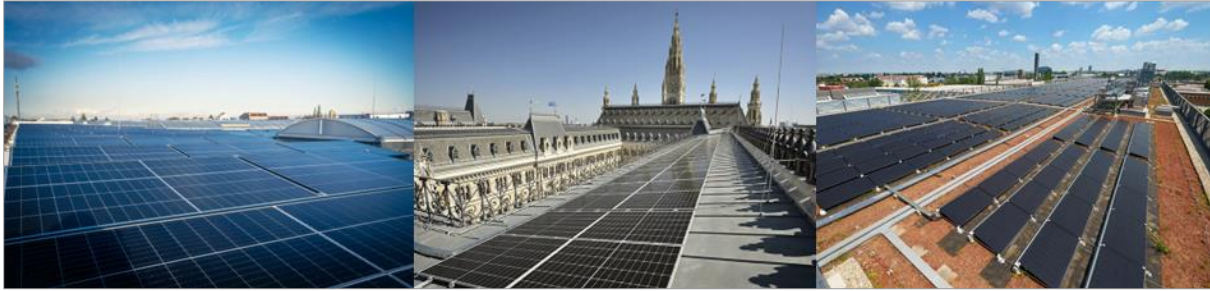
Abbildung 22-24: Einsatz von Photovoltaik zur Stromversorgung - von links nach rechts: Hauptwerkstätte Wiener Linien, Wiener Rathaus, Klinik Floridsdorf (Quelle: Wien Energie, 2023f&g: online)
