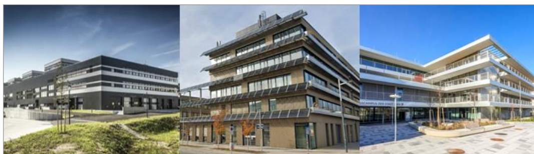
Abbildung 94-96: Energieeffiziente Gebäude - von links nach rechts: Smart Campus Wiener Netze, Technologiezentrum Seestadt Aspern und Bildungscampus Seestadt Aspern Nord (Quelle: Stadt Wien, 2017c: online; Google Maps, 2021: online; Stadt Wien, 2024a: online)
