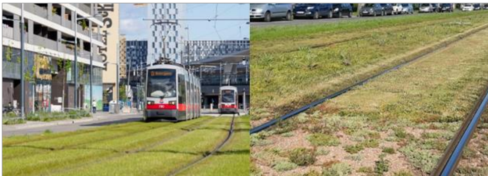
Abbildung 61-62: Beispiele von Grüngleisen in Wien - von links nach rechts: Einsatz von Rasengleisen im Nordbahnhofviertel und Einsatz von Sedumgleisen in unterschiedlichen Varianten (Quelle: Wiener Linien, 2024h; Die Grünen, 2023: online)
