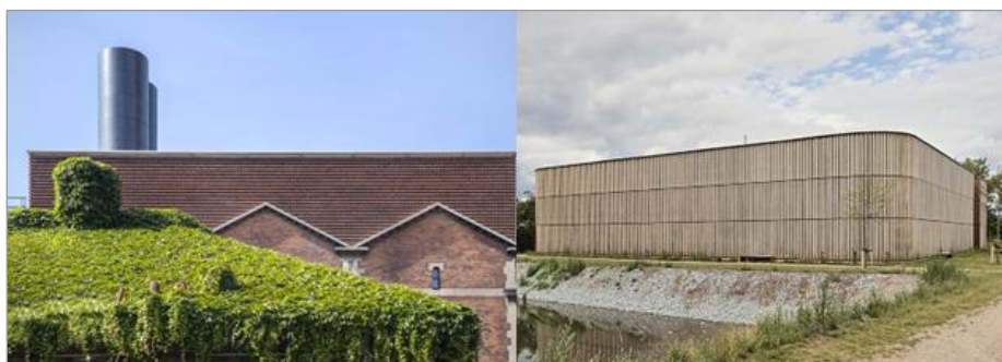
Abbildung 108-109: Beispiele von Fernkälteanlagen in Kopenhagen - von links nach rechts: Kältezentrale in Tietgensgade und Ørestad (Quelle: Gottlieb Paludan Architects, 2013 & 2019: online)
