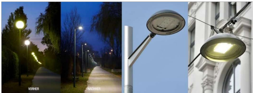
Abbildung 84-87: LED-Einsatz in Wien - von links nach rechts: Vorher & Nachher - Effekt durch LED, Mastansatzleuchte und Seilhängeleuchte mit LED-Leuchtmittel (Quelle: MA22, 2018: 46f; Stadt Wien, 2024ya: online; Stadt Wien, 2024z: online)
