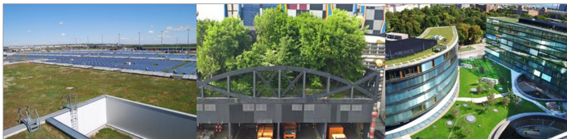
Abbildung 68-70: Beispiele von Dachbegrünung in Wien - von links nach rechts: extensive Dachbegrünung inkl. PV-Anlage - Post-Briefzentrum im 23. Bezirk, intensive Dachbegrünung - Müllverbrennungsanlage Spittelau im 9. Bezirk, Kombination aus extensiver & intensiver Dachbegrünung - Erste Campus im 10. Bezirk (Quelle: GRÜNSTATTGRAU, 2024: online; MA22, 2021: 54 & 122)
