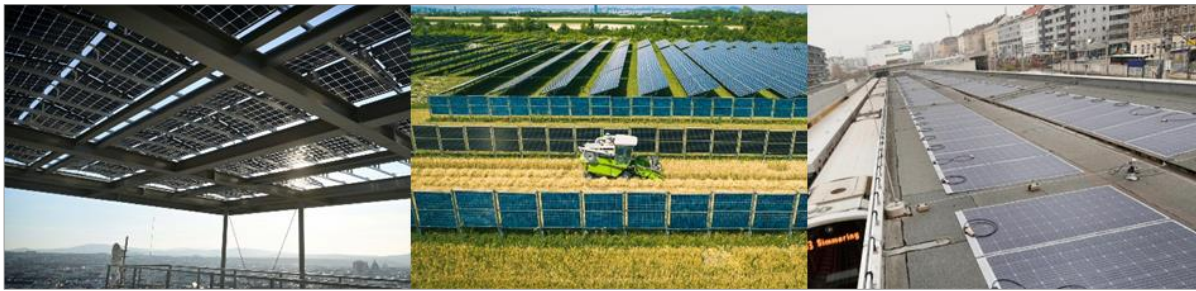
Abbildung 19-21: Unterschiedlicher Einsatz von Photovoltaik-Modulen - von links nach rechts: bifaziale Dachmodule am Haus des Meeres, bifaziale vertikale Module in der Schafflerhofstraße, Solar-Klebefolien bei U-Bahn-Station Ottakring (Quelle: Wien Energie, 2023&b: online)
