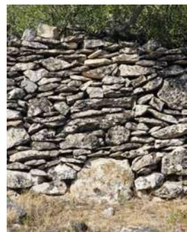
Abb.26.: Trockenmauer Textur, bei Splitska, Unterschied Steingröße Fundament und Mauersteine
