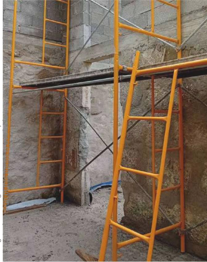
83 Granitwände mit Ringanker und Ziegelaufbau
