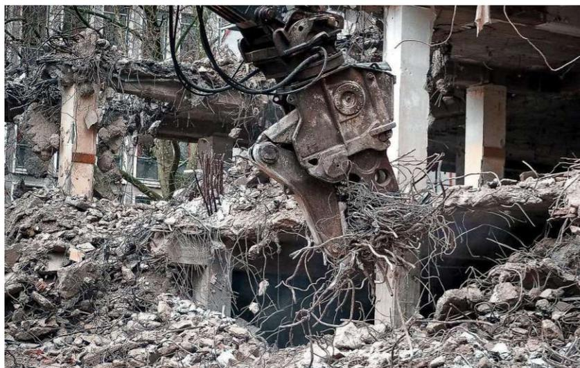
Abb. 38. Abbruch eines Stahlbetongebäudes
