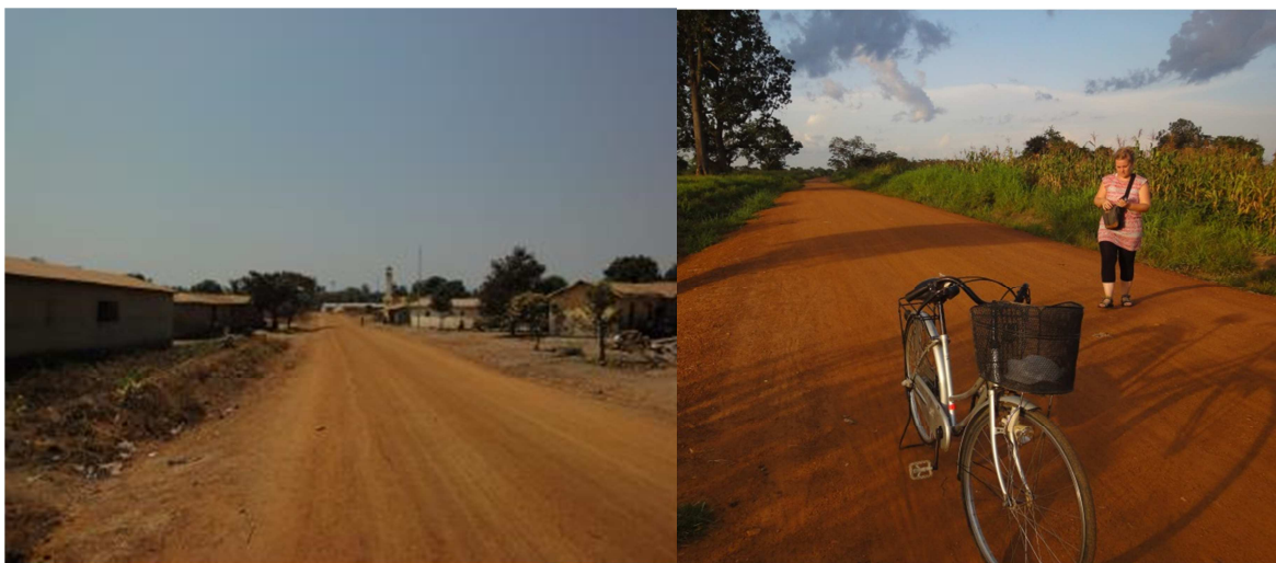
Abb. 26: Hauptverkehrsstraße Route d’Affem Boussou , Kpatakpani in der Trocken- und Regenzeit; Quelle: eigene Aufnahmen 2012
