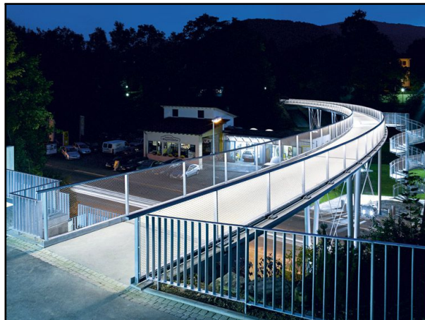
Abbildung 2.5: Textilbetonbrücke in Albstadt-Lautlingen 6
