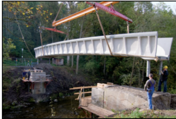
Abbildung 2.4: Segmentbrücke aus Textilbeton in Oschatz [4]
