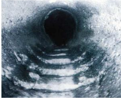
Abbildung 4.7: Bildbeispiel für mechanischen Verschleiß
