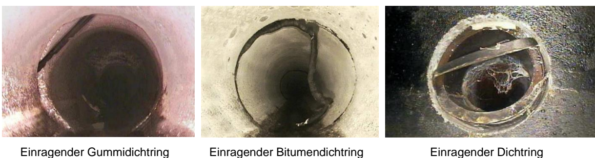
Abbildung 4.2: Bildbeispiele für einragende Dichtungsmaterialien
