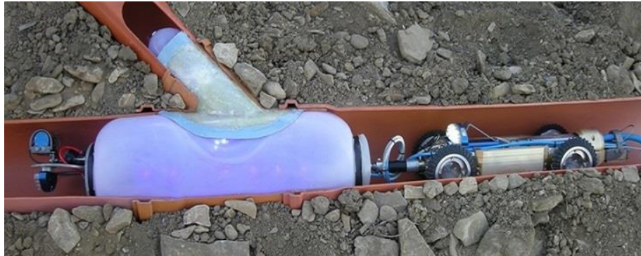
Abbildung 7.21: Einbau des Hutprofils mittels Spezialpacker 199
