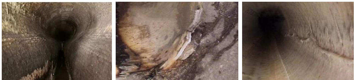
Ablöste Innenauskleidung
