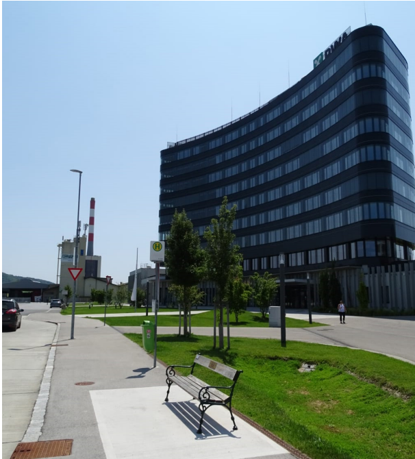
Abbildung 16: Neu errichtete Bushaltestelle (eigene Aufnahme)
