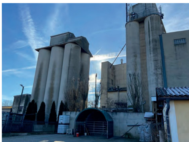
Abbildung 10: Lange Mühle – Silos
