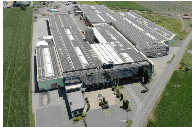
Abbildung 24: Dachfläche des „Hallo Business Parks“ nach Übernahme
