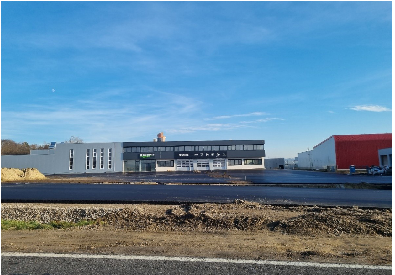
Abbildung 7: In Bau befindliches Autohaus nördlich im Gewerbepark (eigene Aufnahme)
