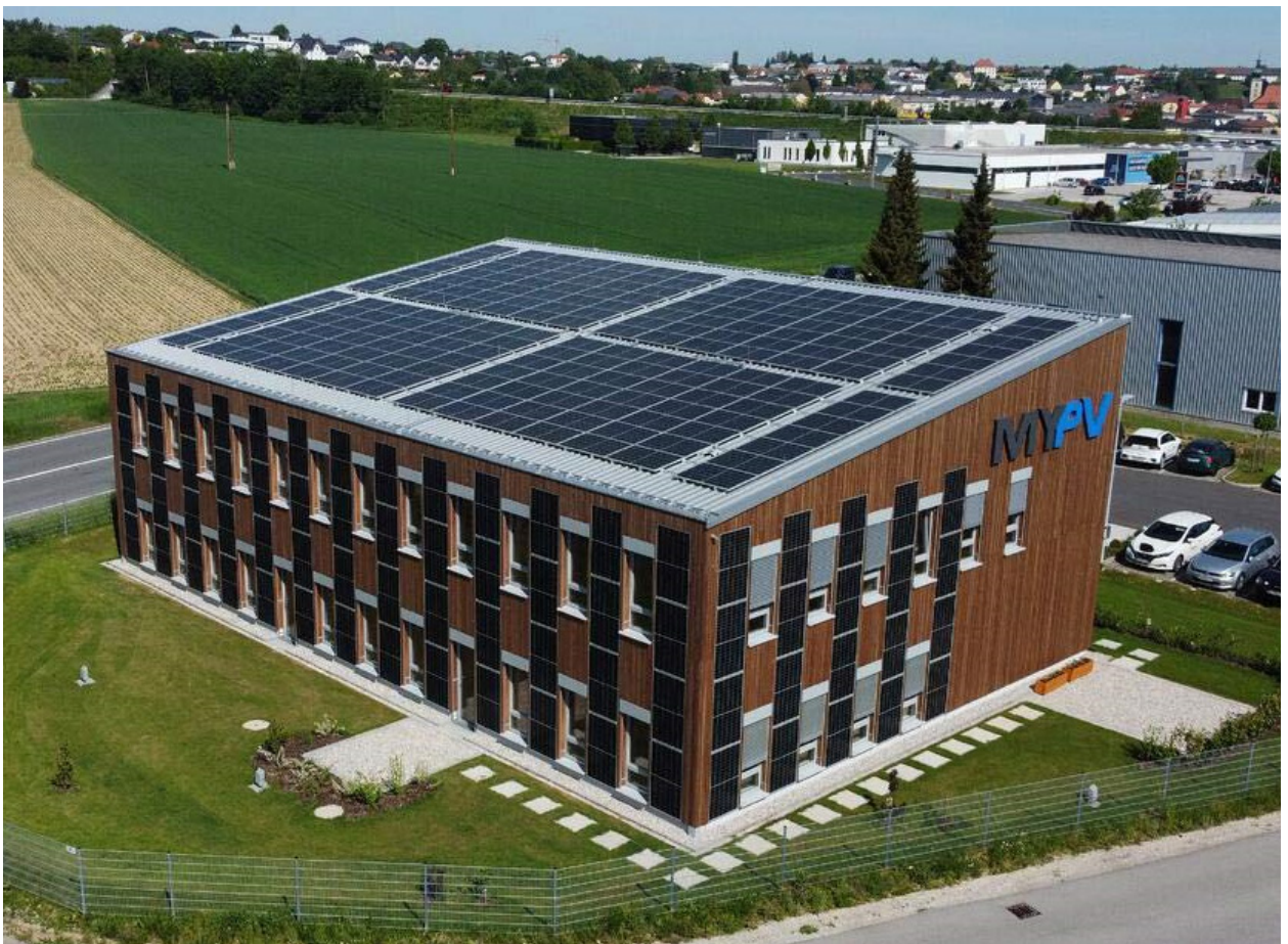
Abbildung 31: Firmengebäude mit Photovoltaikanlage auf Dach und Fassade (haustec.de)
