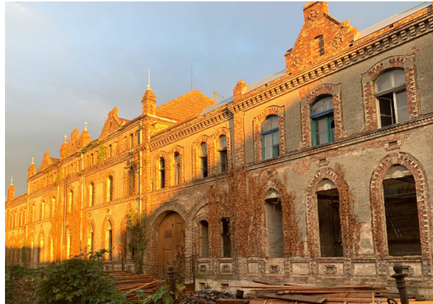
Abbildung 24: Alte Erbsenfabrik in Bruckneudorf vor dem Umbau. Quelle: OSG / Krone.at
