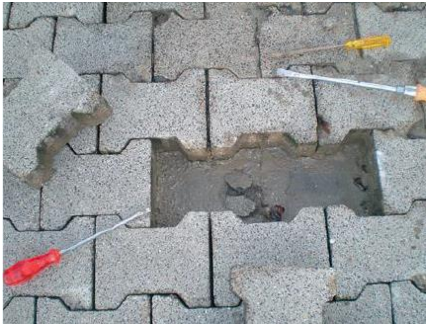
Abbildung 4.1: Verdichtete und verfestigte Bettung [7]
