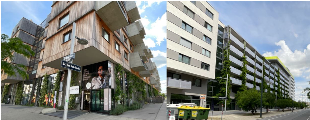
Abb. 4.5: zwei begrünte Fassaden in der Seestadt
