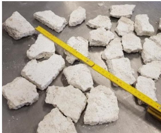
Abb. 17: Aus dem Bestandsmauerwerk entnommene Mörtelstücke [15]
