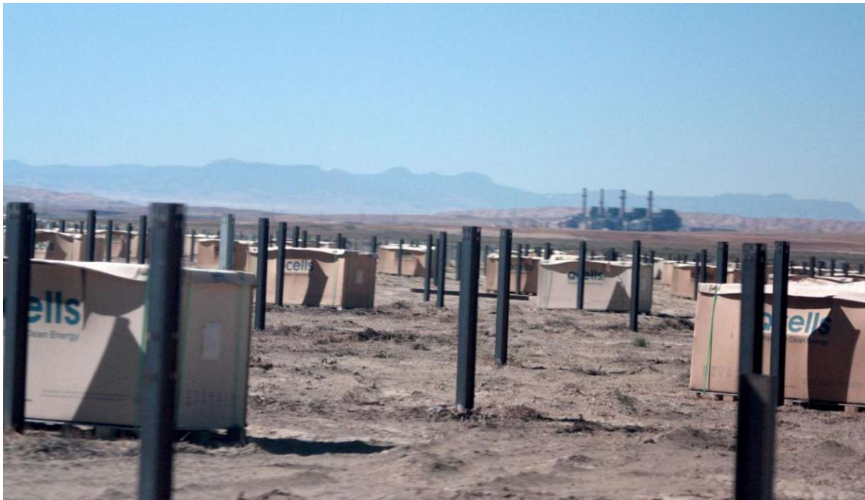
Abbildung 11: Installation von Solarmodulen – San Juan Generating Station im Hintergrund (Grover, 2023)
