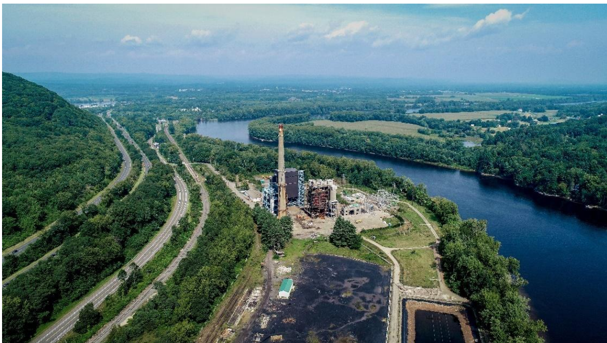
Abbildung 4: Das Gelände des Kohlekraftwerks in Holyoke, Massachusetts, in der Anfangsphase des Abrisses (Boston Society of Civil Engineers Section, 2022)
