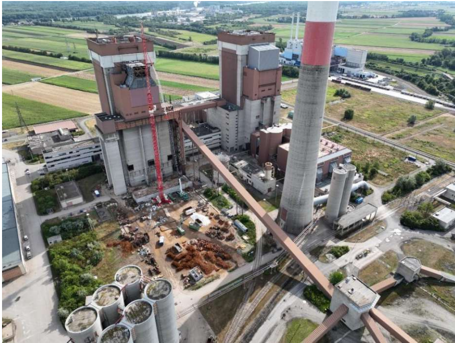
Abbildung 9: Demontagearbeiten Dürnrohr im August 2023 (VERBUND, 2023)
