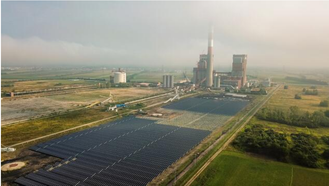
Abbildung 10: Errichtung der neuen PV-Anlage in Dürnrohr (Holler, 2023)
