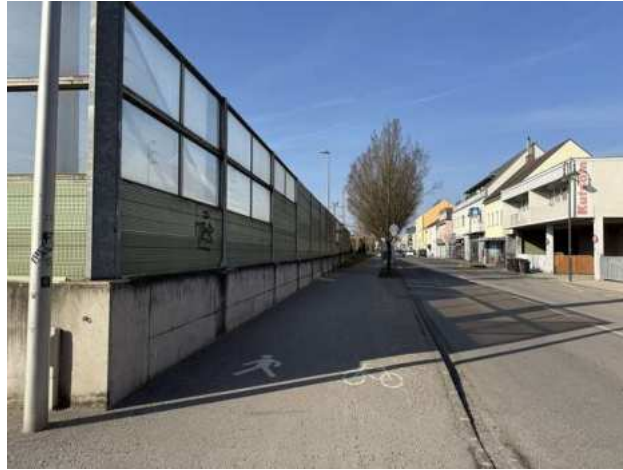
Abbildung 16: Lärmschutzwand St. Valentin (Eigene Aufnahme)
