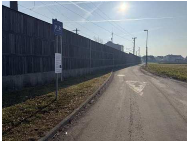
Abbildung 17: Lärmschutzwand St. Valentin (Eigene Aufnahme)
