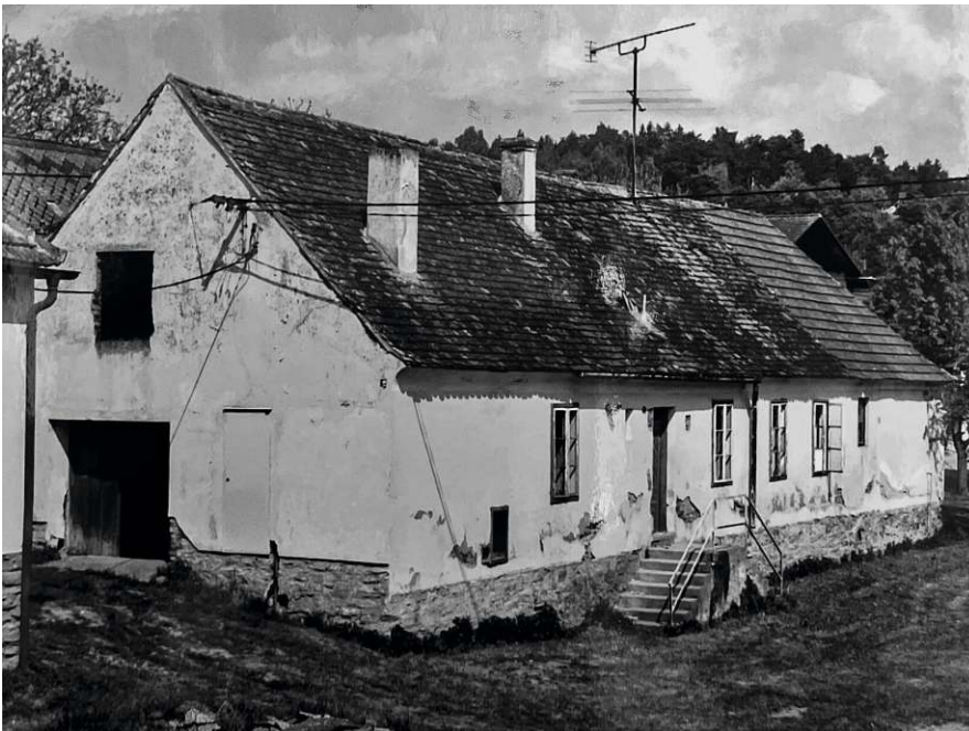
Abb. 27 Abgerissene Schmiede in Zabernreith (Privatquelle, aufgenommen in Zabern- reith 2010)
