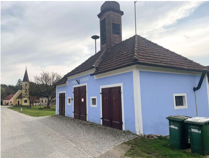
Abb. 26 Feuerwehrhaus am Dorfanger in Zabernreith (eigene Aufnahme, aufge- nommen in Zabernreith am 05.04.2025)
