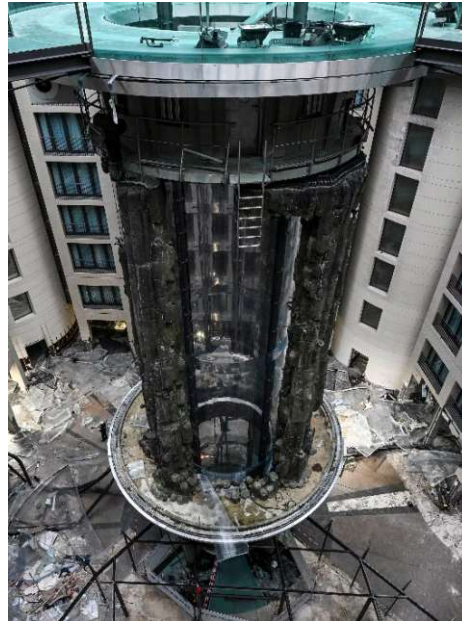
Abbildung 66: Berliner Aquadom nach dem Versagen (RND/dpa, 2023)
