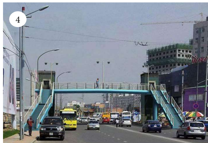
Abb 12: Brücke über die Innerortstraße
