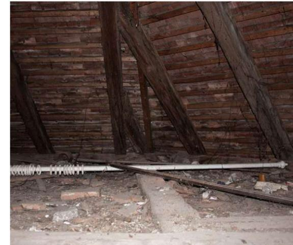
▲ Abb. 360 Dachraum mit Schädlingsbefall und Tierrückständen, 2024
