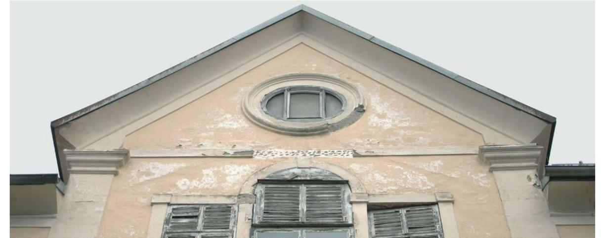
▲ Abb. 355 Giebfeld an der Südfassade des Herbertstöckls mit zahlreichen Stuck- und Putzschäden, 2024
