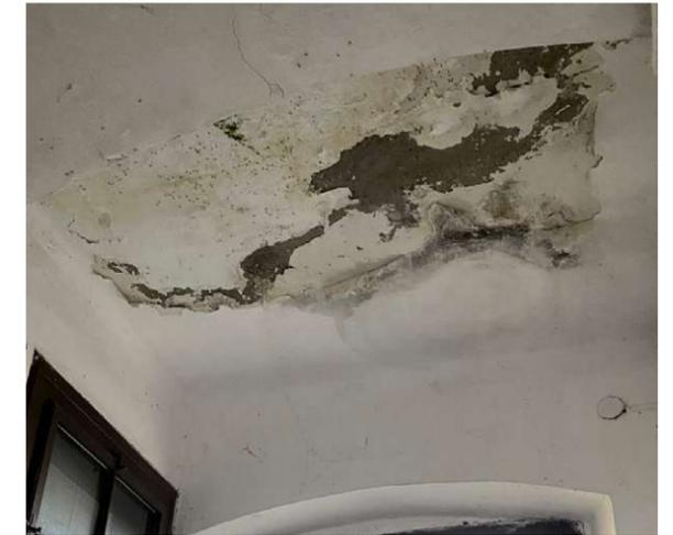
▲ Abb. 367 Feuchteschäden und Schädlingsbefall im Erdgeschoss, 2024
