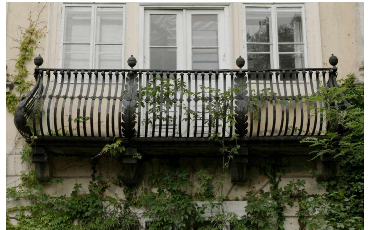
▲ Abb. 188 Mittelbalkon an der Südfassade mit schmiedeeisernem Gitter und vier Kugelaufsätzen, 2024
