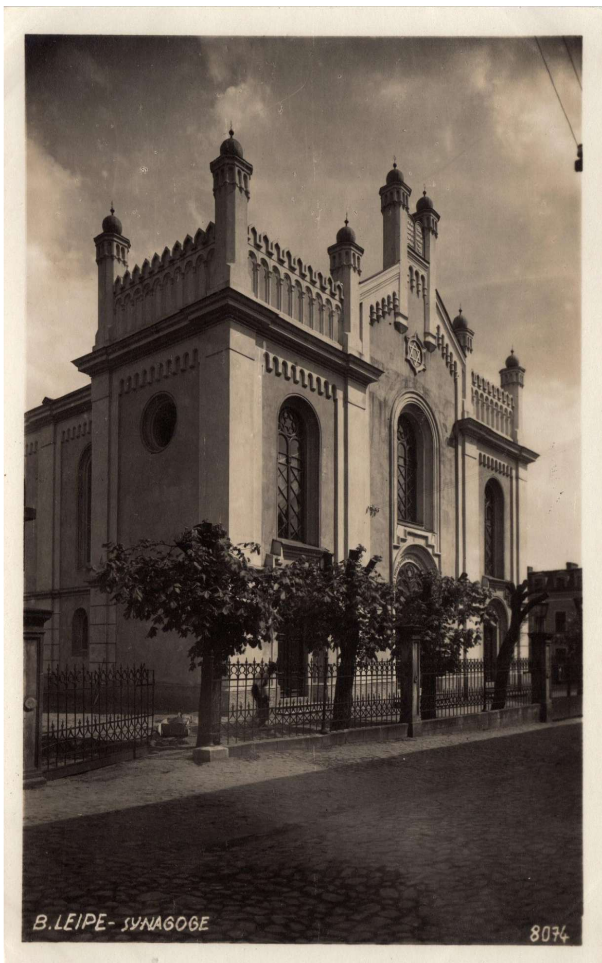
Abb. 3-12: Westfassade und ein Teil der Nordfassade der Synagoge in Česká Lípa, Postkarte, ca. 1930
