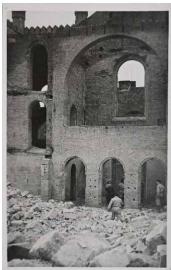
oben links: Abb. 4-26: Erdgeschossfenster
