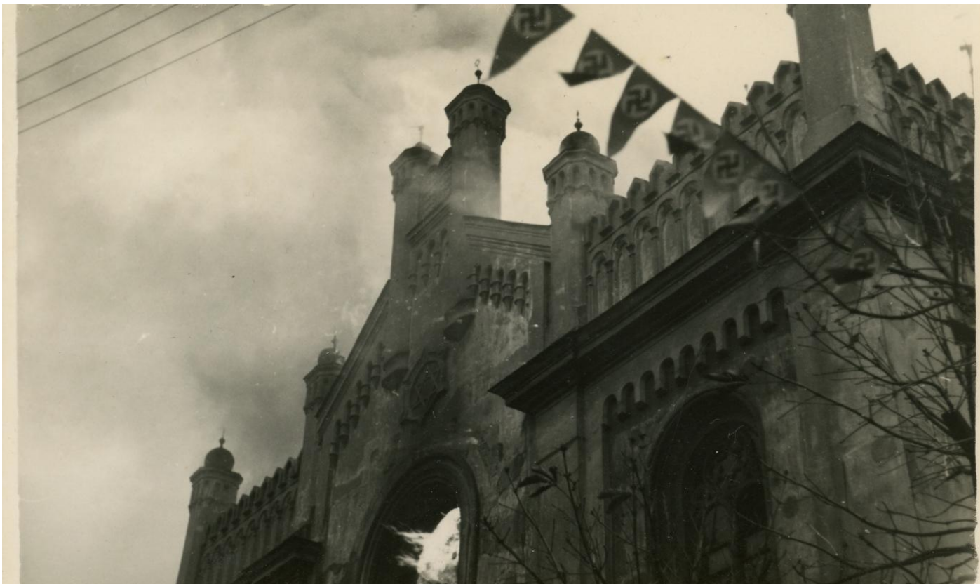
Abb. 4-18: Fotografie des Westgiebels während des Brandes
