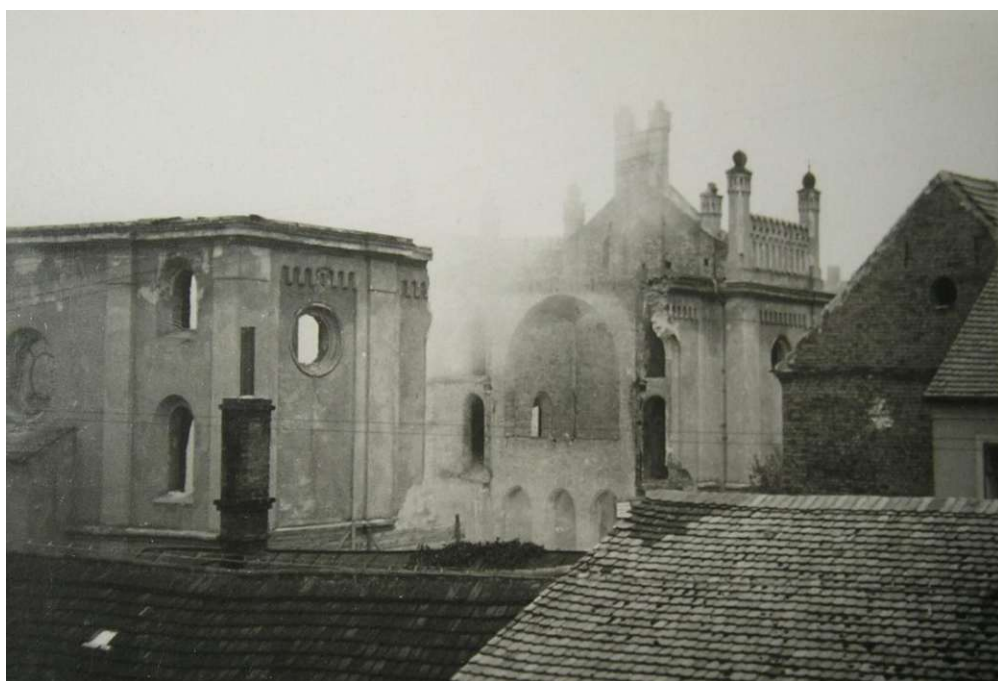
Abb. 3-11: Fotografie von der Nordostseite der Synagoge in Česká Lípa kurz nach dem Einsturz
