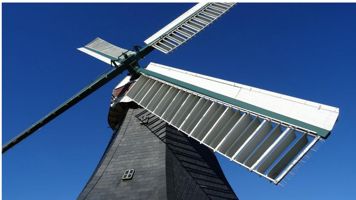
Abb. 66: Jalousieflügel mit geöffnetem Hauptheck und geschlossenem Vorheck der Windmühle in Krokau.
