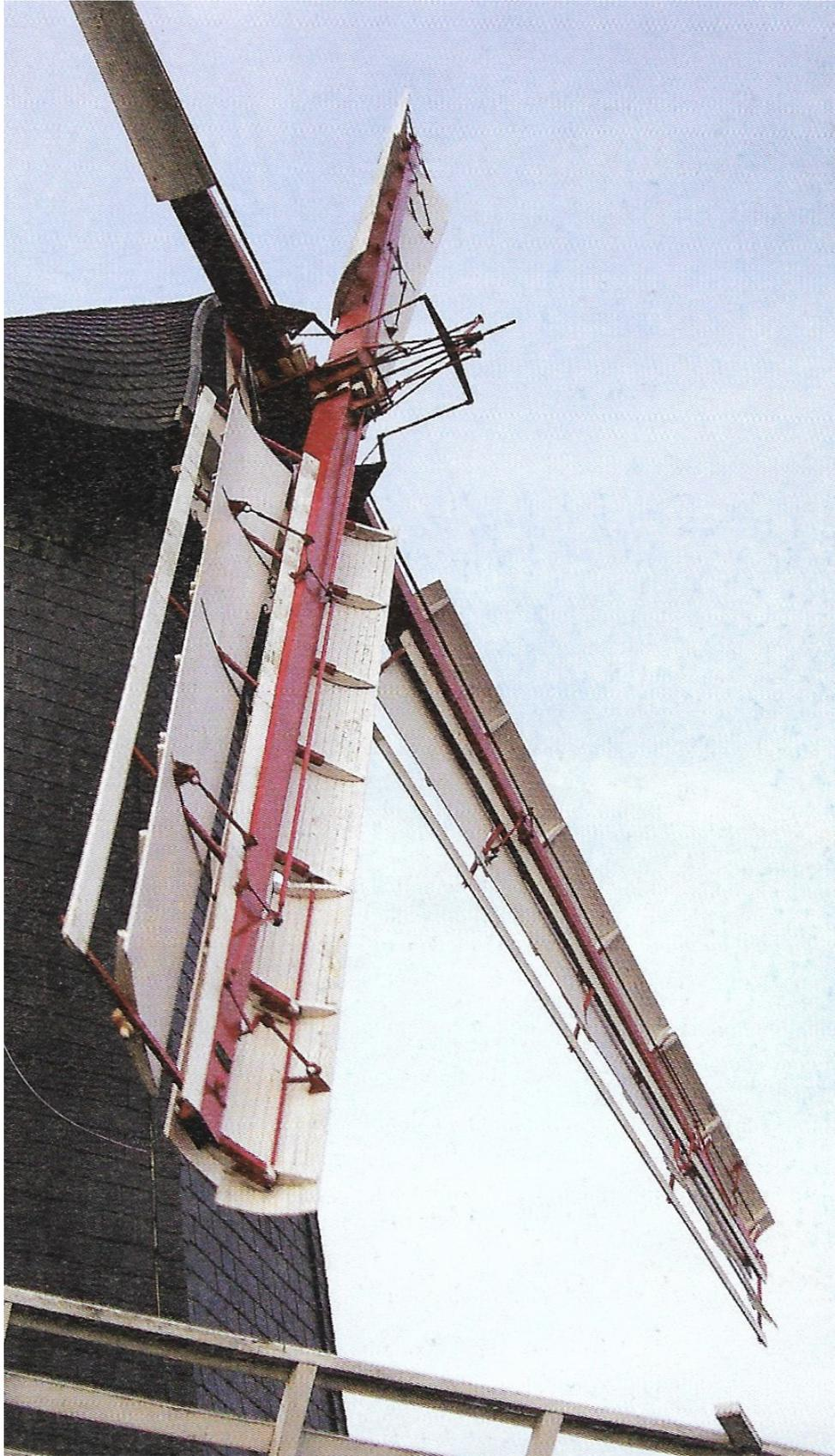
Abb. 68: Ten Have-Flügel der *Bardowicker Mühle* bei Lüneburg.
