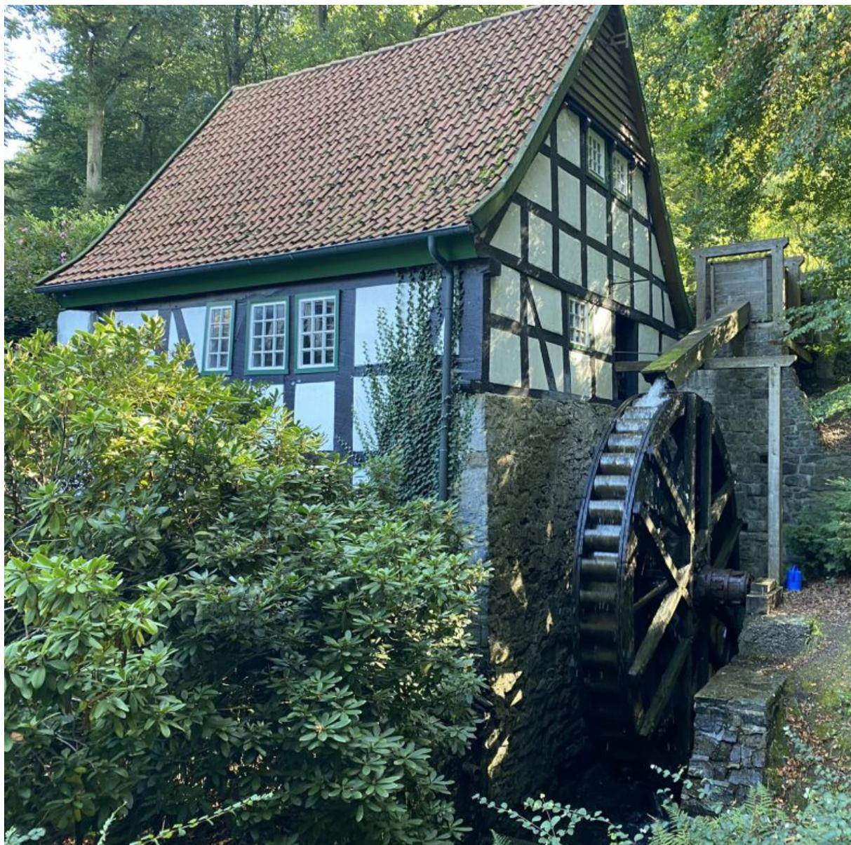
Abb. 34: Wassermühle in Bad Essen mit Oberschlächtigem Wasserrad.
