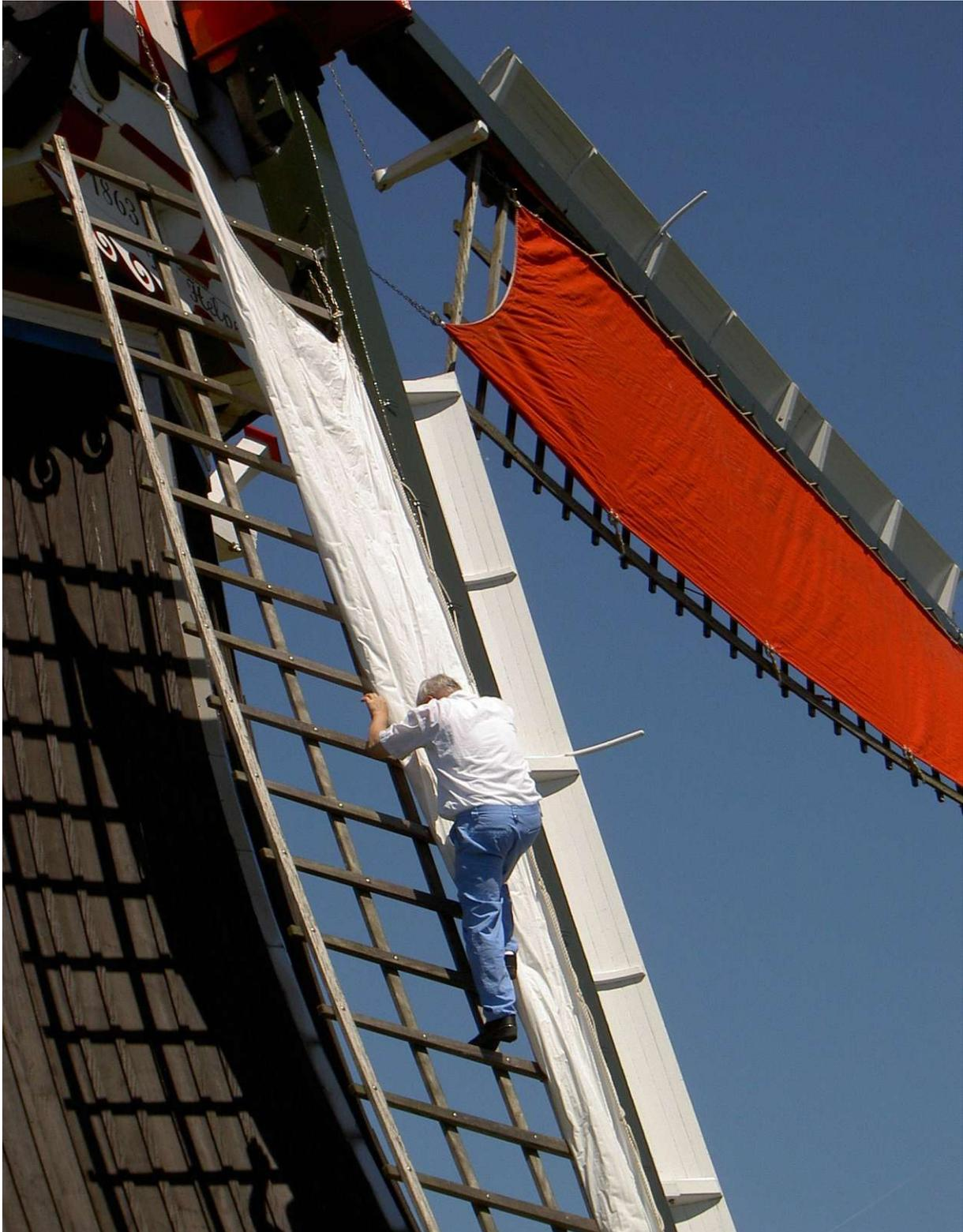
Abb. 64: Mann beim Bespannen eines Segelflügels der *De Helper Mühle* nahe Groningen.
