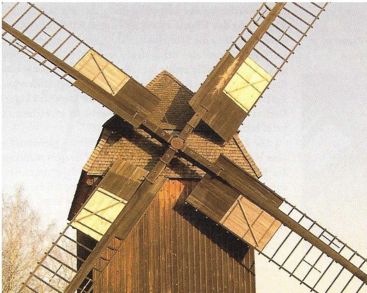
Abb. 65: Türenflügel mit teilweise eingehängten Holzbrettern.
