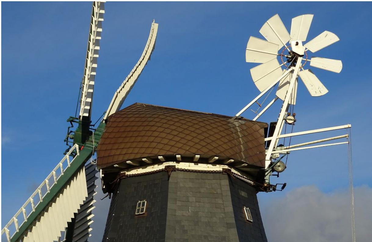
Abb. 74: Dachkappe mit Windrose der Holländerwindmühle in Krokau.
