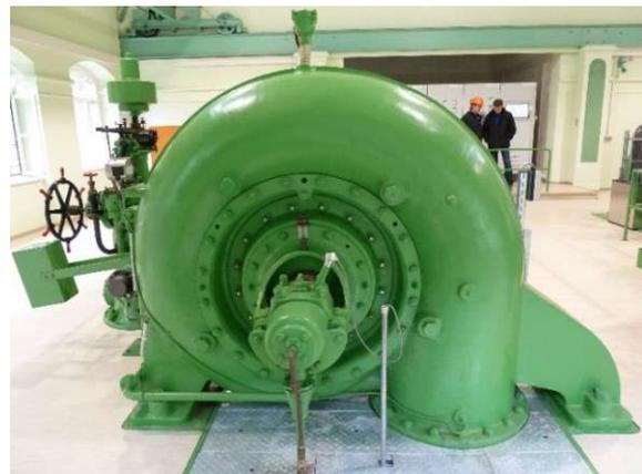
Abb. 55: Gehäuse einer Francis-Spiralturbine.
