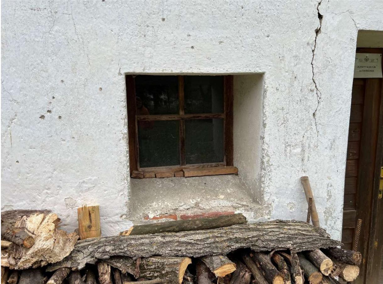
Abb. 139: Abgeschrägtes Parapet beim Fenster neben dem Westeingang der Mühle.
