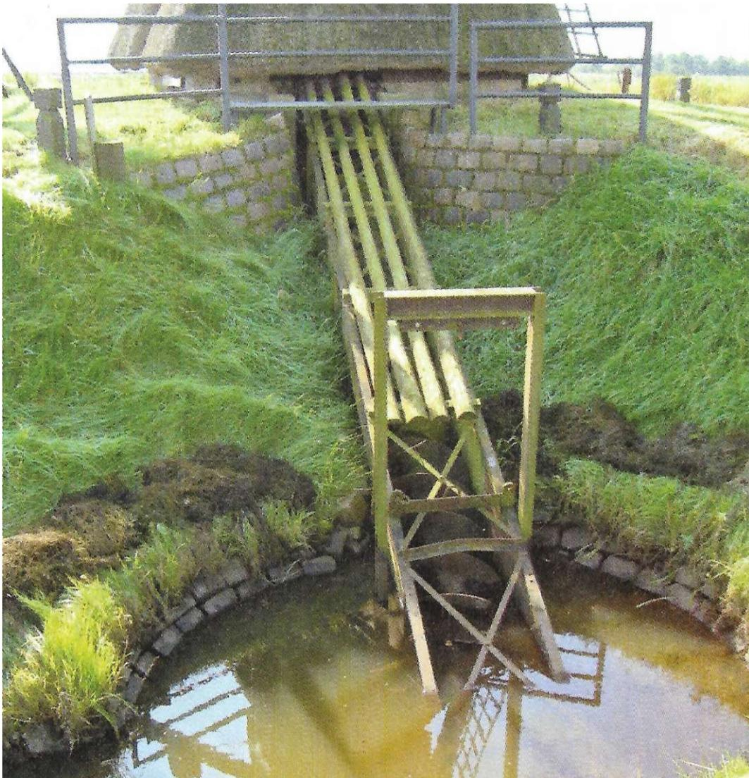
Abb. 87: Archimedische Schraube der Wasserschöpfmühle in Honigfleth.
