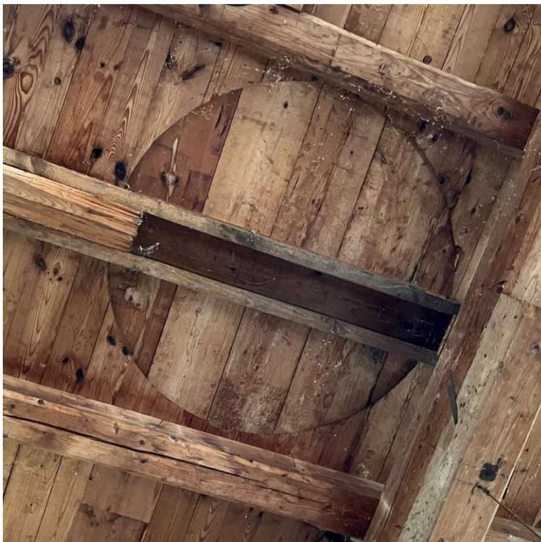
Abb. 137: Eins der drei größeren, runden Deckenlöcher.
