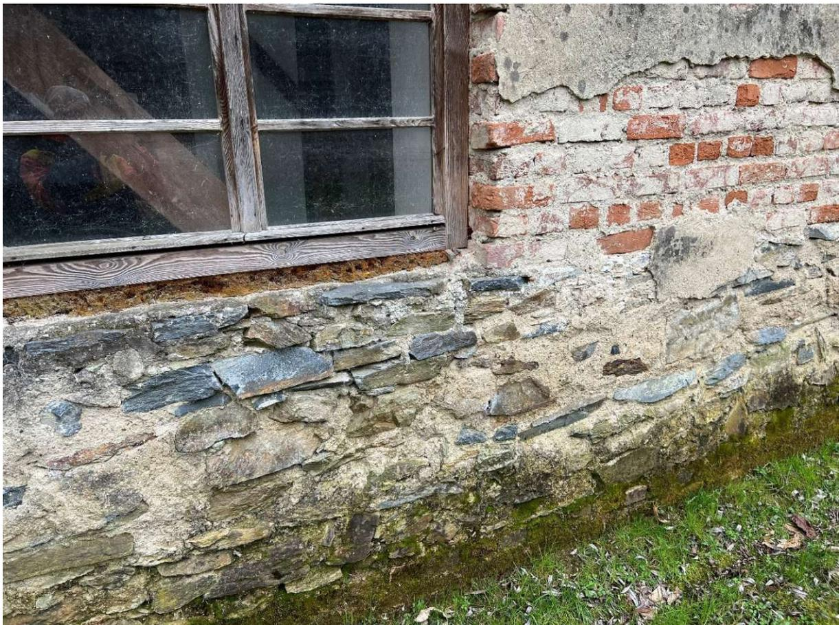
Abb. 152: Sockel aus Schiefer-Gestein. Dieser stammt möglicherweise noch vom Ursprungsbau der Mühle.
