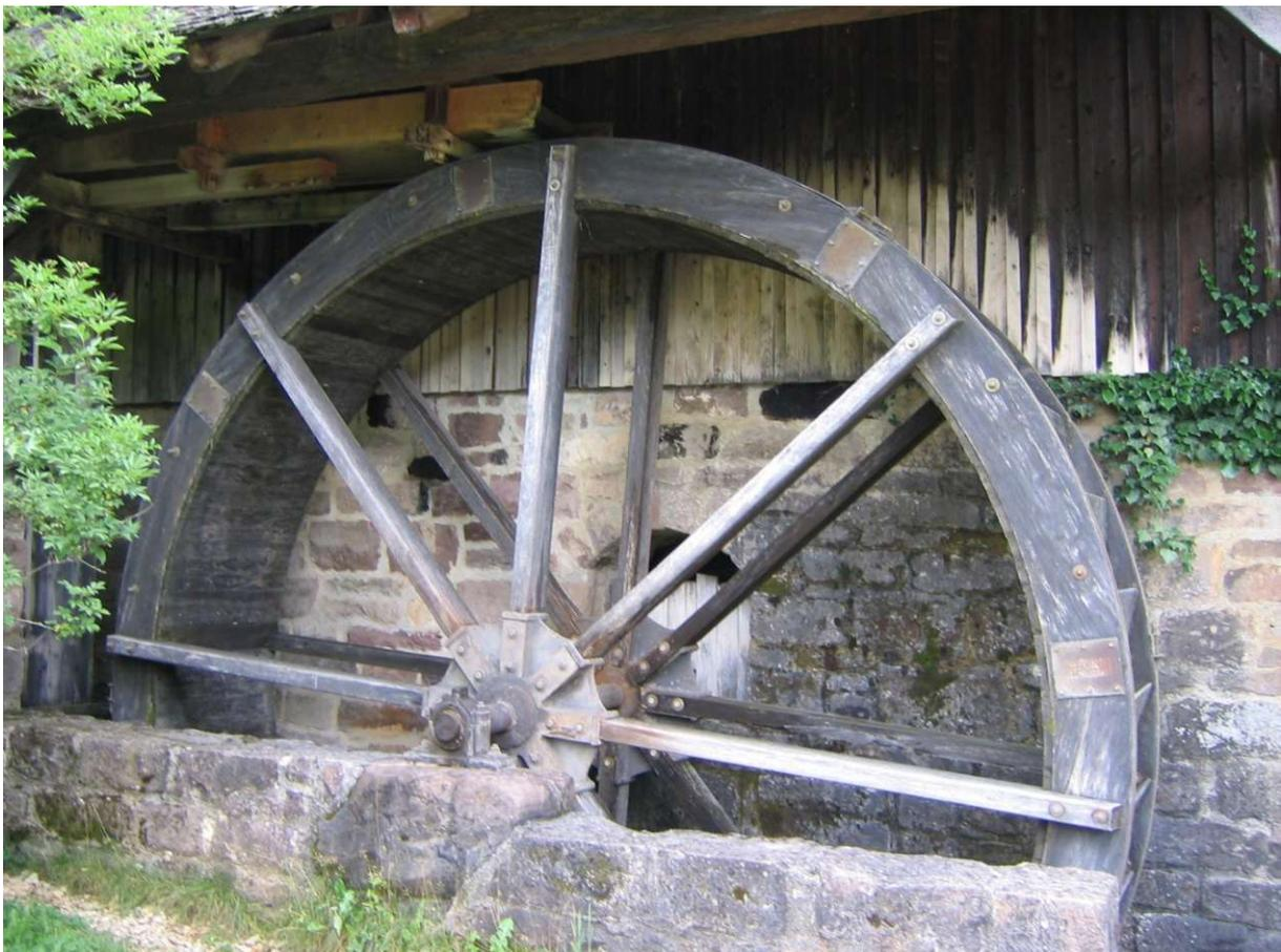
Abb. 29: Oberschlächtiges Wasserrad mit Rosettenverband. Die Mühlgrabenwand bildet das Auflager der Welle.
