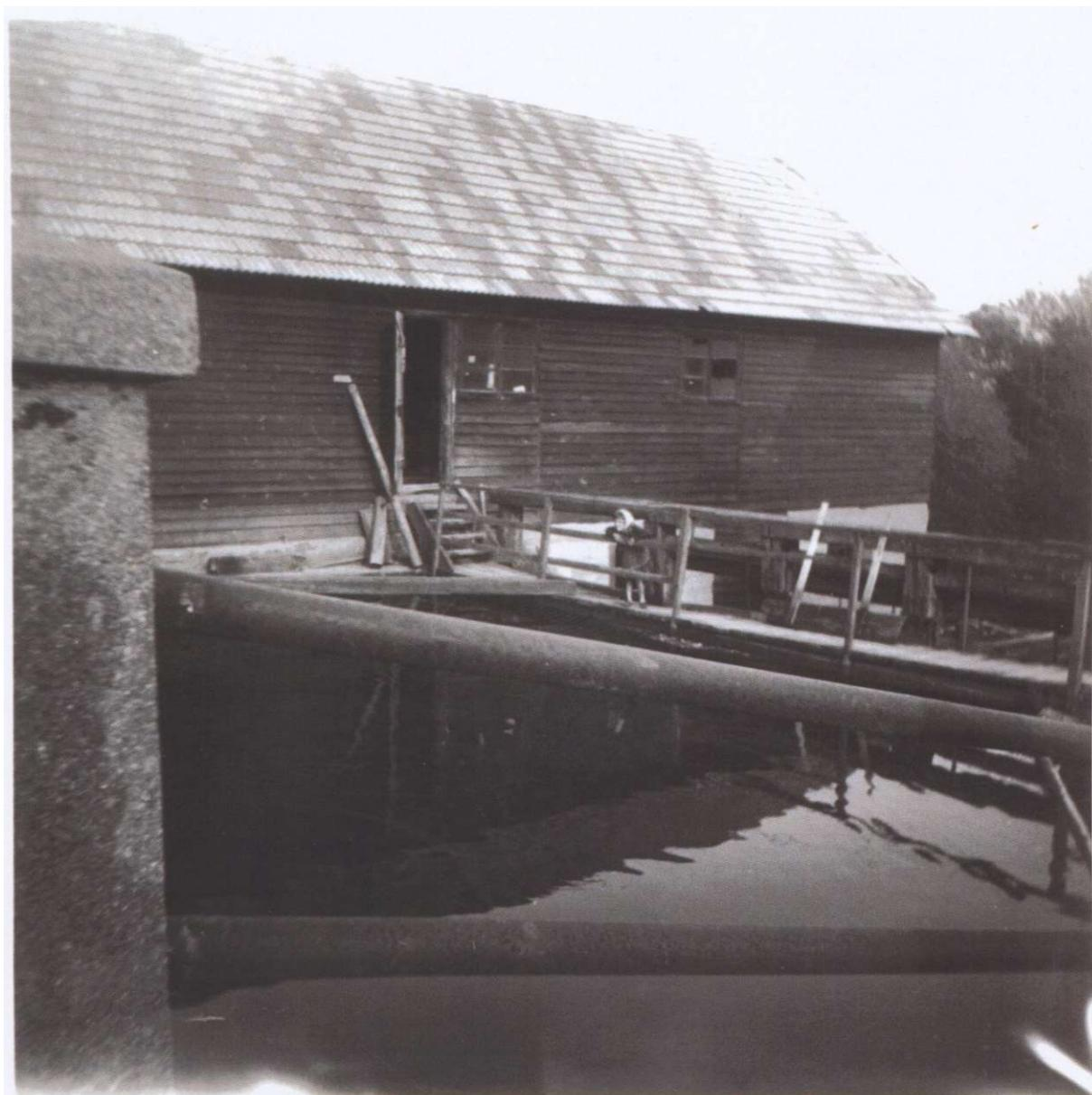
Abb. A10: Historisches Foto vom Sägewerk mitsamt Brücke und Stauteich. Die Brücke diente nicht nur als Verbindung der beiden Gebäude, sie war auch Teil der Stauanlage und war mit beweglichen Schützenwehren ausgestattet. (vgl. Abb. 126)
