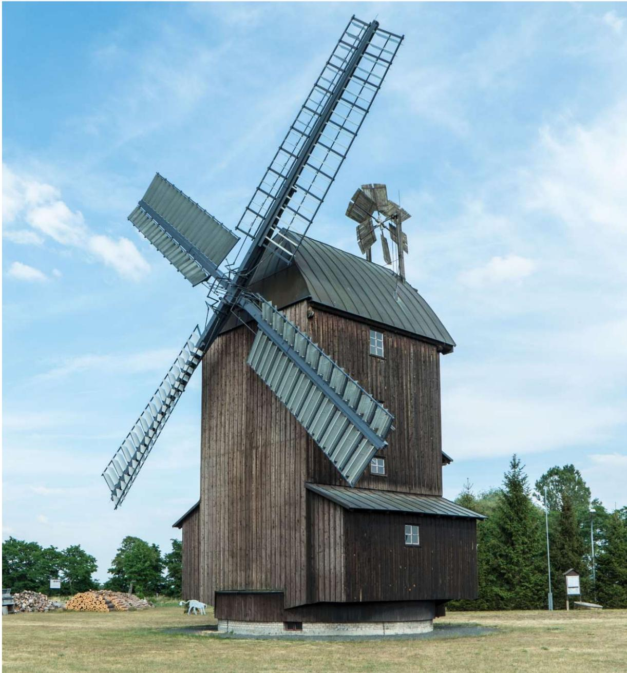
Abb. 71: Paltrockwindmühle in Schönnewalde mit gut erkennbarer Windrose.
