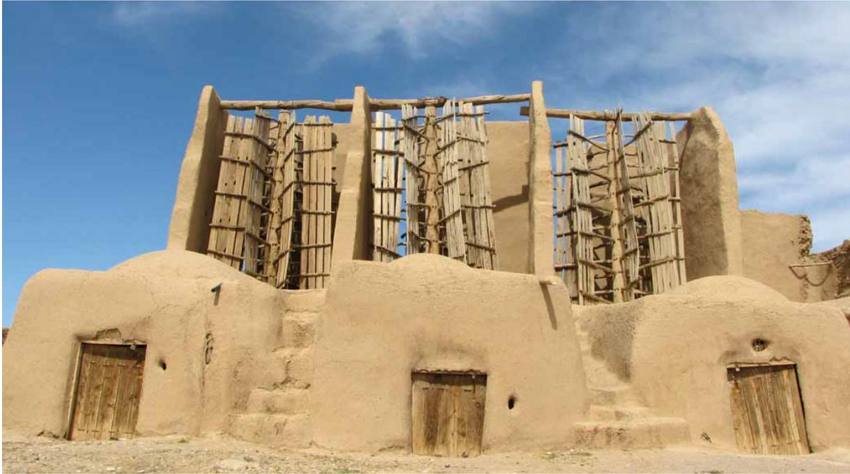
Abb. 14: Persische Windmühle mit horizontalen Windrädern.
