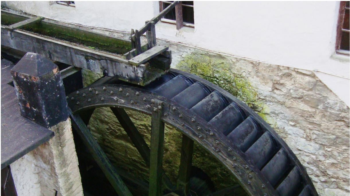
Abb. 36: Zulaufrinne des Oberschlächtigen Wasserrades der Steinmühle in Polleben.
