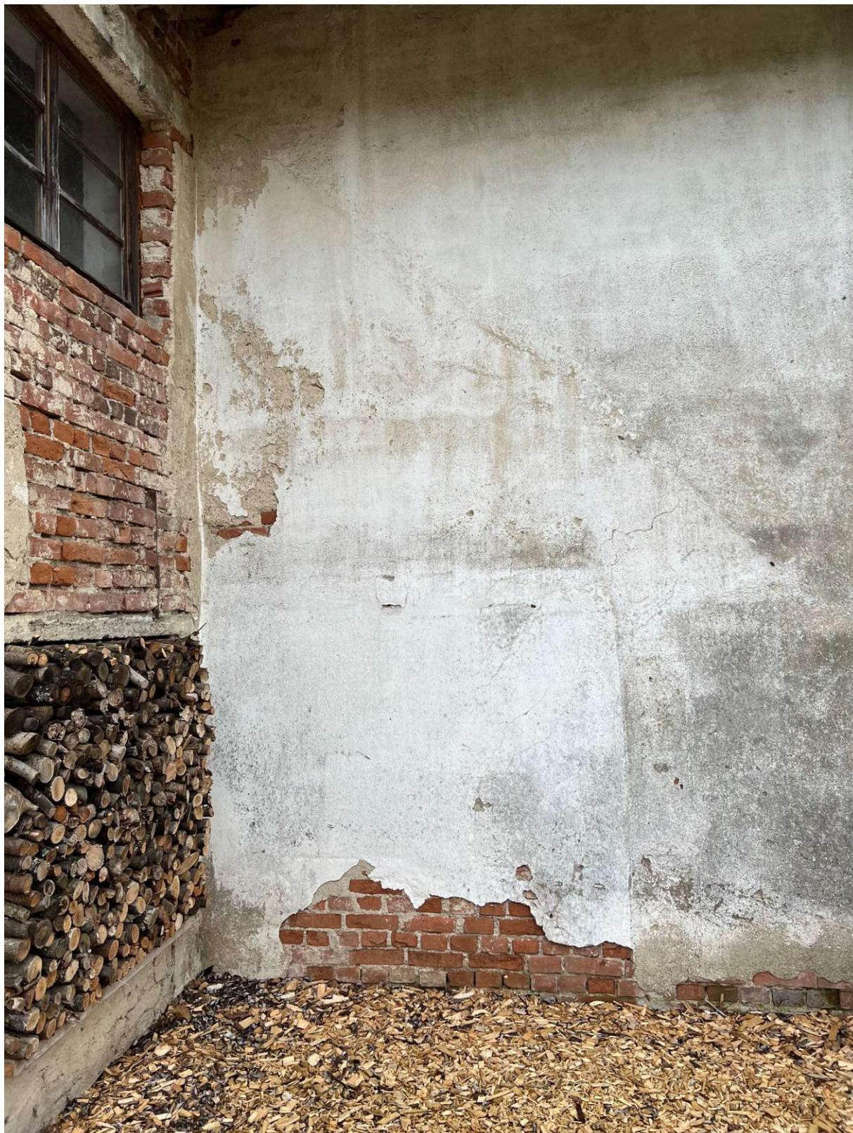
Abb. 121: Nordseite der Mühle heute mit deutlichen Spuren des ehemaligen Zubaus.
