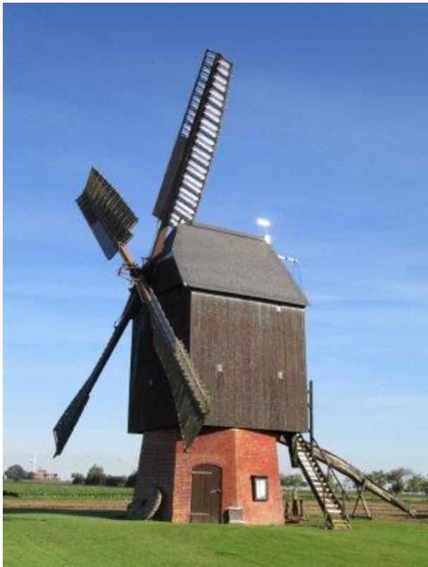
Abb. 72: Rollbockwindmühle in Machtsum mit gut erkennbarem Steert.
