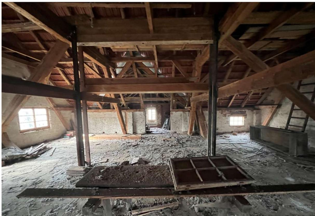
Abb. 163: Blick Richtung Westen im Dachraum der Mühle mit Hänge-Spreng-Konstruktion.
