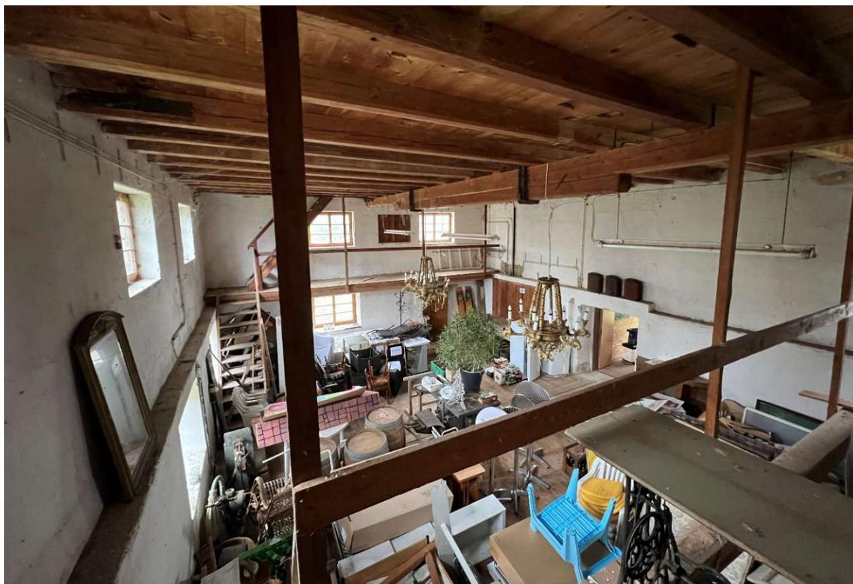
Abb. 161: Blick von nördlicher Galerie in den Hauptraum. Der Wechsel der Mauerstärke ist hier klar erkennbar.
