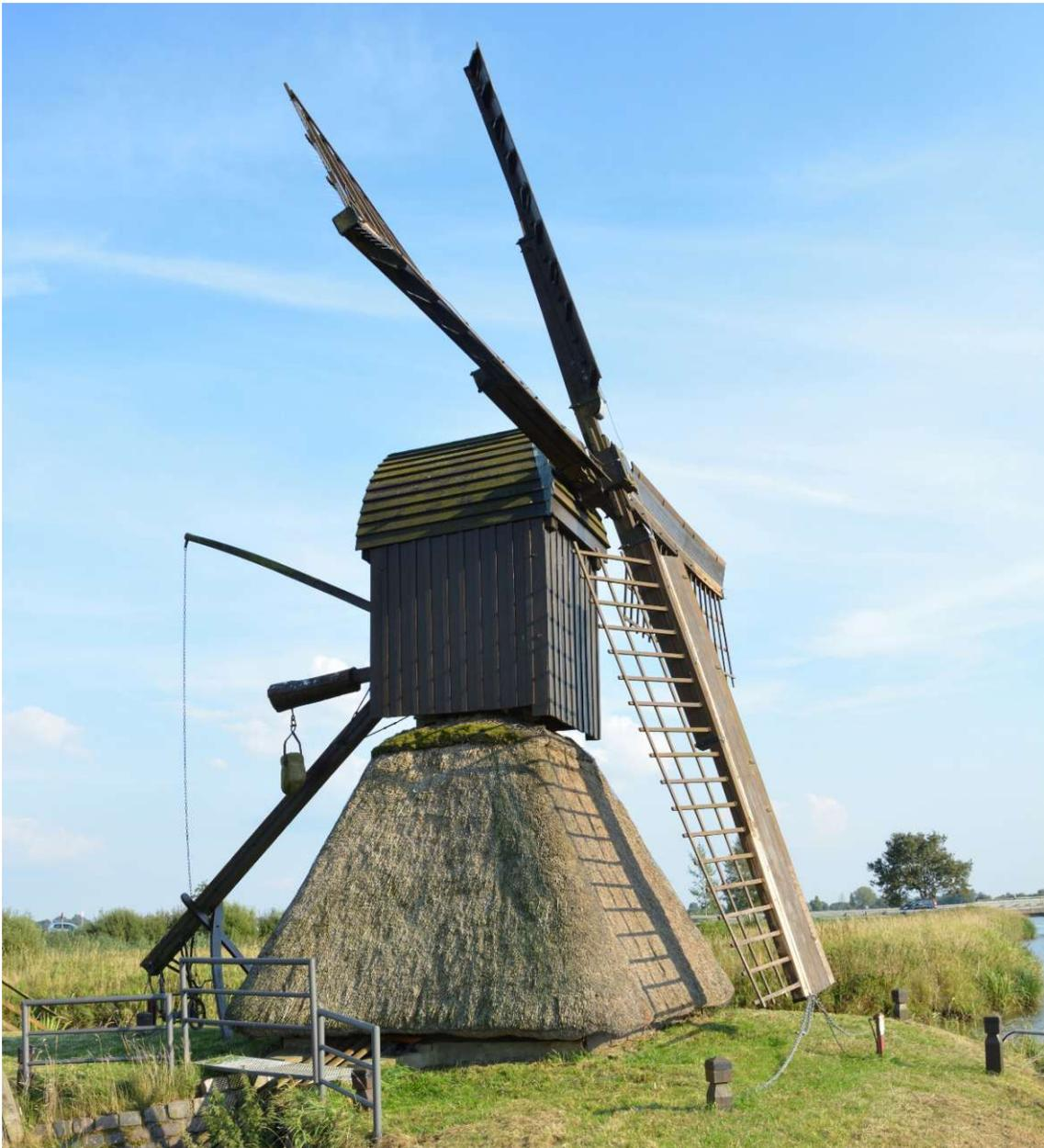
Abb. 70: Kokerwindmühle: Hier die Wasserschöpfmühle in Honigfleth.
