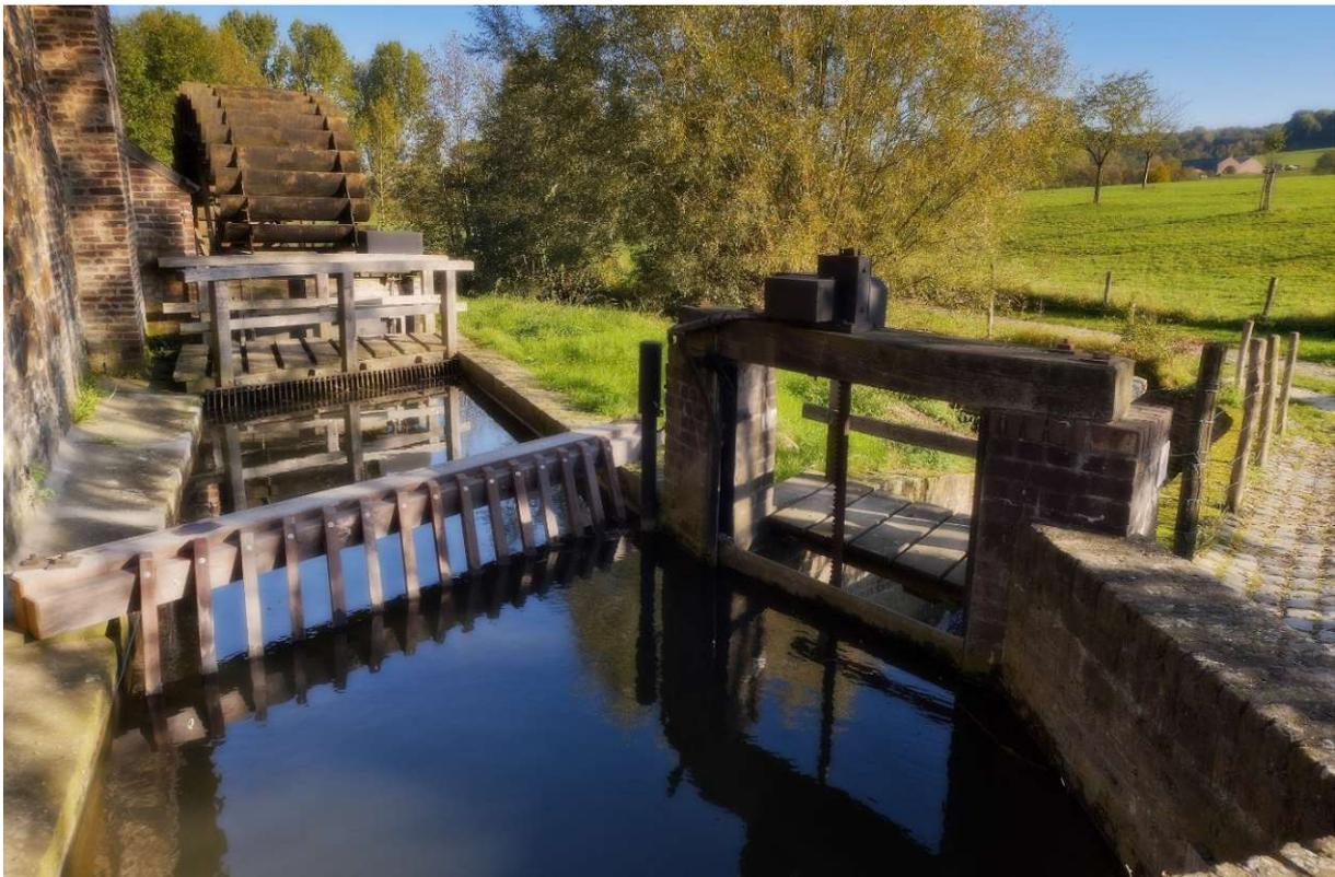
Abb. 28: Wasserbauliche Anlage mit Schützenwehr, Grobrechen und Feinrechen.
