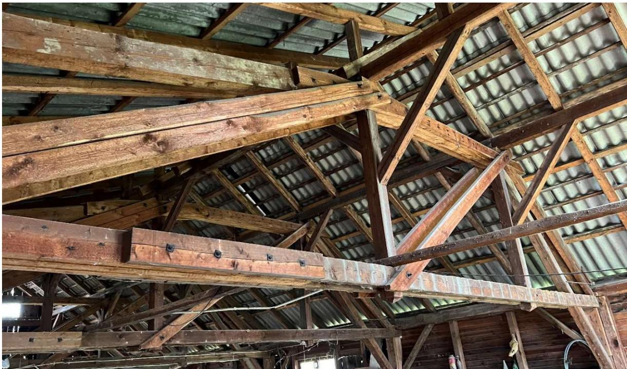
Abb. 131: Erweiterte Holzkonstruktion des Sägewerk-Gebäudes.
