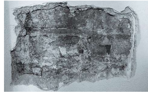
Abb. 92 1. Obergeschoss um 1442, glattgestrichener Fugenmörtel (damals unverputzt)
