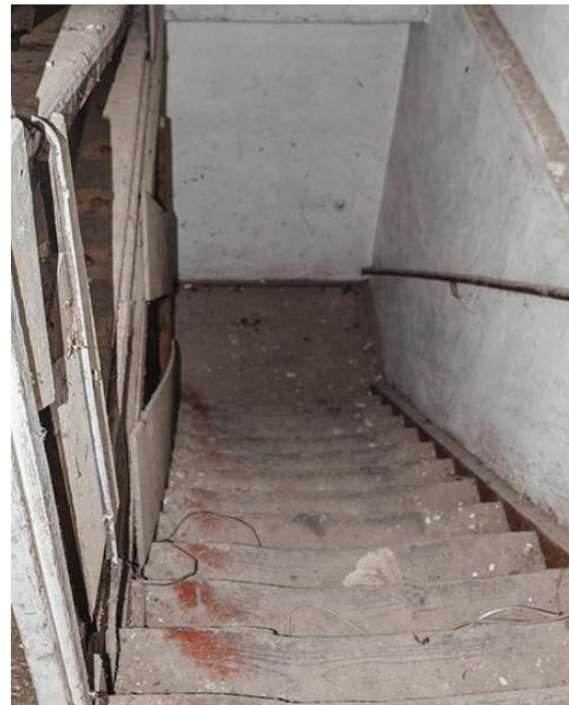
Abb. 140 abgetretene Stufen der barocken Treppe
