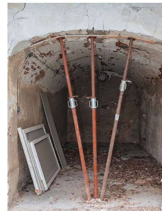
Abb. 86 Stützkonstruktion (hier im Erdgeschoss)
