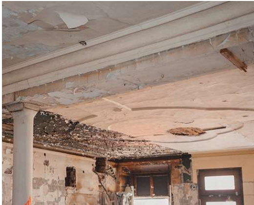
Abb. 41 Stuckdecke im Hauptraum im Erdgeschoss
