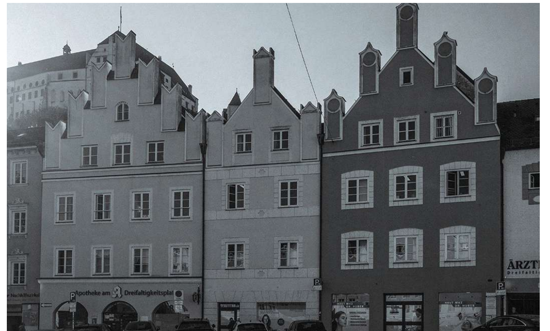
Abb. 15 Die nach Abbruch an dessen Stelle errichteten Giebelhäuser
