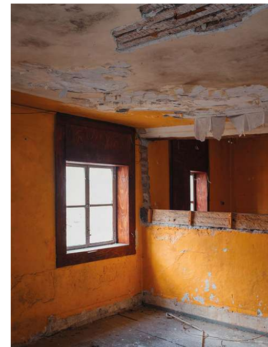
Abb. 57 Kreuzstockfenster mit verkleidetem Oberlicht
