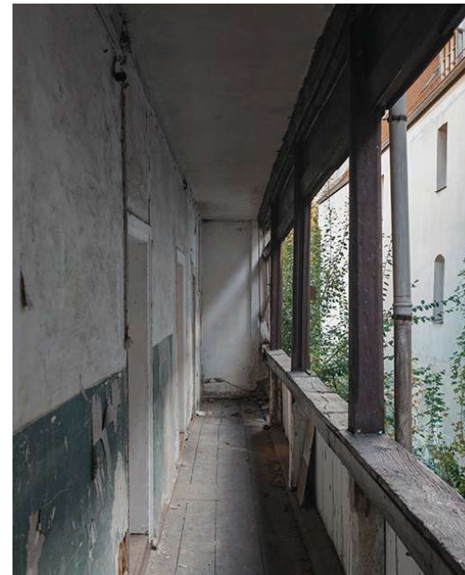
Abb. 64 Altane im 1. Obergeschoss
