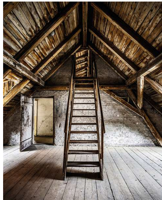
Abb. 73 Dachraum im Rückgebäude mit einer Treppe, die in das Dach des Vordergebäudes führt
