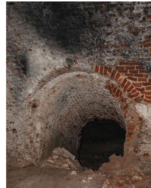
Abb. 83 Gewölbegang in weiteren Kellerraum
