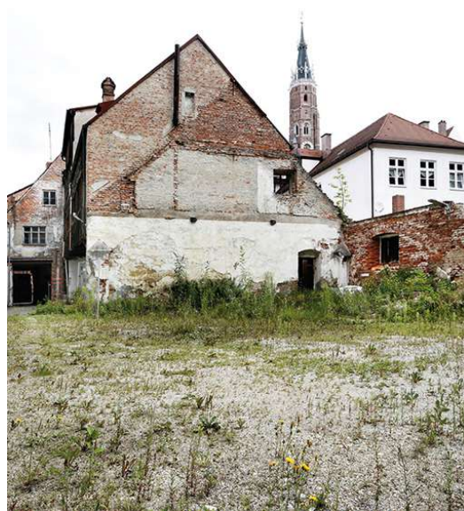
Abb. 63 Südfassade des Rückgebäudes
