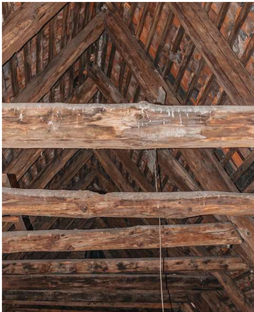
Abb. 136 Mittelalterliche Sparrendachkonstruktion
