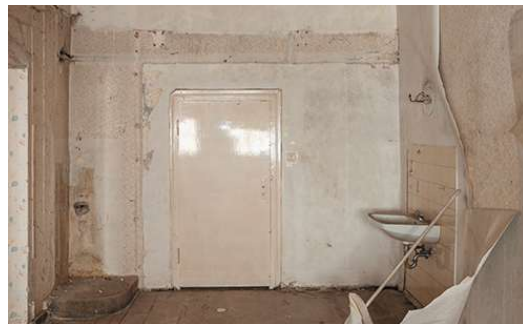
Abb. 71 Zimmer mit Waschbecken und Tür zur Altane hin
