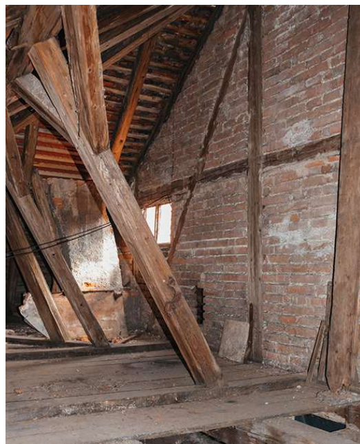
Abb. 75 Fachwerkwand des Walmdaches
