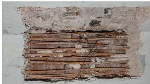
Abb. 47 Schilfrohr als Putzträger
