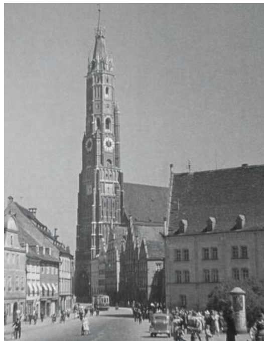
Abb. 13 Blick Richtung Martinsturm mit Straßenbahn davor
