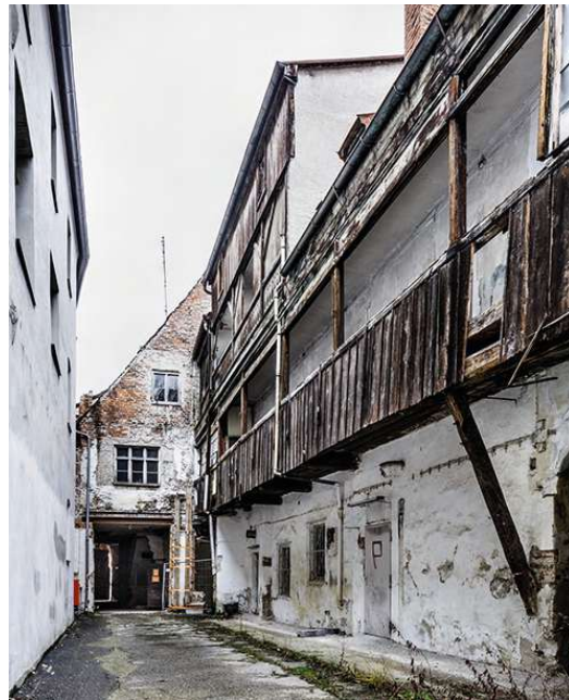
Abb. 62 Rückgebäude mit Altanen
