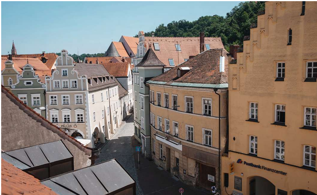
Abb. 39 Gebäude Frontfassade mit Walmdach von oben
