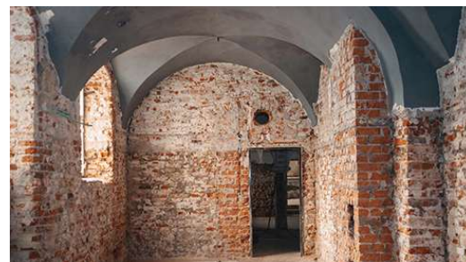
Abb. 43 Gewölbe im Durchgang zum Rückgebäude
