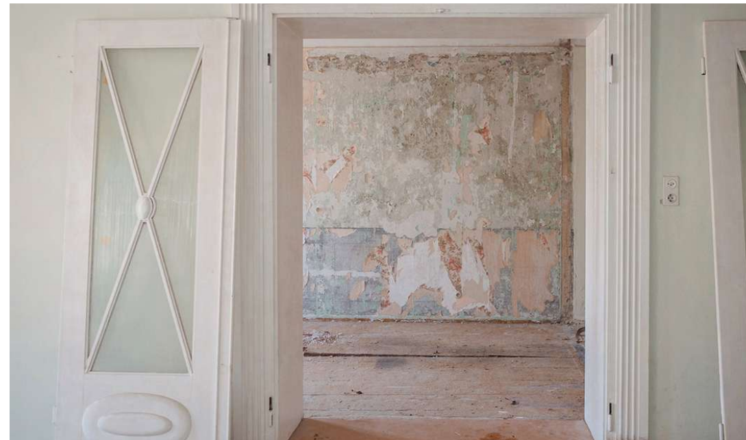
Abb. 51 Doppelflügelige Tür mit Glasfeldern und Diagonalsprossen
