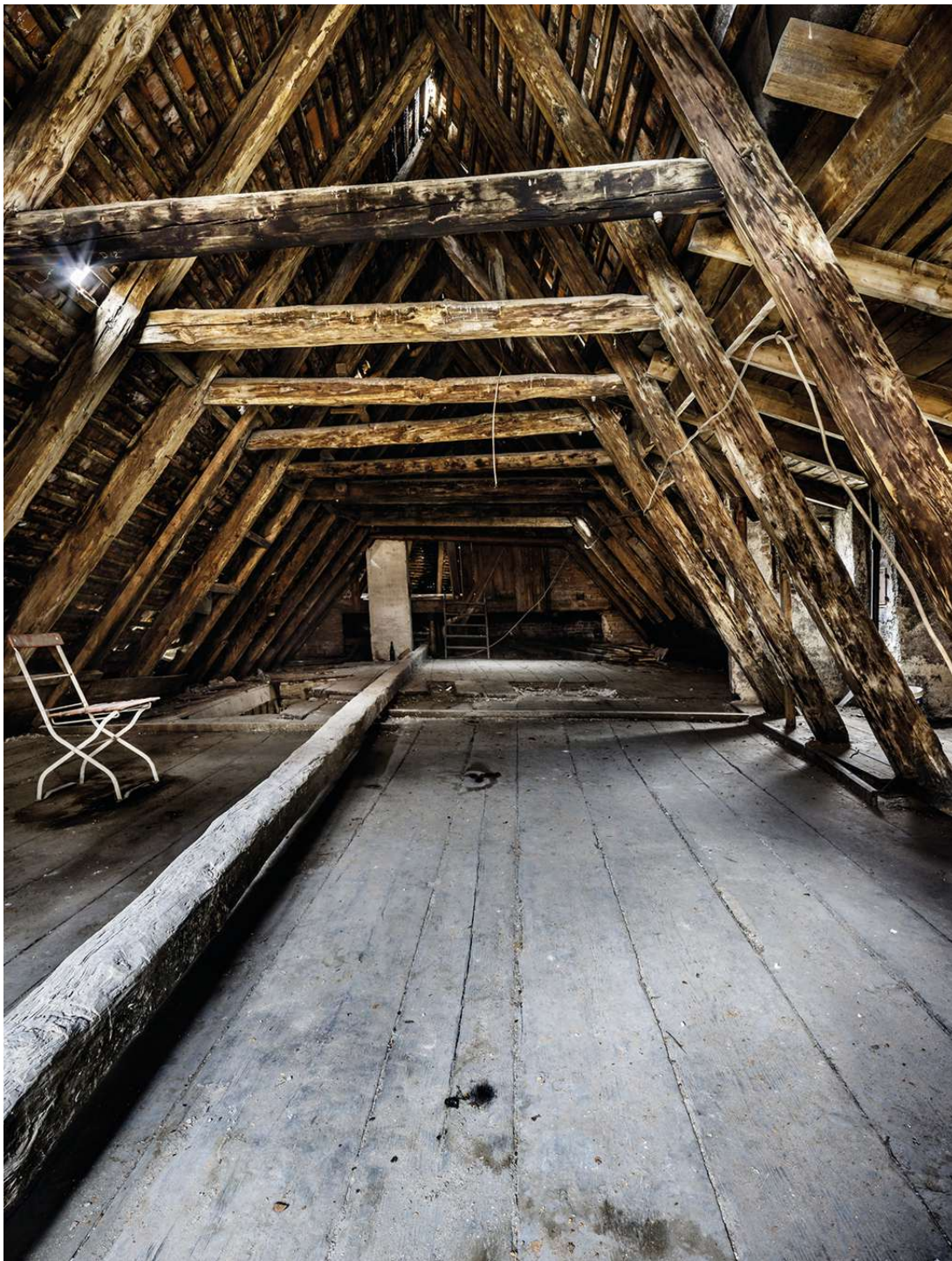
Abb. 78 Mittelalterlicher Dachbereich mit Blick in den Firstbereich der Sparren; nach Norden
