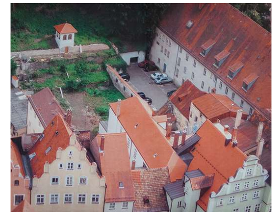
Abb. 125 Hinterer Grundstückteil mit neuen Stellplätzen an Stelle der ehem. Stallungen, vermutlich um 2000
