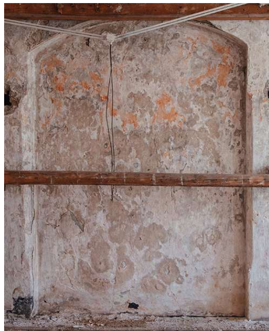
Abb. 139 Segmentbogige Nische in der Westwand
