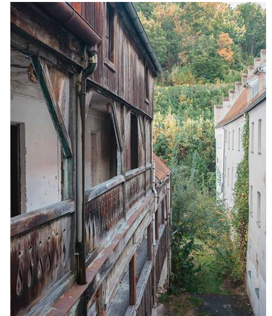
Abb. 66 Altanen am Rückgebäude, im 2. Obergeschoss mit dekorativer Ausfräsung
