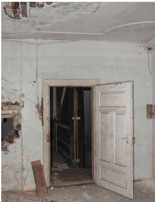
Abb. 46 Kassettierte Vierfeldertür Richtung Treppe
