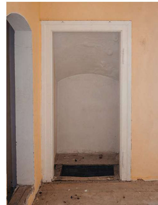
Abb. 53 Zugesetzter Verbindungsgang zur Nr. 180
