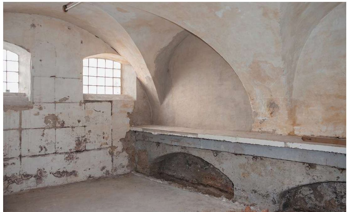
Abb. 69 Gewölberaum mit segmentbogig ausgebildeten Fenstern und massiver Arbeitsfläche
