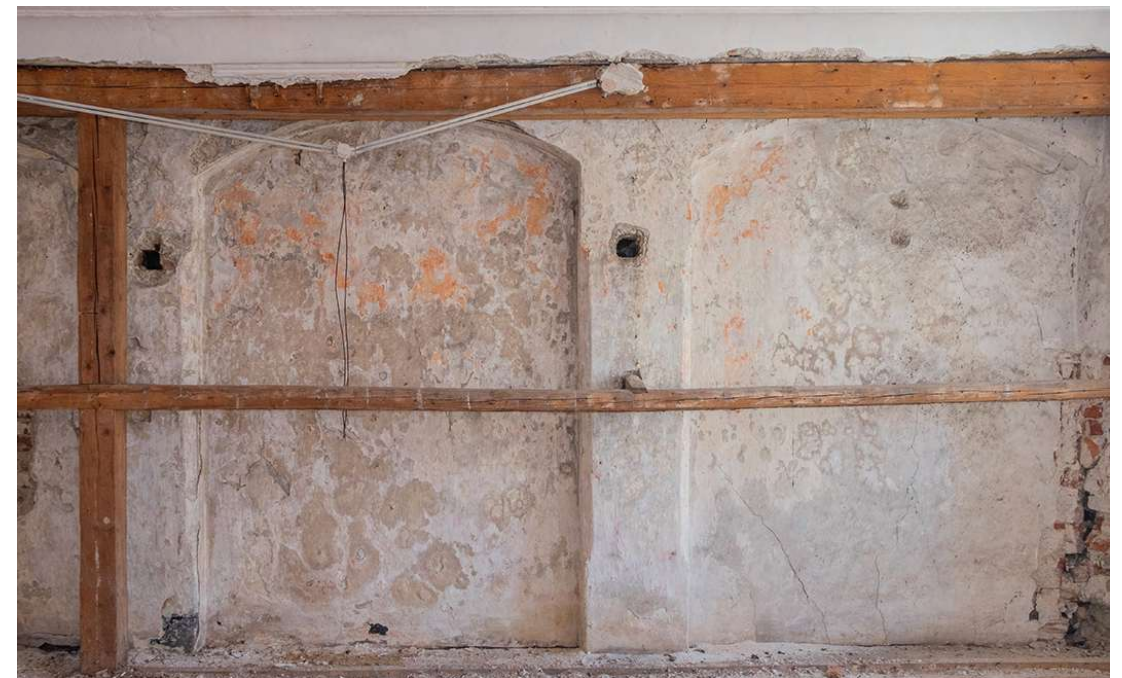
Abb. 49 Westwand mit segmentbogigen Nischen
