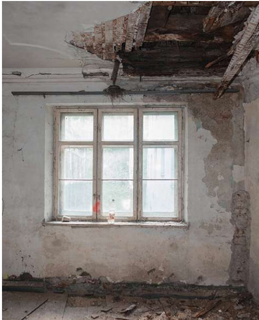
Abb. 45 Zimmer mit Rahmenstuckdecke Richtung Innenhof
