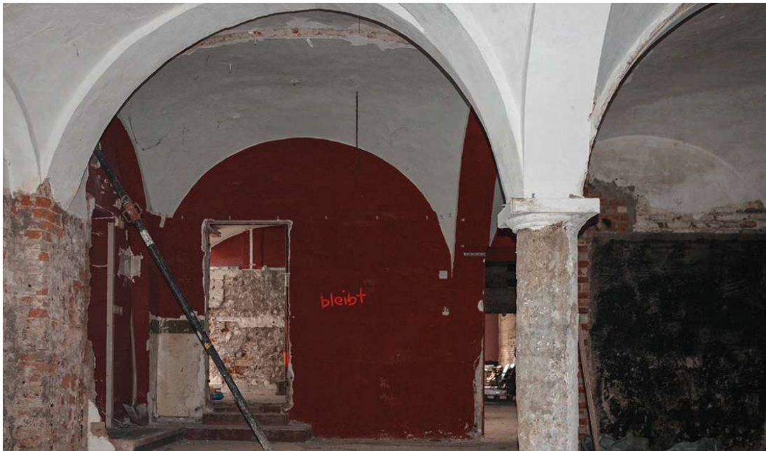
Abb. 67 Gewölberaum mit zentraler Sandsteinsäule
