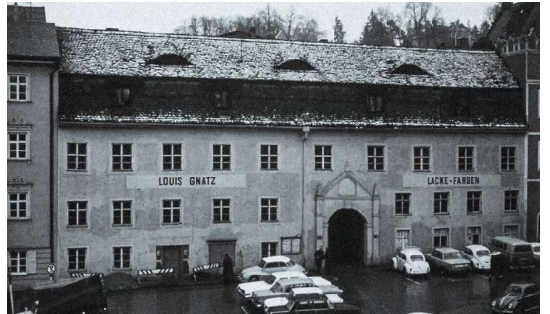
Abb. 14 Teil des ehemaligen Verbindungsgebäudes zwischen der Dreifaltigkeitskirche und Haus Nr. 175; hier Lackfabrik L. Gnatz
