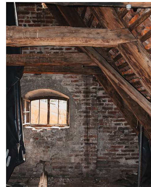
Abb. 76 Bauzeitliche südliche Giebelwand u. Hahnenbalken
