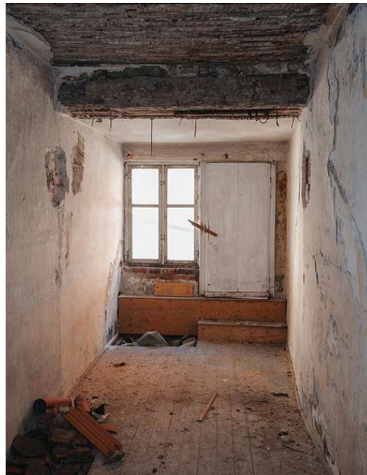
Abb. 59 Doppelflügeliges Fenster u. Brettertür zum Dach
