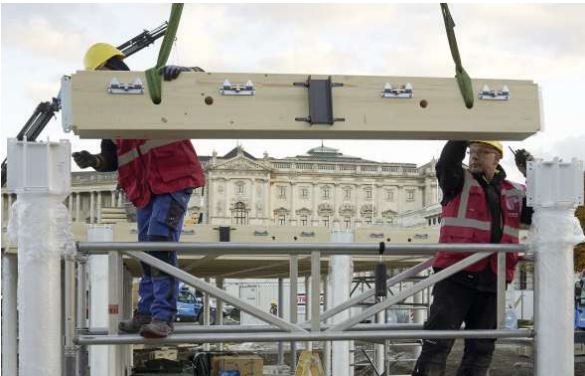
Abb. 25: Versetzen eines Trägers, Christian Leitner, 2016
