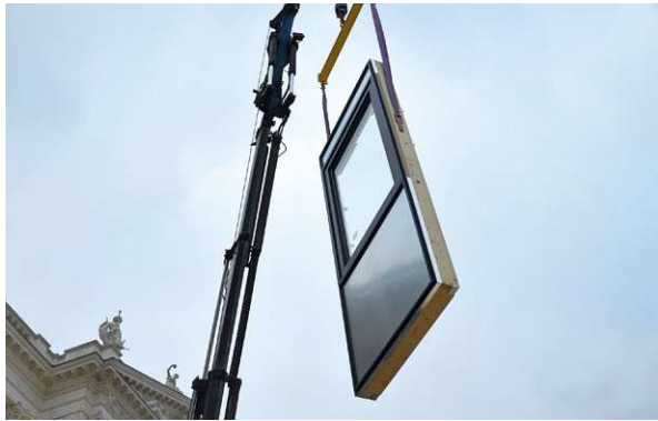
Abb. 35: Versetzen eines Fassadenelements, Johannes Zinner, 2016
