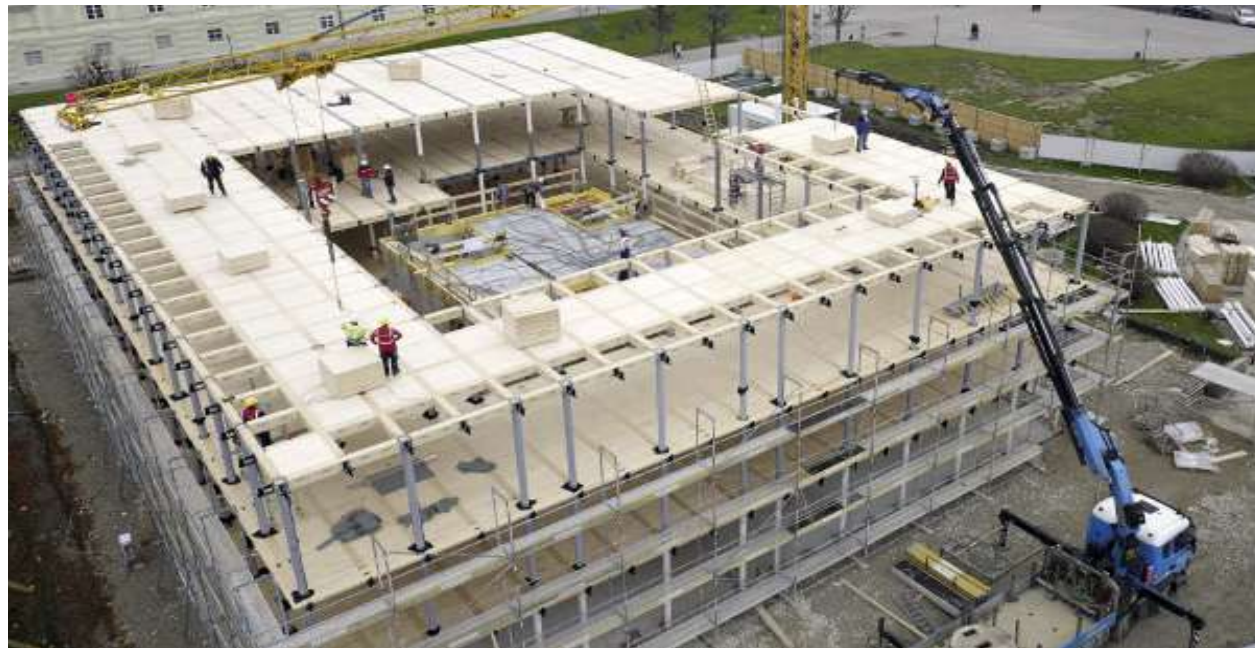
Abb. 33: Krane heben Deckenfelder in Paketen auf die herzustellende Decke, Christian Leitner, 2016
