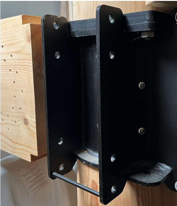
Abb. 26: Knotenanschluss Stütze, Florian Schreiber, 17.07.2025
