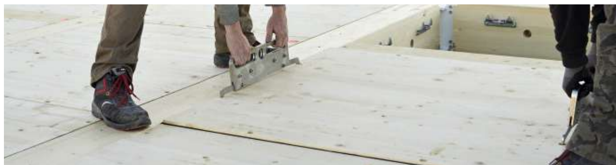
Abb. 34: Versetzen eines Deckenfelds, Christian Leitner, 2016
