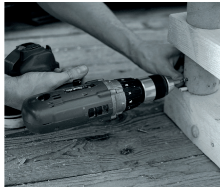
ABB.89: STÜTZEN AN VERBINDUNGSTÜCK FEST SCHRAUBEN
