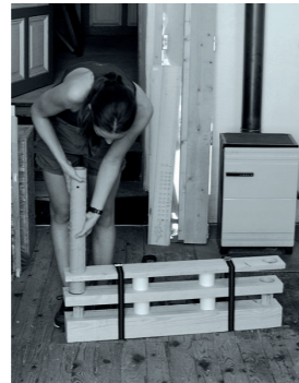
ABB.86: STÜTZE EINSTECKEN
