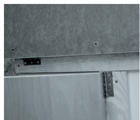
ABB.101: PLATTE AN HOLZLEISTE
