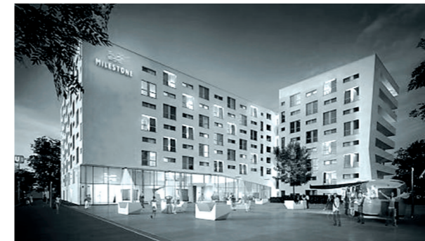
ABB.30: AUSSENANSICHT MILESTONE STUDENTENWOHNHEIM
