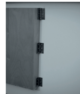
ABB.95: SCHARNIERE BEFESTIGT
