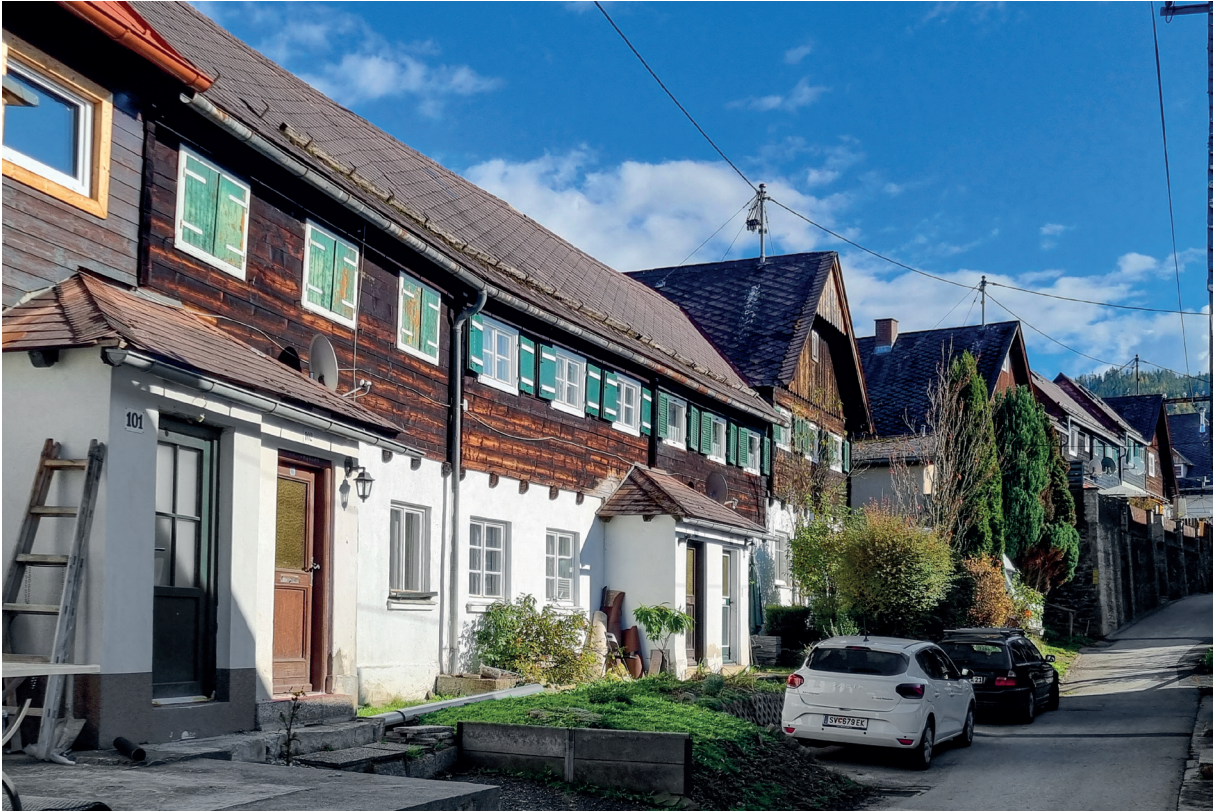
2. Hüttenberg, Knappensiedlung, Hauszeile mit bauzeitlichen Fenster- und Türkonstruktionen sowie nachträglich veränderten Ausführungsarten, 2024
