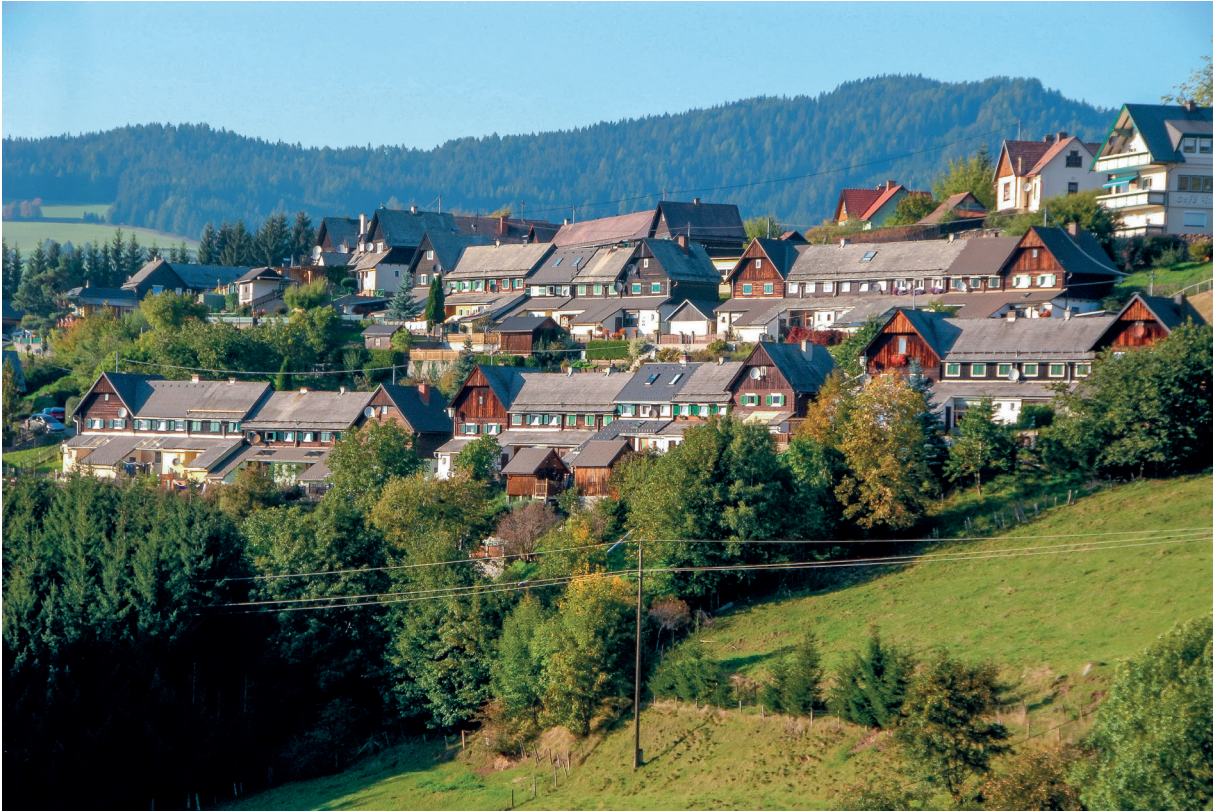
1. Hüttenberg, Knappensiedlung, Topographie und Gesamtansicht, 2007
