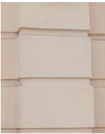
Streifenrustifi- zierung verputzt mit Pilaster
