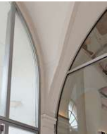
Deckengewölbe mit Glaseinbauten
