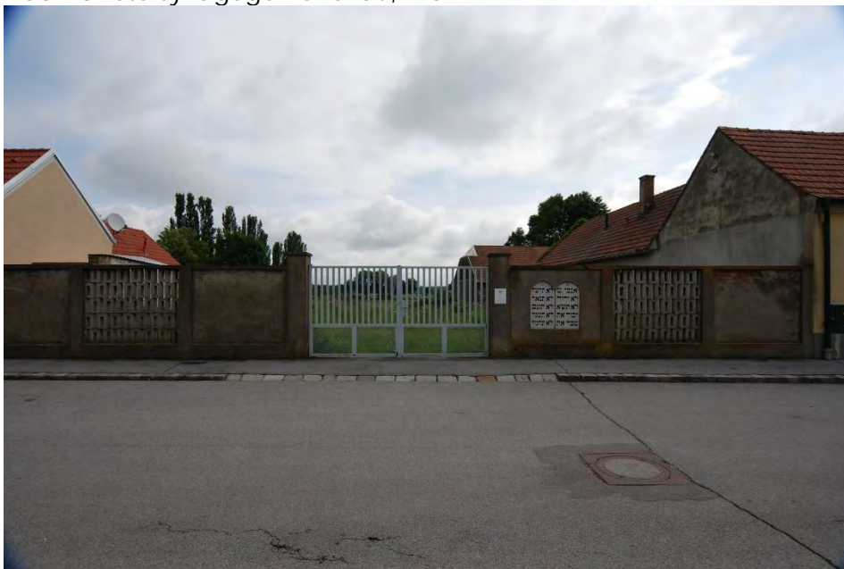
Abb. 99 Foto Hohenau Dammgasse, 2010
