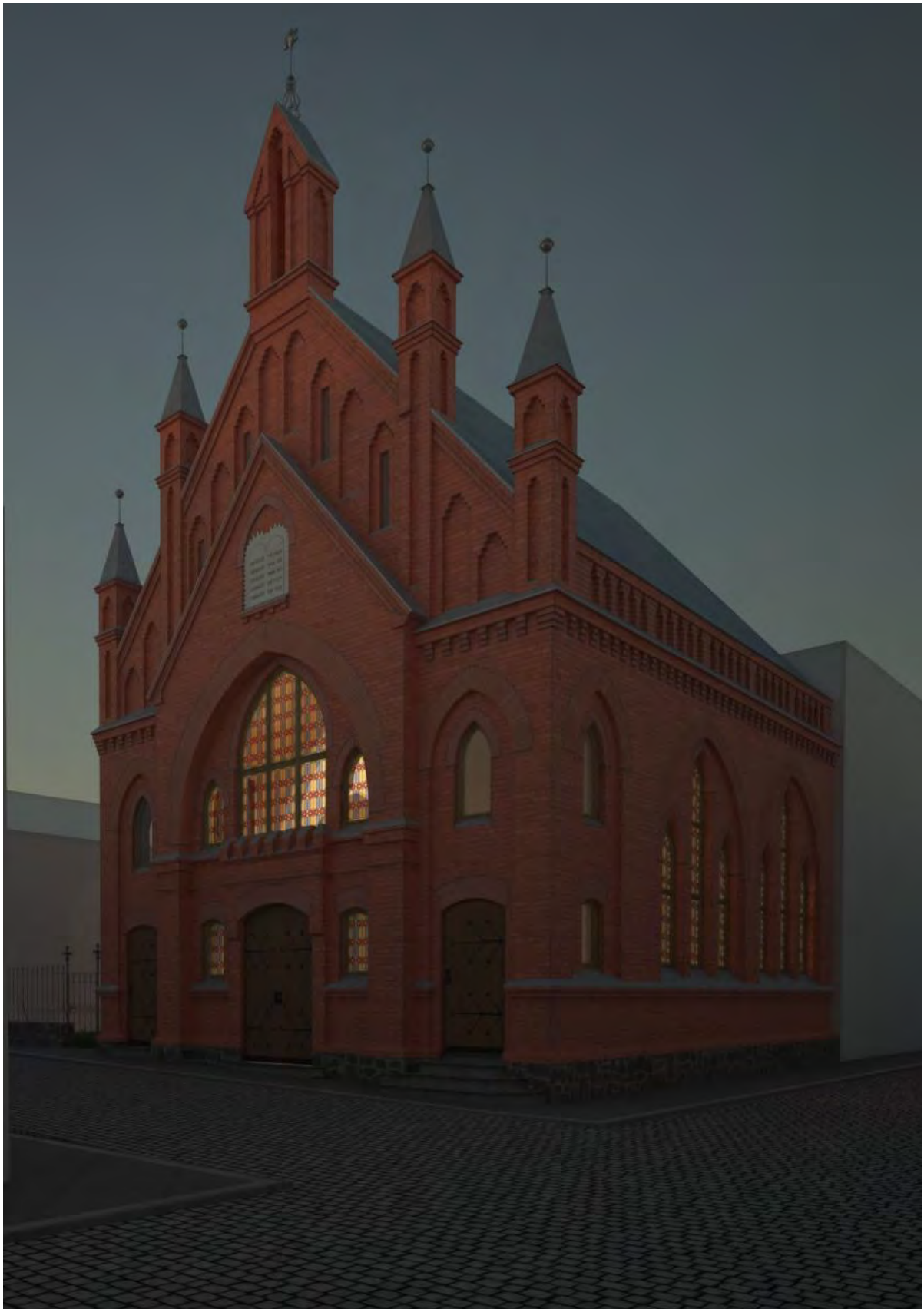
Abb. 95 Haupteingang bei Nacht
