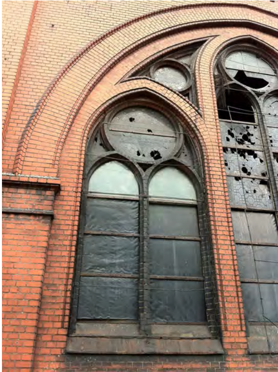
Abb. 47 Fenster in Gleiwitz
