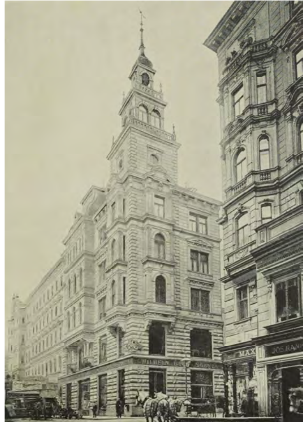
Abb. 10 Geschäfts- und Wohnhaus, Beck + Söhne, Langegasse
