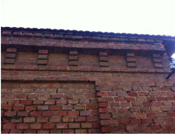
Abb. 73 Referenz Hauptgesimse Mayerling, 2014
